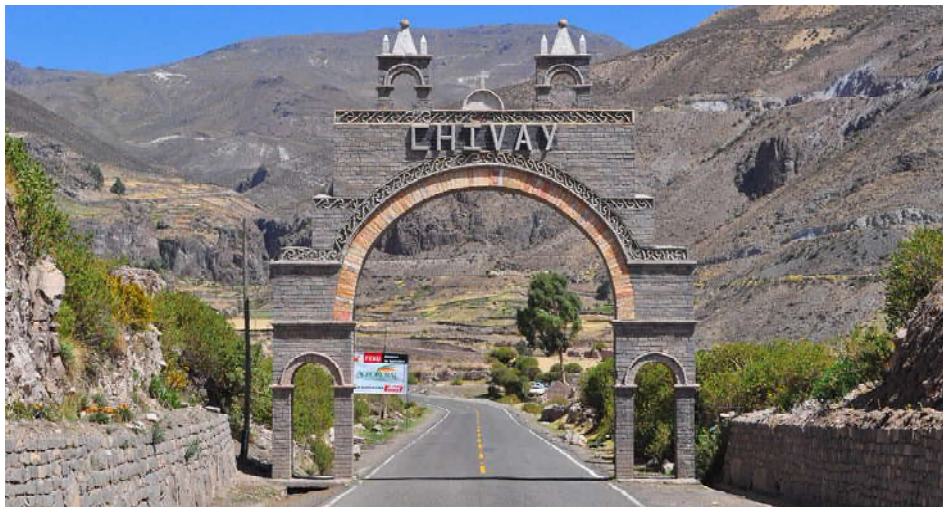
Fotografía 11.12 Acceso vial al Valle del Colca
