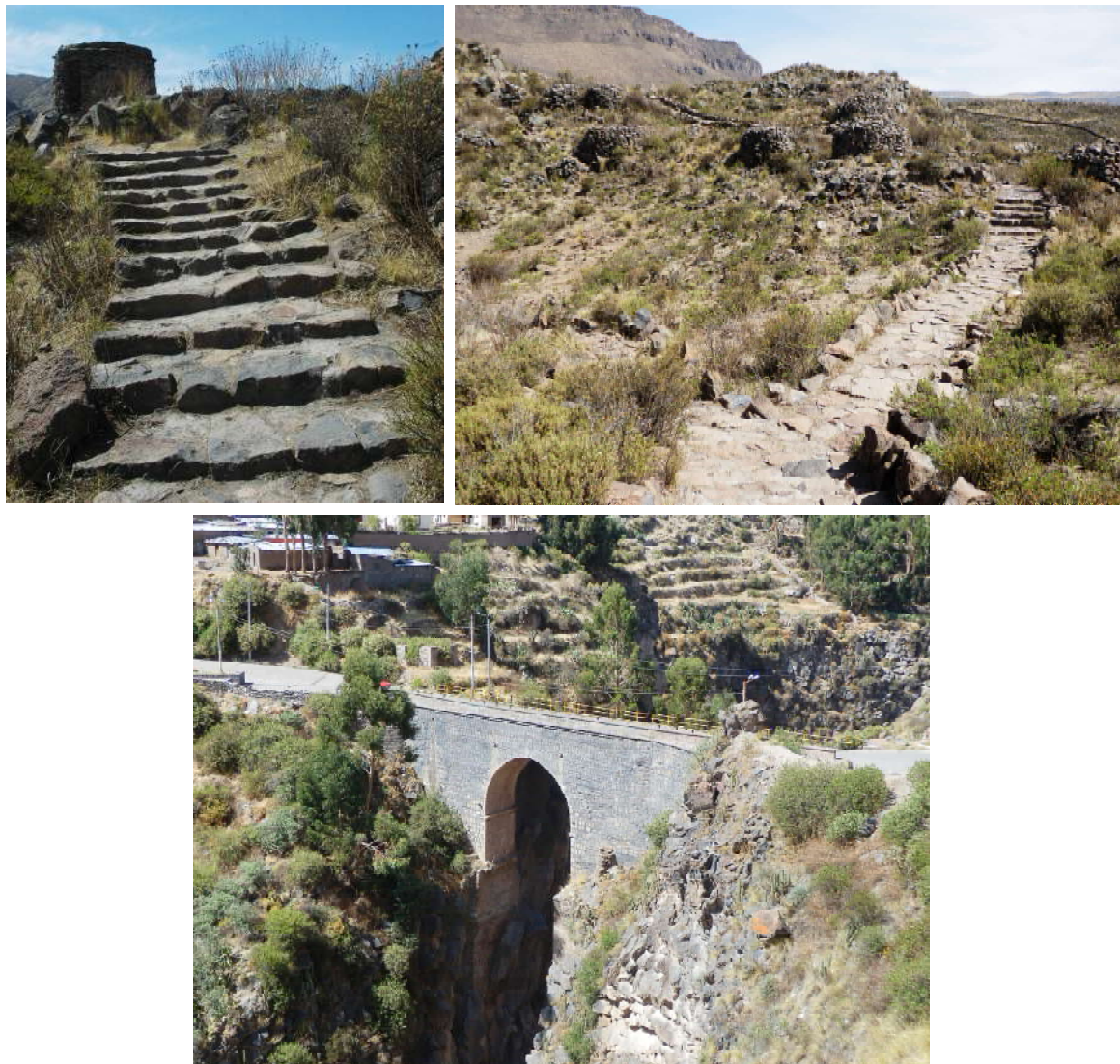
Fotografía 11.13 Caminos empedrados que acceden a lugares turísticos y puente El Inca, cerca de Chivay. Resaltan el uso del recurso natural con que se cuenta: rocas volcánicas.
