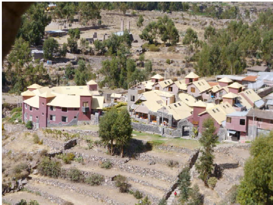
Fotografía 11.4 Infraestructura hotelera, construida en las márgenes del valle del Colca entre Chivay y Yanque; tratando de mantener la armonía con el paisaje natural circundante.
