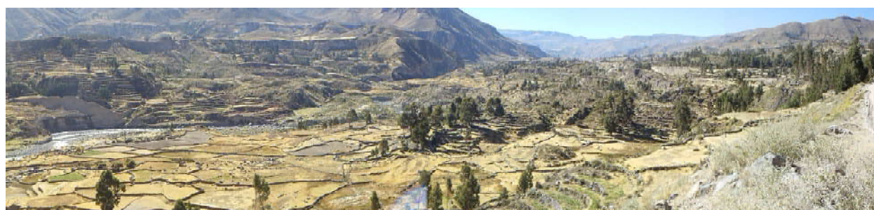
Fotografía 11.56 Deslizamientos de Maca (derecha) y Lari (izquierda), vista aguas arriba.
