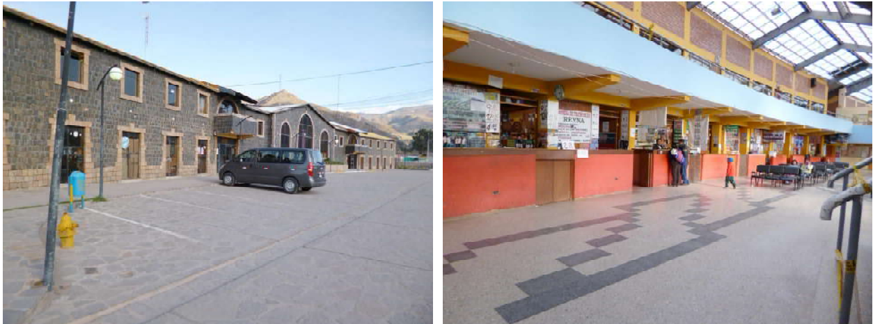
Fotografía 11.8 Terminal Terrestre en Chivay: Vistas externa e interna
