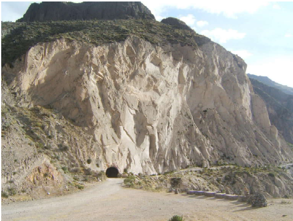
Fotografía 4.18 Túnel en el cerro Blanco, carretera entre Maca y Pinchollo que atraviesa secuencias de tobas del complejo volcánico Mismi.
