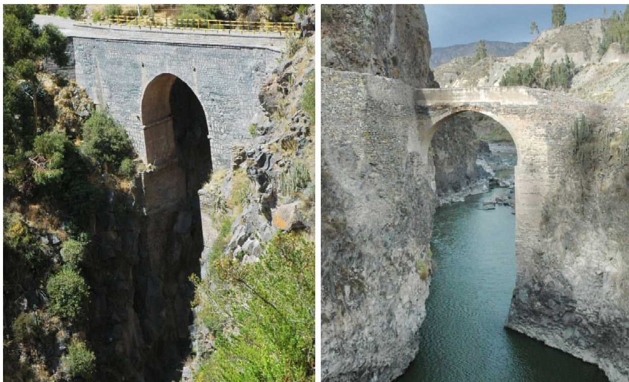
Fotografía 10.10 Puente El Inca, Chivay (izquierda) y puente Yanque en el sector Chacapi (derecha)
