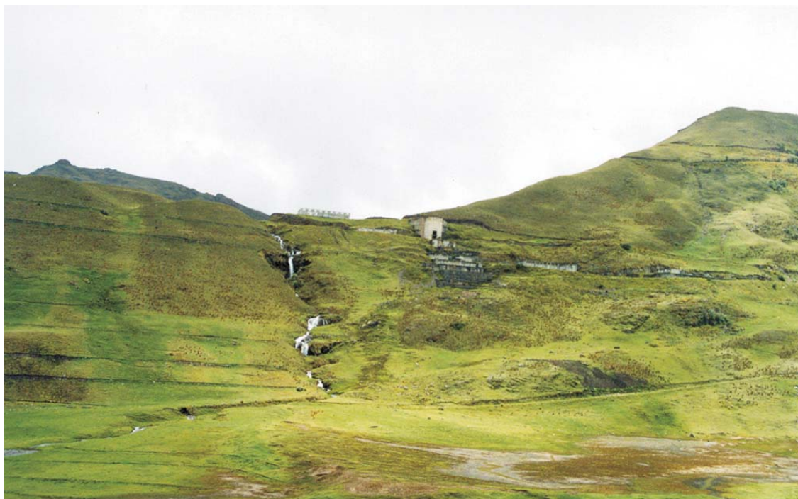
Planta de mina Acotambo - cuadrángulo de Pomabamba. Vista panorámica de la planta de tratamiento por flotación. Actualmente paralizada y abandonada.
