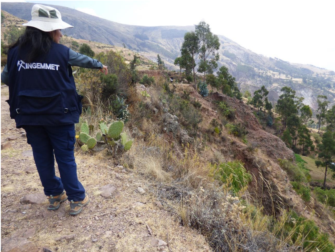
Fotografía 3. Vista panorámica de la ladera y sobre la cual se distingue escarpes antiguos de deslizamiento (señalados) con una longitud de aproximadamente 410 m.
