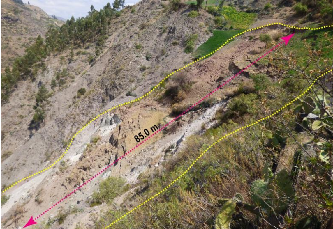
Figura 16. La masa deslizada presenta una longitud de 85 m, la cual se moviliza sobre una superficie de falla rotacional, con dirección preferente de este a sureste.
