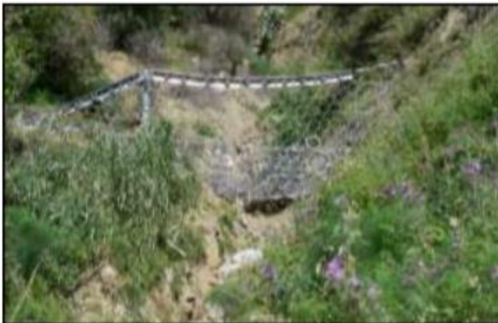
Figura 27. Diseño de barras flexibles de cables para retener corrientes de flujos de detritos.
