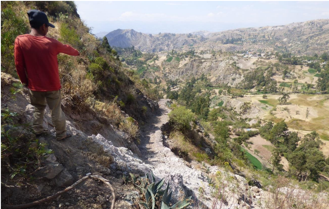
Fotografía 5. Vestigios del camino en el cuerpo del deslizamiento los cuales registran desplazamientos de hasta 10 m ladera abajo.
