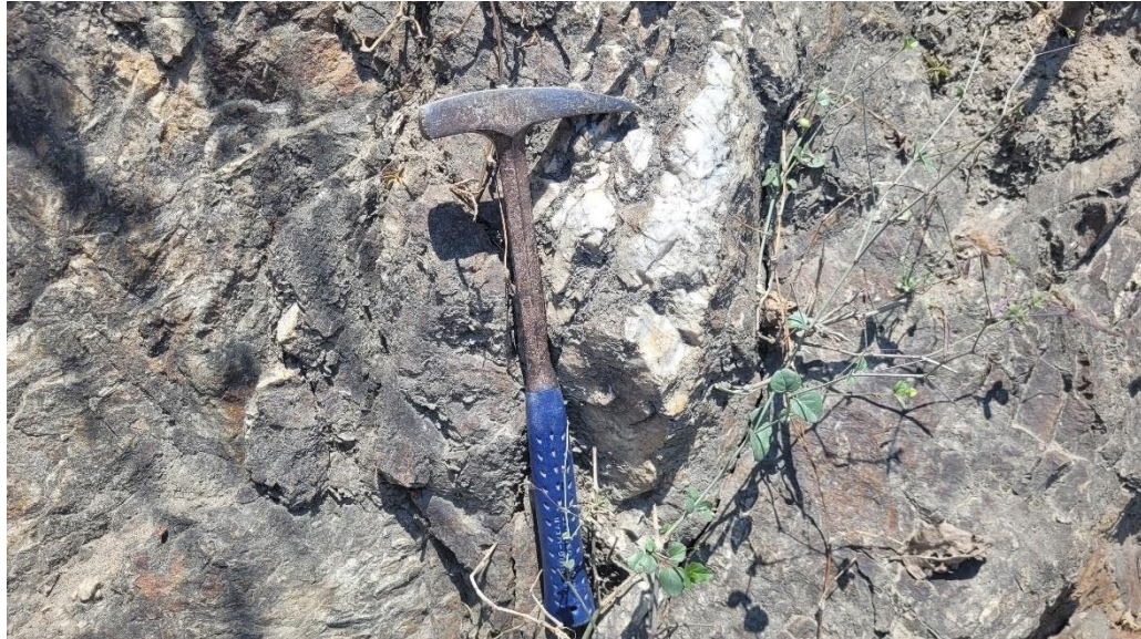
Fotografía 1. Se observa el macizo de la Formación Ñaupe de color gris, medianamente a muy fracturado y ligeramente meteorizado.
