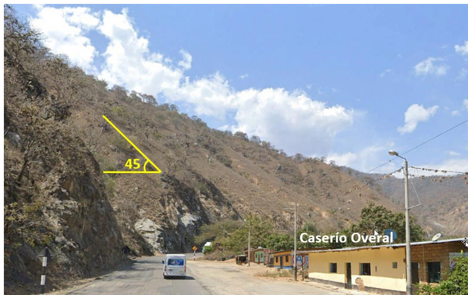
Figura 5. En el sector evaluado, se muestra el terreno con pendiente escarpada, promedio de 45°
