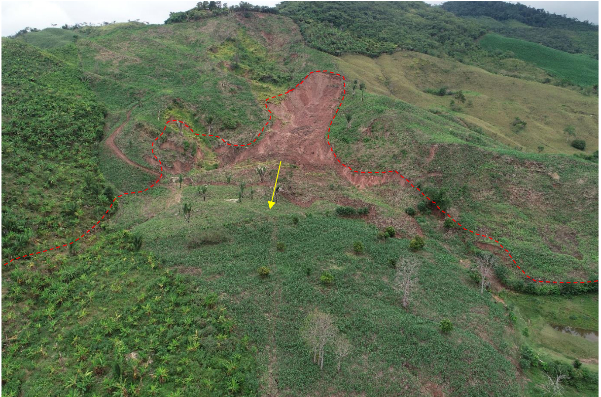
Figura 15. Masa deslizada deformada con presencia de grieta de tensión.
