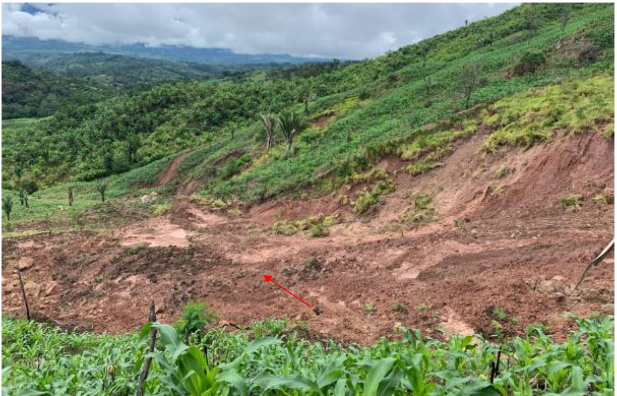
Figura 18. Masa deslizada, compuesta de suelos arcillosos saturados.
