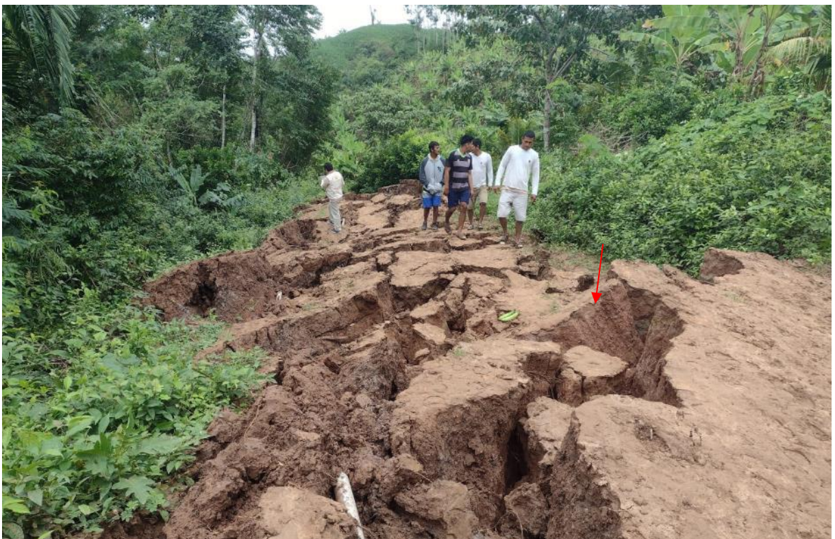
Figura 16. Pie del deslizamiento que ha afectado la trocha carrozable con grietas de 1.50 a 2.00 m de profundidad.
