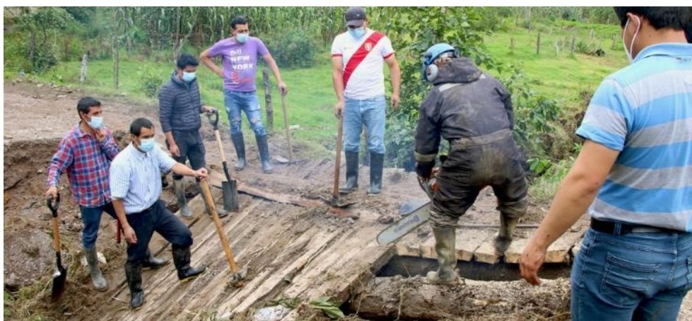
Fotografía 3. Trabajos de rehabilitación en un puente carrozable colapsado en la quebrada Quitahuasi, en abril del 2021. Fuente: Municipalidad Distrital de Tongod.
