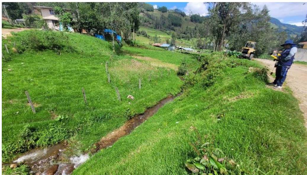
Fotografía 1. Vista del cauce de la quebrada Quitahuasi, lugar de acumulación constante de depósitos fluvial.
