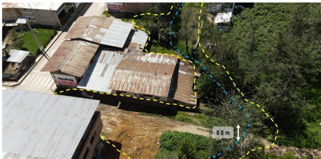
Figura 13. Viviendas, puentes carrozables y terrenos de cultivos susceptibles a desborde de la quebrada Quitahuasi, probable altura de inundación de 0.9 m. Ubicación: E: 740271, N: 9252707, Z: 2609.
