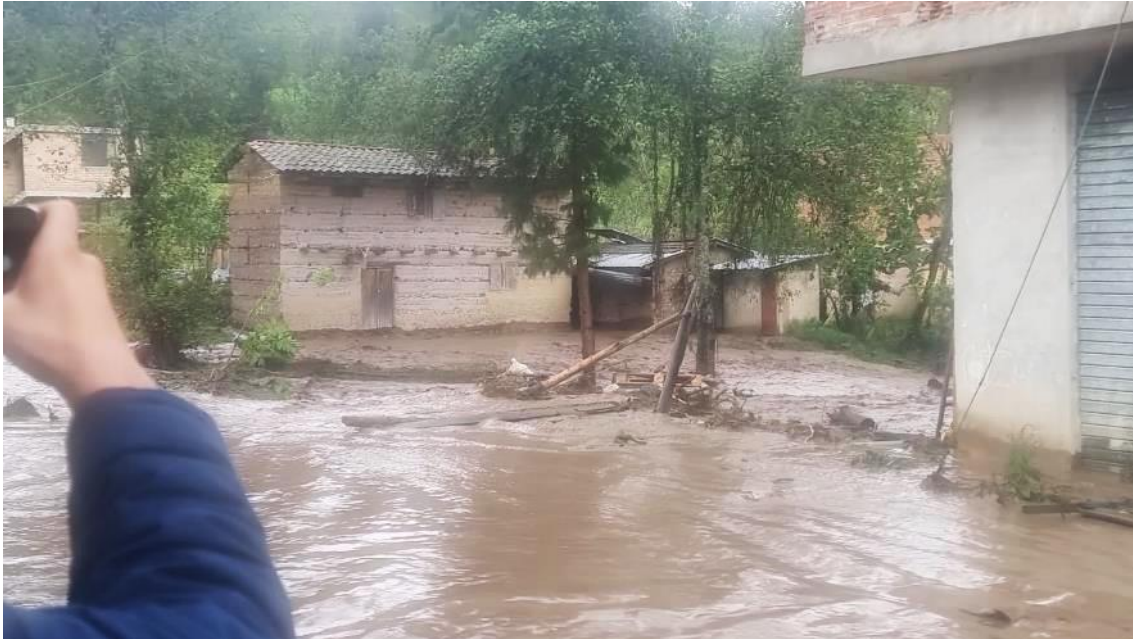
Fotografía 5. Desborde de la quebrada Quitahuasi el 4 de abril del 2023. Fuente: Municipalidad Distrital de Tongod.
