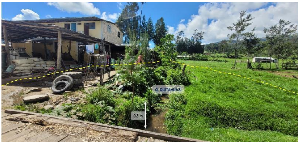
Figura 11. Vivienda, puente carrozable y terreno de pastoreo susceptibles a desborde de la quebrada Quitahuasi, probable altura de inundación de 0.8 m. Ubicación: E: 740319, N: 9252600, Z: 2613.
