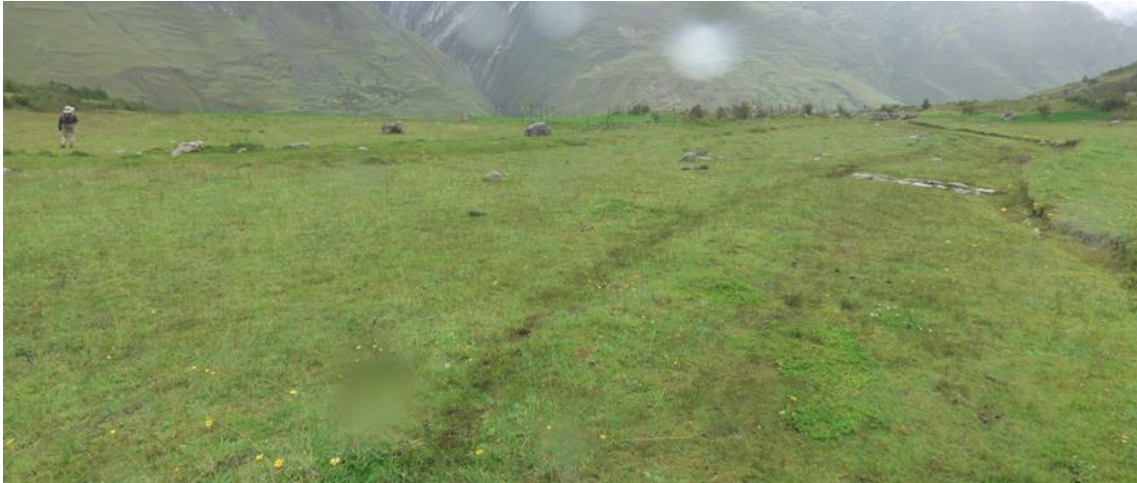
Fotografía 17. Se aprecia la zona propuesta para la reubicación, se aprecian algunos bloques sueltos, producto del desprendimiento de rocas, originadas por la construcción de la vía.
