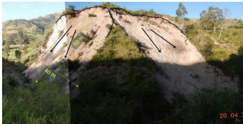
Figura 8: Derrumbes en el sector Retamachayoc, los materiales alimentan al riachuelo Perahuayco.
