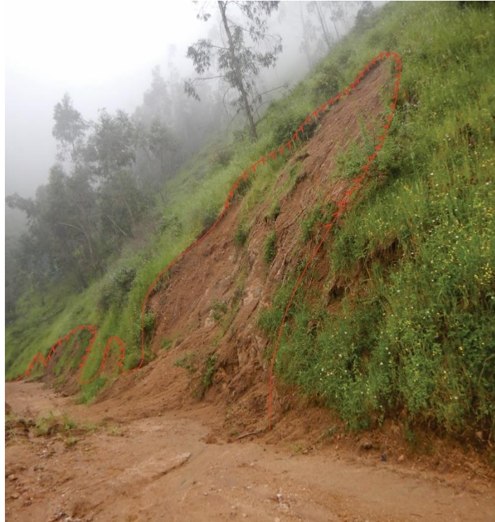
Figura 25. Vista de pequeños derrumbes (líneas de color rojo) que afectan parte del canal de riego, el depósito no se aparecía (fue removido).
