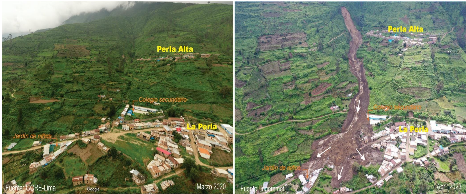
Figura 19. Comparación de una imagen obtenida del Google Earth del año 2020 y la fotografía tomada con dron (2023). En la primera se observa viviendas asentadas varias en el cauce de la quebrada. La segunda corresponde a la tomada post evento, se observa la avalancha de detritos, el cual afectó severamente viviendas, tramos de carretera, así como terrenos de cultivos.
