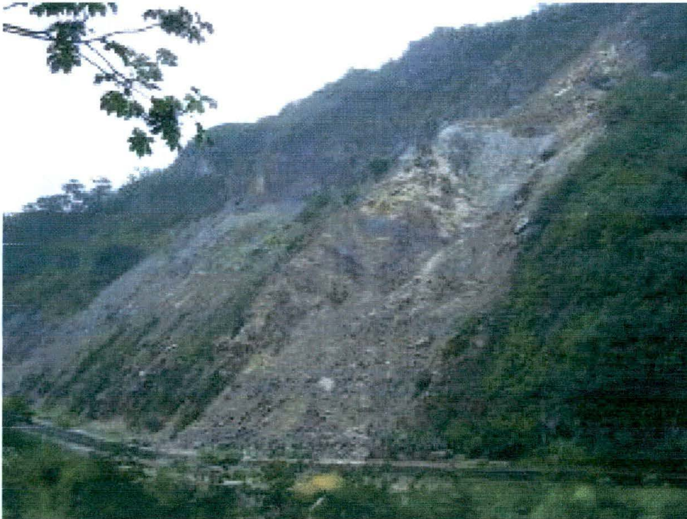
Fig. 43: Derrumbe en talud superior de carretera, en el sector de Tangarama.
