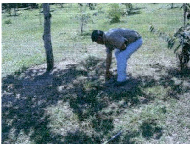
Fig. 36: Agrietamiento en la parte superior de la corona del deslizamiento.
