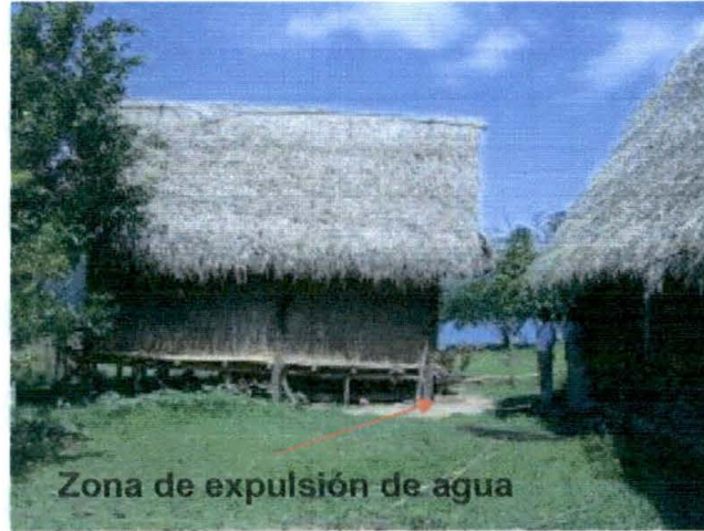
Fig. 15: Vivienda inclinada por efectos del sismo, zona donde se produjo la expulsión de agua que alcanzó hasta 4 m de altura.
