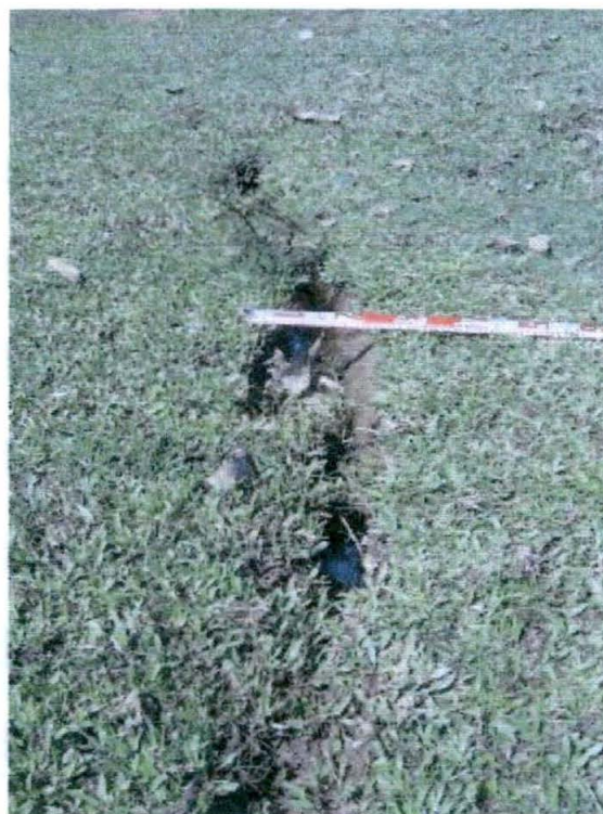
Fig. 13: Detalle de los agrietamientos de la vista anterior.
