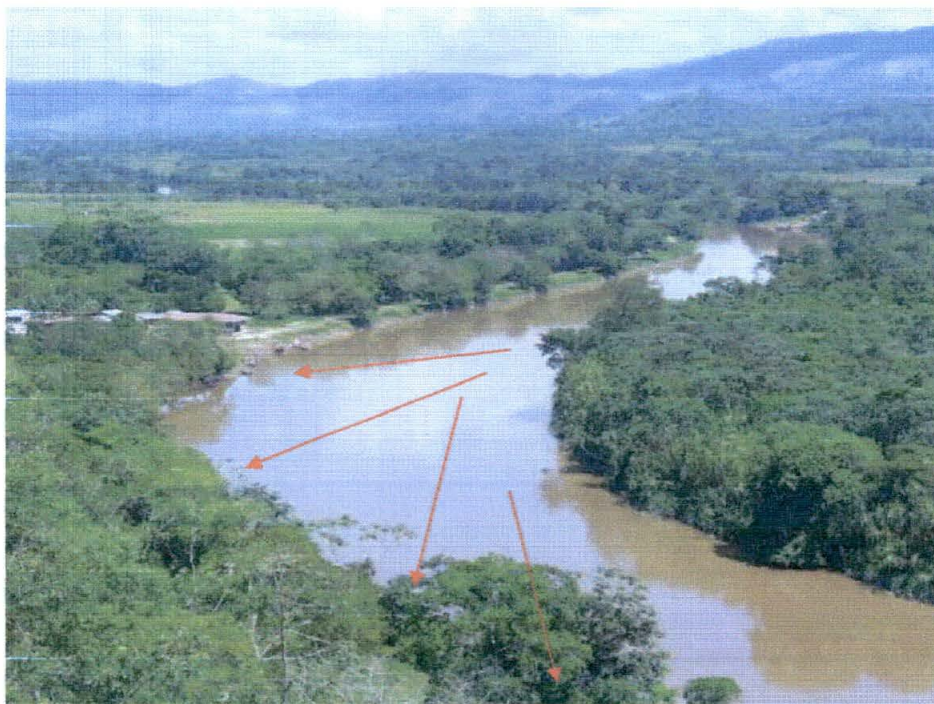
Fig. 38: Vista panorámica hacia el NW del sector de Tahuishco afectado por erosión fluvial.
