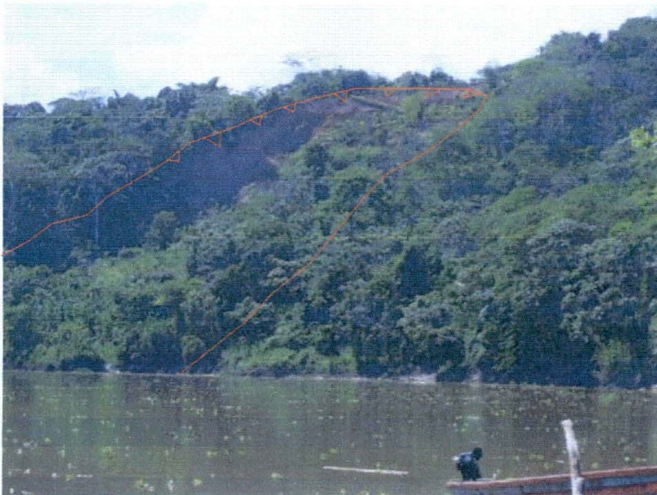
Fig. 35: Vista hacia el SE desde la margen derecha del río Mayo donde se puede observar el deslizamiento que afecta el la infraestructura del Hotel Puerto Mirador.
