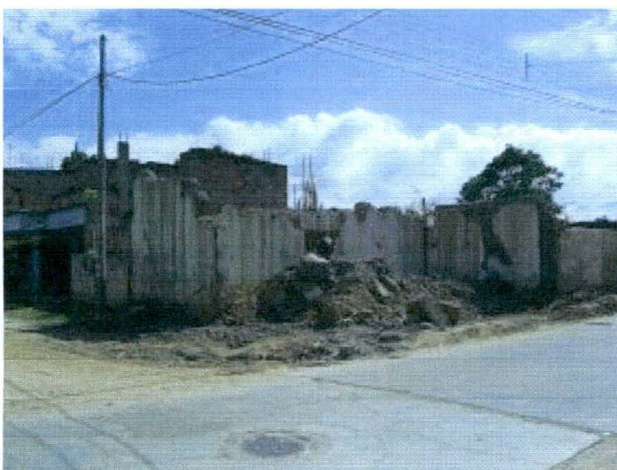
Fig. 5: Vista de una vivienda destruida por el sismo en la localidad de Moyabamba.
