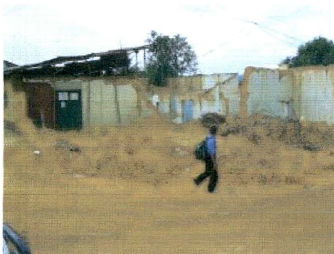
Fig 3: Estado en que quedaron las viviendas en la localidad de Lamas después del sismo del 25 de Setiembre del 2005.
