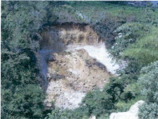
Fig. 34: Detalle de un deslizamiento en la margen izquierda de la quebrada, que aporta materiales sueltos, los cuales son acarreados posteriormente como flujos.
