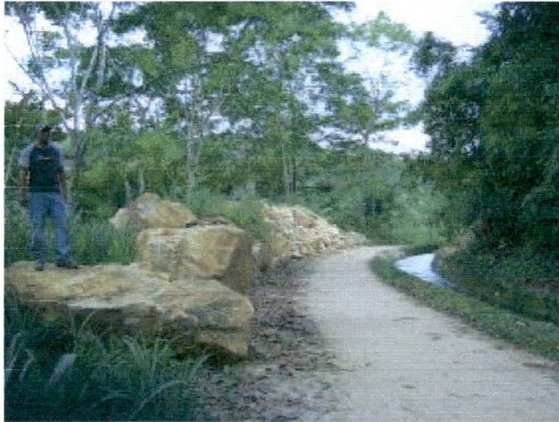
Fig. 29: Tamaño de los bloques caídos hacia el canal Cumbaza, llegan a tener 3 m de longitud.
