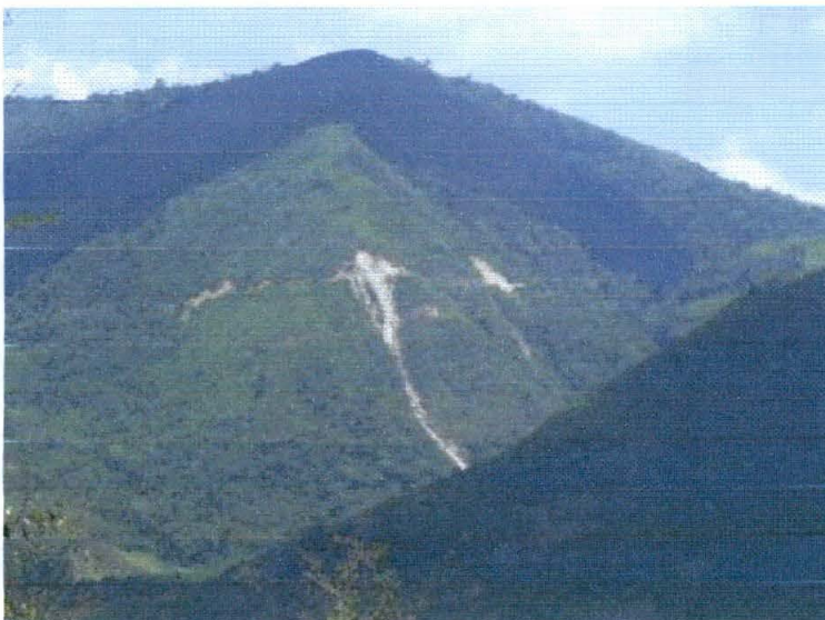
Fig. 24: Vista panorámica de la carretera de acceso al distrito de Sauce donde se puede apreciar las dos zonas afectadas por derrumbes.
