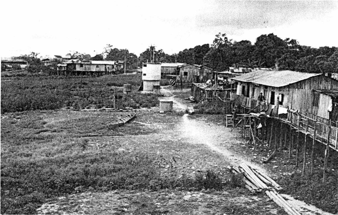
Foto N 10: Vista aguas abajo de la quebrada de Yumantay (margen derecha). Se aprecian buzones de desagüe levantados como prevención contra inundaciones, para evitar que el sistema de alcantarillado se llene de sedimentos cuando se produce la inundación.
