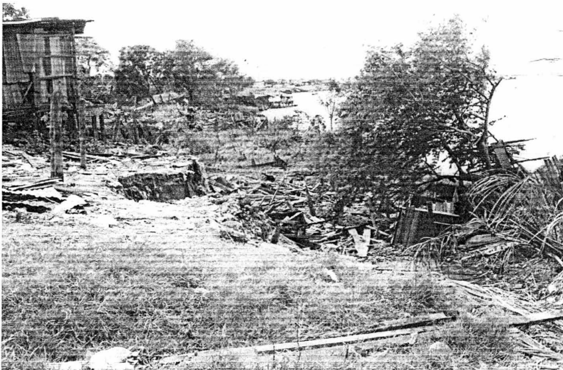
Foto N 6: Acercamiento de las fotos anteriores donde se distingue los agrietamientos, escarpas y asentamientos de terreno en una longitud amplia, vista aguas arriba y aguas abajo en el sector de Santa teresa.
