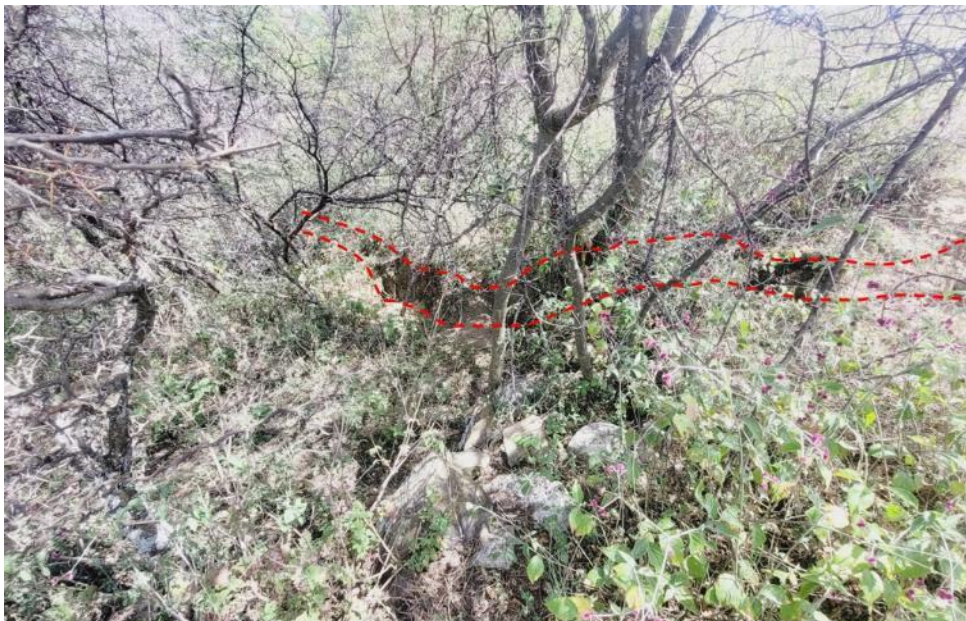
Figura 13. Agrietamiento (línea roja discontinua), con longitud de 5 m y ancho de 20 cm, ubicada en la margen derecha, fuera del cuerpo del deslizamiento. Coordenadas: E: 818907, N: 9158733.
