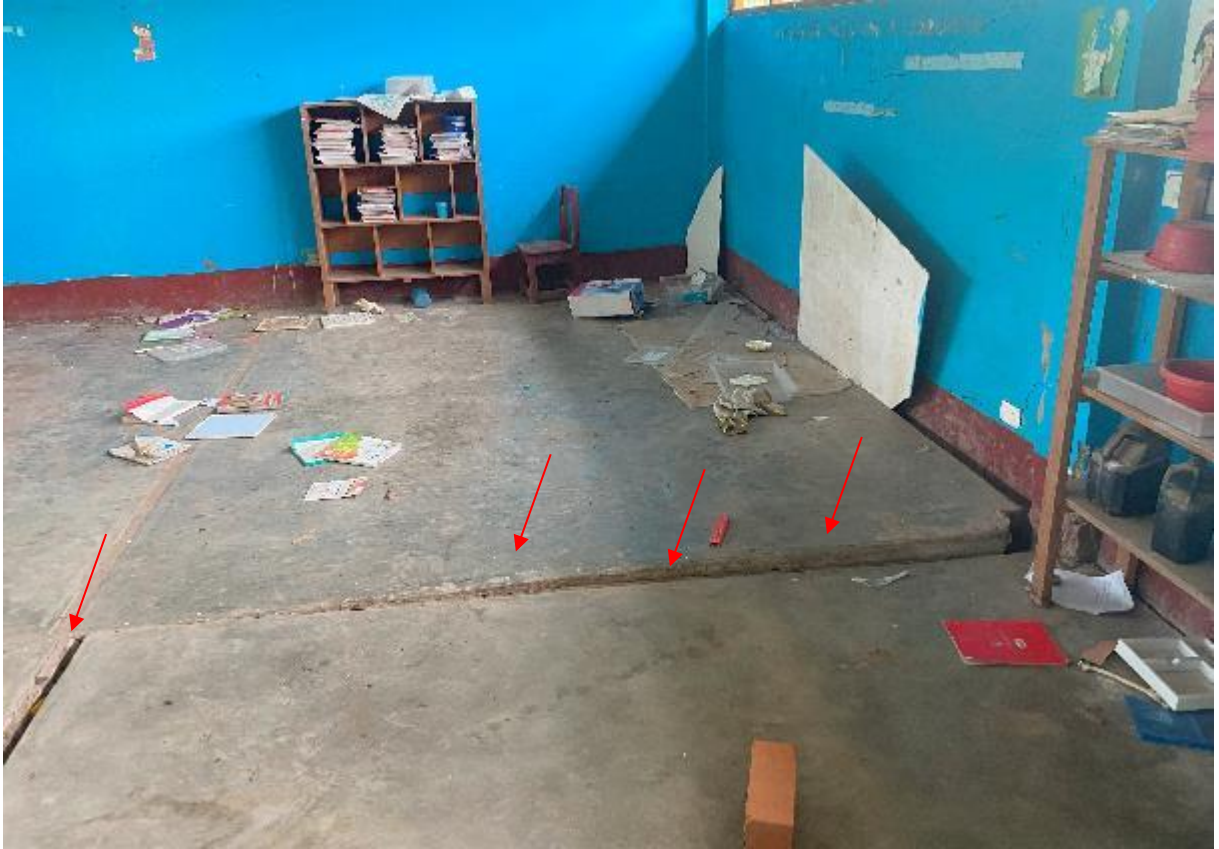
Figura 23. IE N°43 Pampa Hermosa, con losas levantadas.
