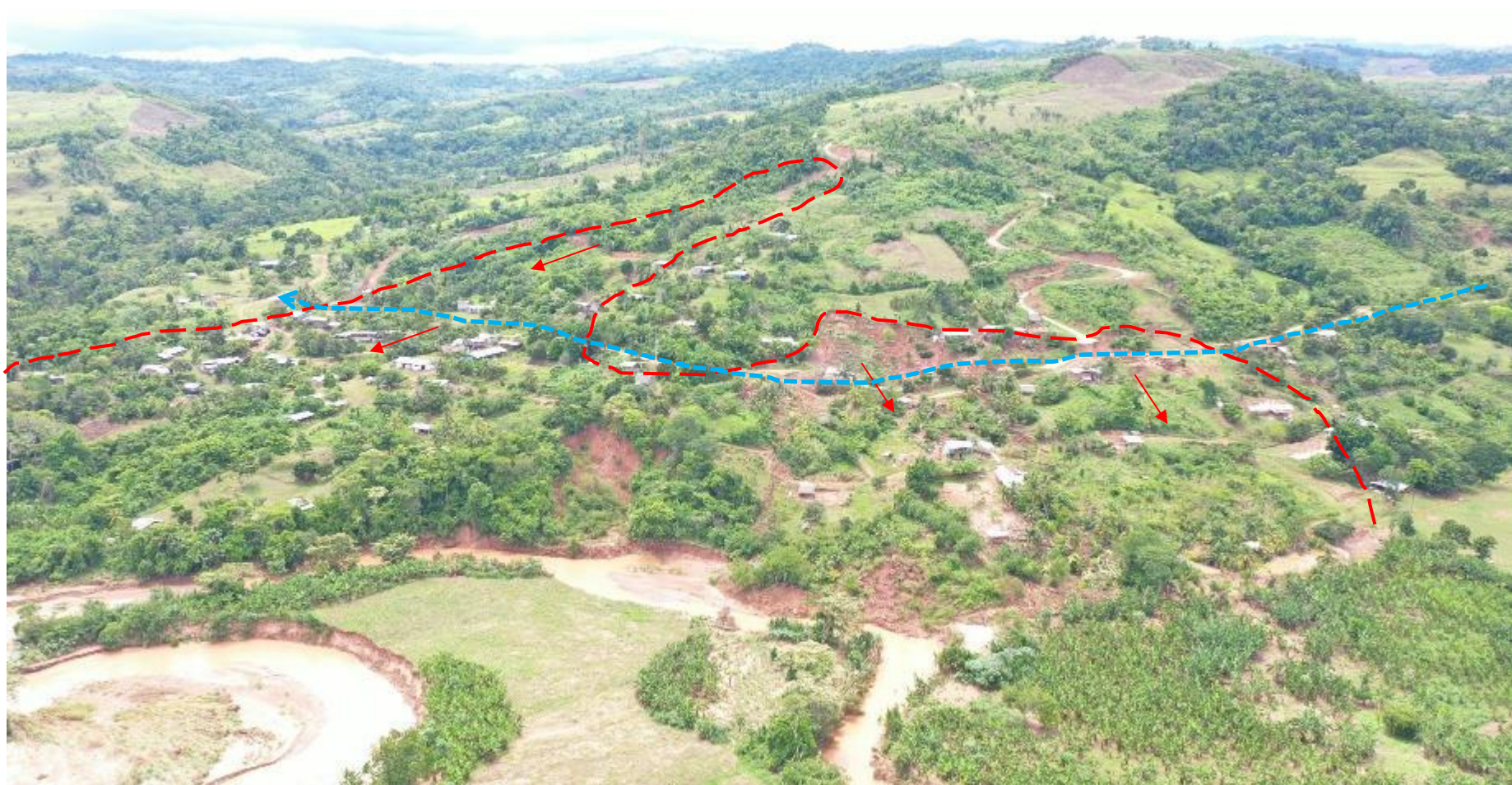
Figura 15. Vista general del deslizamiento de Pampa Hermosa. Línea discontinua celeste indica la ubicación de la tubería de agua potable del valle del Ponacillo.
