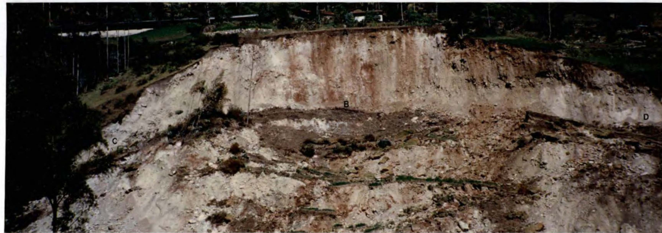
FOTO N° 3 .- Zona de arranque del deslizamiento con una escarpa superior de 29 m. entre A y B y una longitud de 138 m. entre C y D
