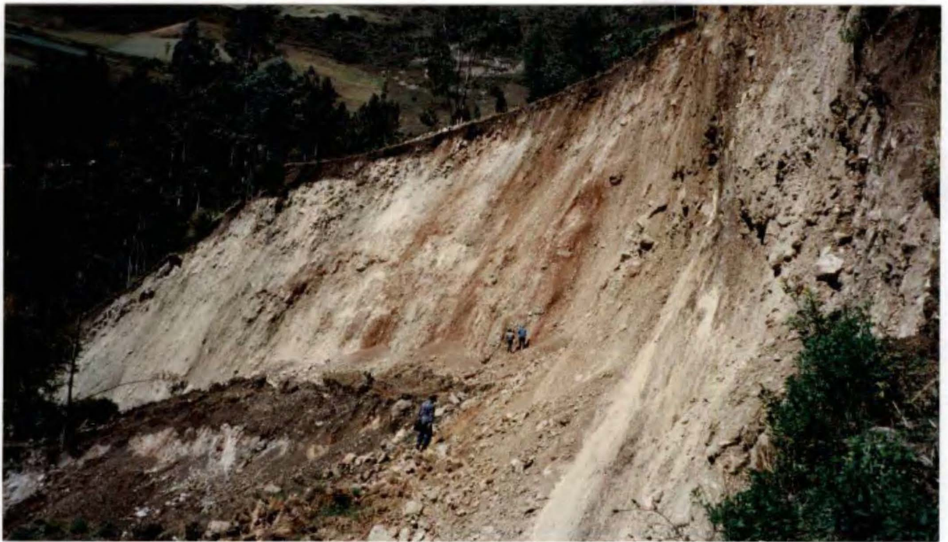
FOTO N° 4.- Escarpa superior del deslizamiento, que tiene una altura de 29 m.
