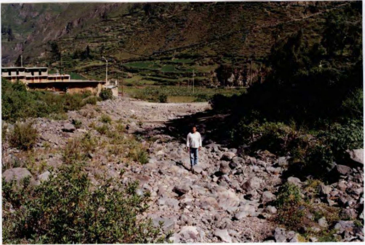
FOTO N° 3.- Vista aguas abajo de la quebrada Potura, por donde discurren huaycos en la temporada de precipitaciones pluviales que compromete la seguridad física de la carretera y viviendas. Construir enrocados en ambas márgenes
