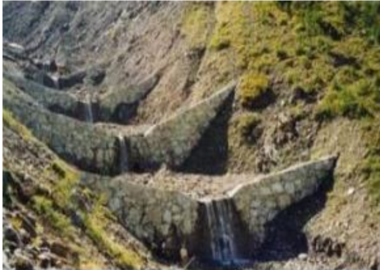
Figura 51. Ejemplo de diques escalonado de hormigón.
