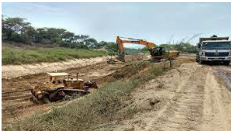
Figura 50. Ejemplo de obras de canalización.
