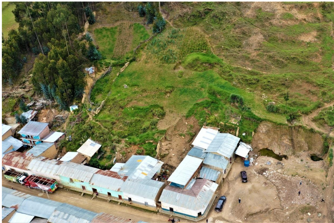
Fotografía 10. Vista panorámica de las posibles viviendas a ser afectadas por el deslizamiento en el Sector 2. Coordenadas UTM: 295627.00 / 8940626.00, Zona 18.
