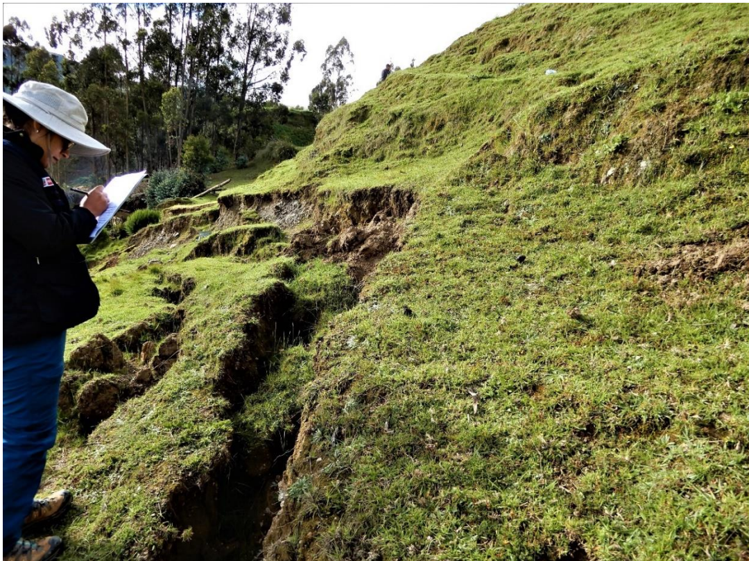
Fotografía 6. Escarpas escalonadas de deslizamiento en el Sector 1 con desplazamiento vertical hasta de 1m.
