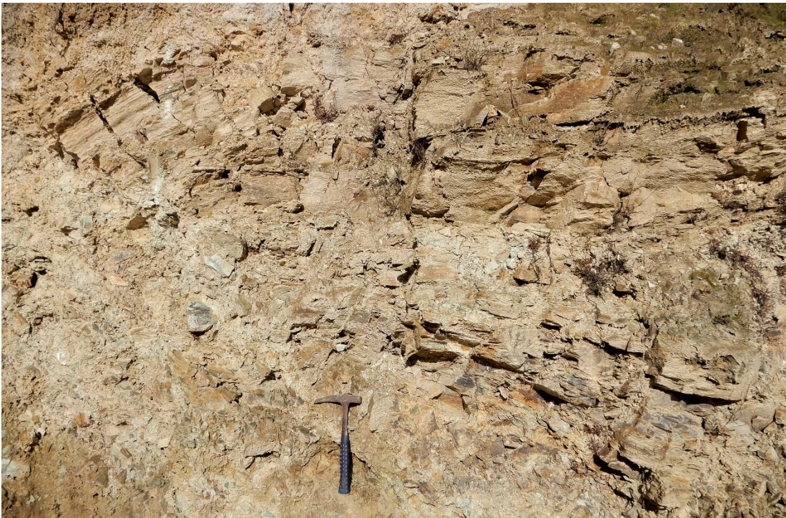
Fotografía 4. Macizo triturado compuesto por esquistos del Complejo del Marañón. Coordenadas UTM: 295751.95 / 8940597.86, Zona 18.
