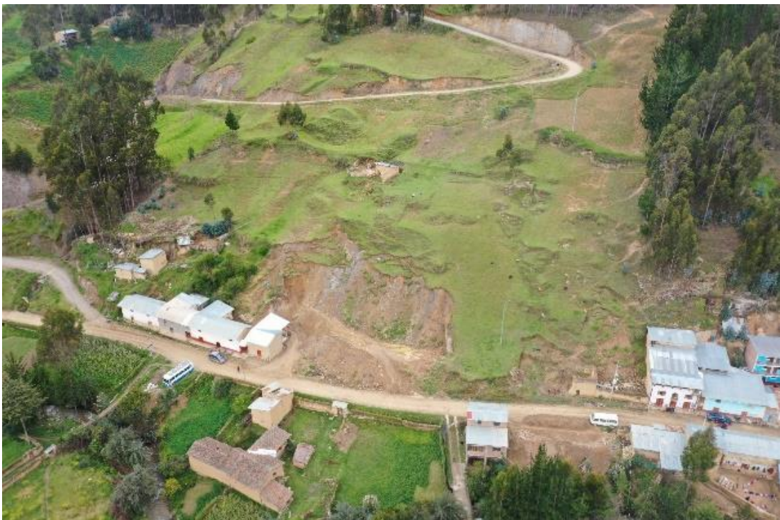
Fotografía 1. Vista panorámica del sector de evaluación número 1 afectado por deslizamiento en el centro poblado El Porvenir Coordenadas UTM: 295779.49 / 8940595.99, Zona 18.
