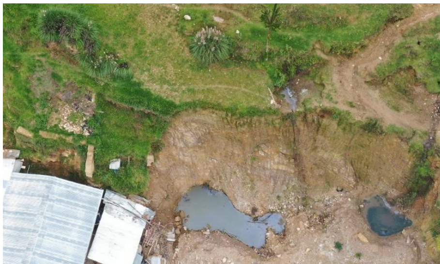
Fotografía 11. Muestra de las filtraciones de agua acumulada en la zona evaluada. Coordenadas UTM: 215585.23 / 9141240.75, Zona 18.
