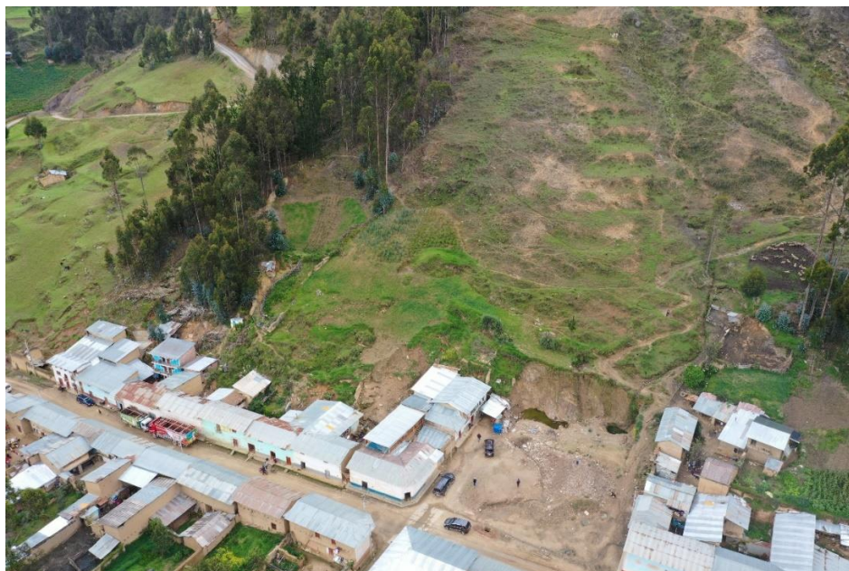
Fotografía 2. Vista panorámica del sector de evaluación número 2 afectado por deslizamiento en el centro poblado El Porvenir UTM: 295635.52 / 8940634.73, Zona 18.
