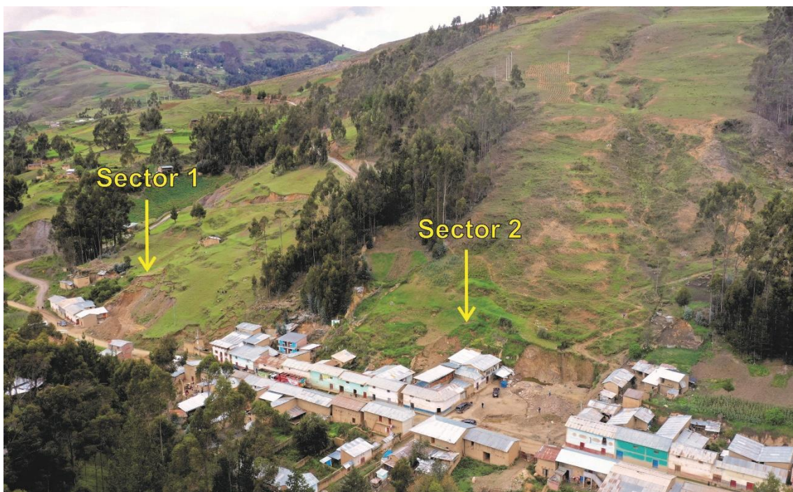
Figura 7. Ubicación de los sectores donde se presentan deslizamientos activos que pueden afectar viviendas.
