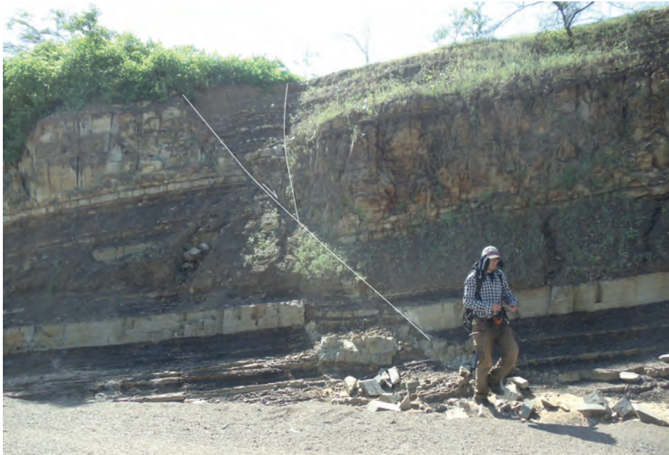
Figura 6.7 Falla normal en la quebrada Tamarindo. Vista tomada mirando al noreste (UTM 544371/9493420)
