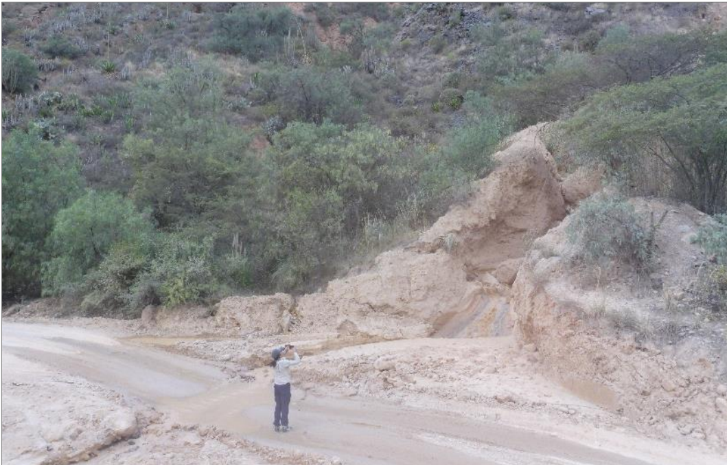
Fotografía 6. Vista del material desplazado cuesta abajo por medio de los canales que formó las cárcavas, desembocando en la carretera que conduce a Huánuco, hasta la confluencia al río Puchca.
