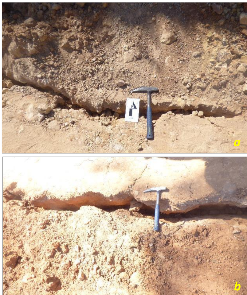
Figura 10. Escarpa del deslizamiento de aproximadamente 30 cm, en la ladera de Pariacancha.
