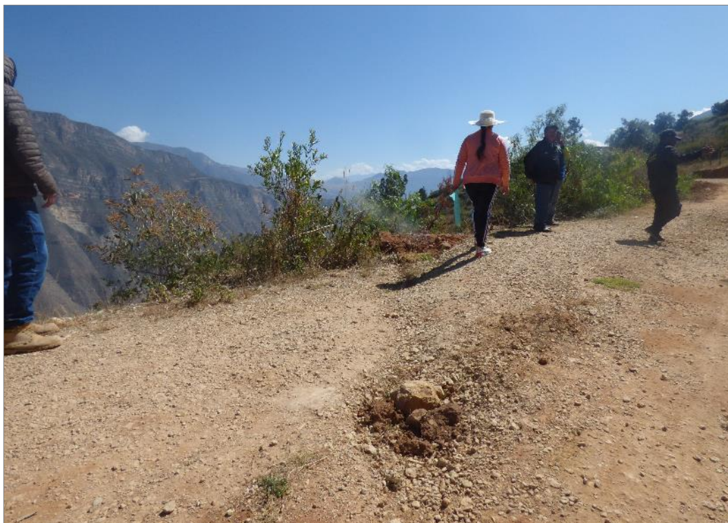
Fotografía 4. Vista de asentamiento en la trocha carrozable que conduce a sectores del centro poblado Pariacancha.
