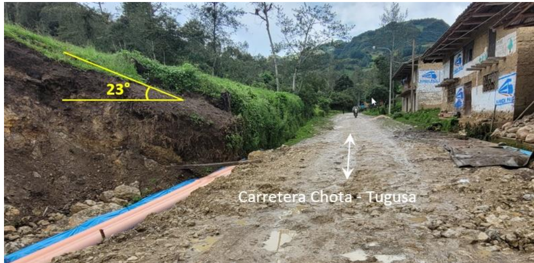
Figura 4. La ladera que colinda con la carretera, tiene una pendiente promedio de 23^\circ
