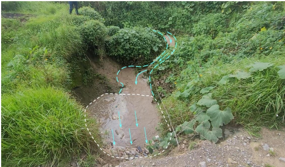
Figura 5. Dolina ubicada a 660 m (líneas discontinuas color blanco), al noroeste del sector evaluado, el agua ingresa de manera continua.
