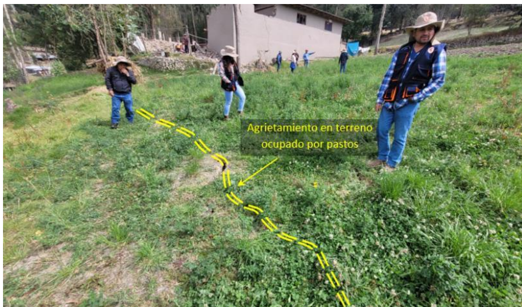
Figura 9. Inicios del movimiento en masa (23 de agosto), presencia de grietas en terrenos ocupados por pastos naturales. Coordenadas: E: 781776, N: 9212131.
