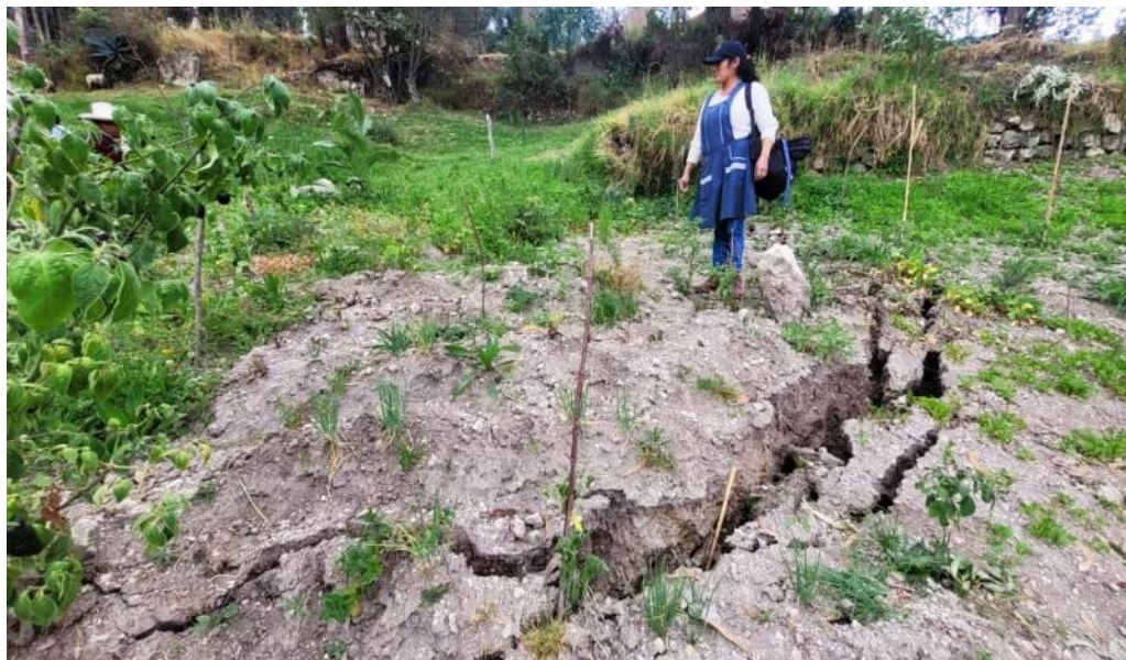
Fotografía 4. Grietas ubicadas en la parte baja del cuerpo del deslizamiento, longitud de 6 m y apertura de 30 cm. Coordenadas: E: 781713, N: 9212136.
