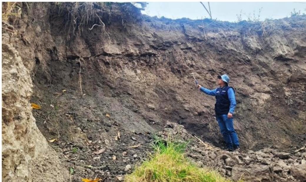
Fotografía 1. Se observa la roca de la secuencia volcánica San José, muy fracturada y completamente meteorizada.
