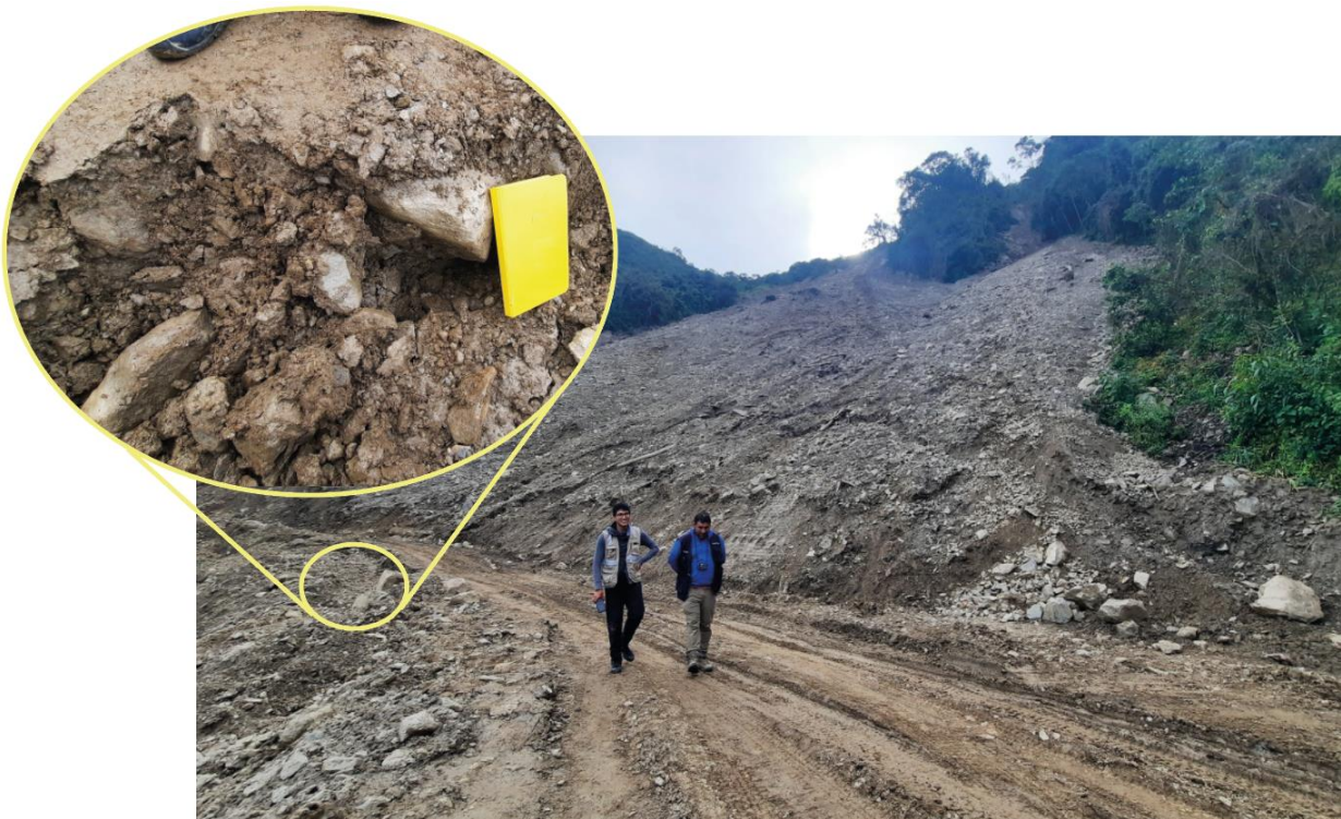
Figura 5. Depósitos coluvio deluviales, movilizados por la activación del deslizamiento en el sector Sillapata – Cconchuaycco, Km 148+120 de la vía CU-100. Coordenadas UTM 18 L E: 693716, S: 8519540 y Elevación: 2390 m.
