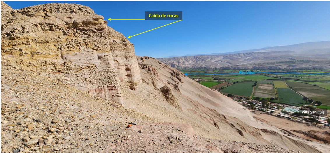
Figura 15. Se indica la zona de arranque de caída de rocas.
