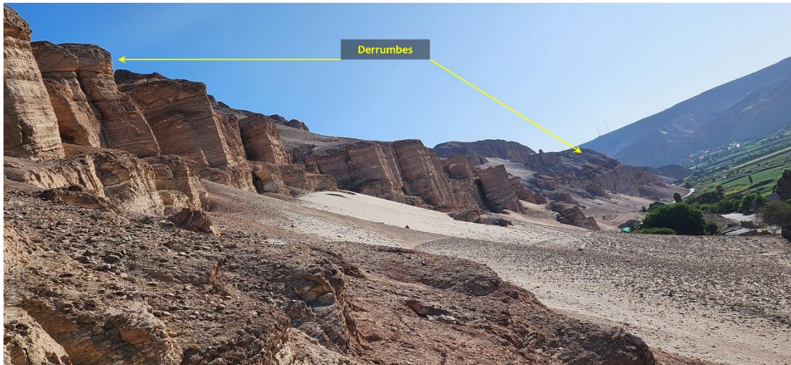
Figura 20. Se muestra zona de arranque de los derrumbes en la ladera media de las colinas de la Villa San Luis. Vista hacia el noroeste.
