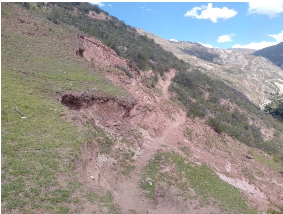
Fotografía 5. Vertientes de deslizamiento en el sector Huayllas Bajo.
