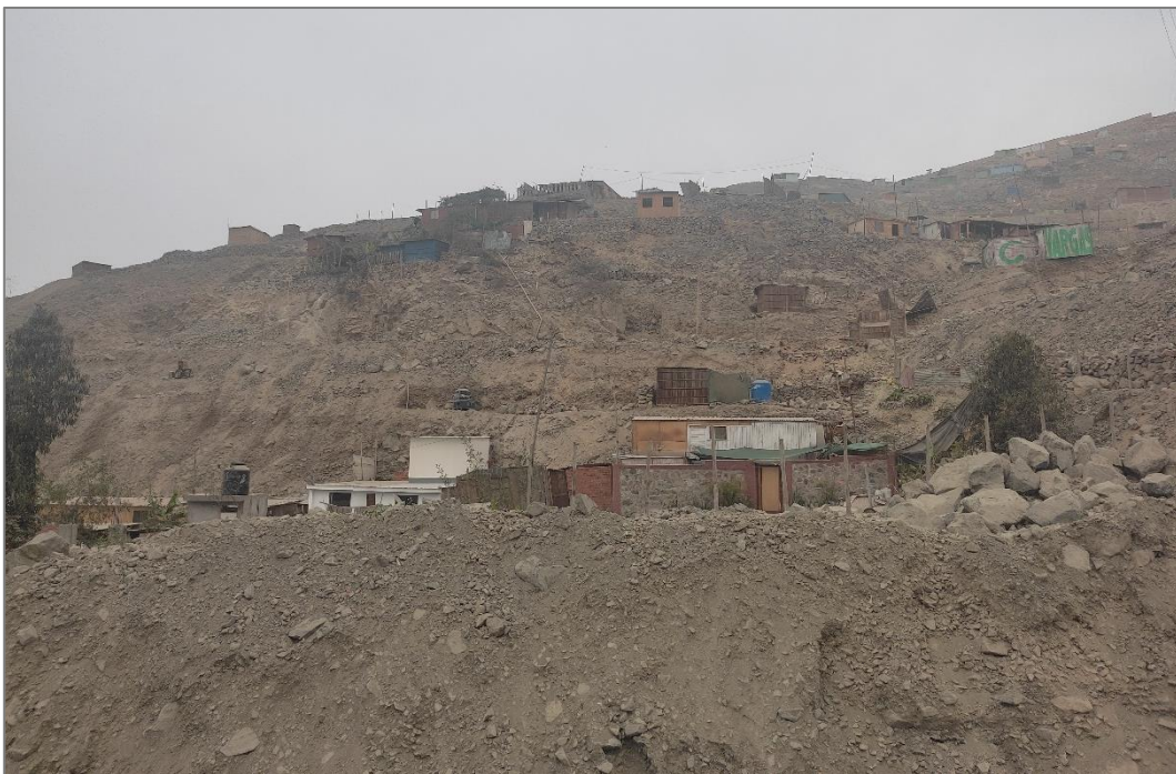
Fotografía 2. Depósitos coluviales dispuestos en las laderas que limitan la quebrada Santa María. Sirven como material de aporte al cauce, ante un eventual flujo de detritos.
