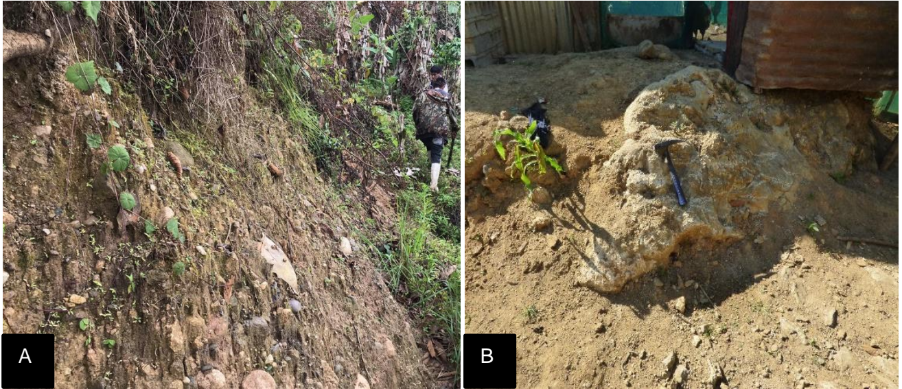
Figura 5. A. Geológicamente el anexo San Emilio se encuentra asentado sobre rocas conglomerádicas y areniscas del grupo Mitu, altamente meteorizada y moderadamente fracturadas. B. (E763 463952, N8753980), bloque de arenisca suelta en la entrada de una vivienda.
