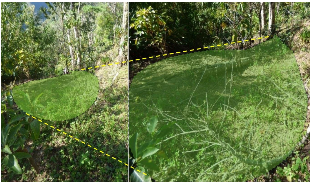
Figura 12. Proceso de erosión de ladera tipo cárcava, en forma semicircular, este proceso geodinámico es un indicativo del estado del suelo, las características de la roca y un futuro proceso de mayor escala.
