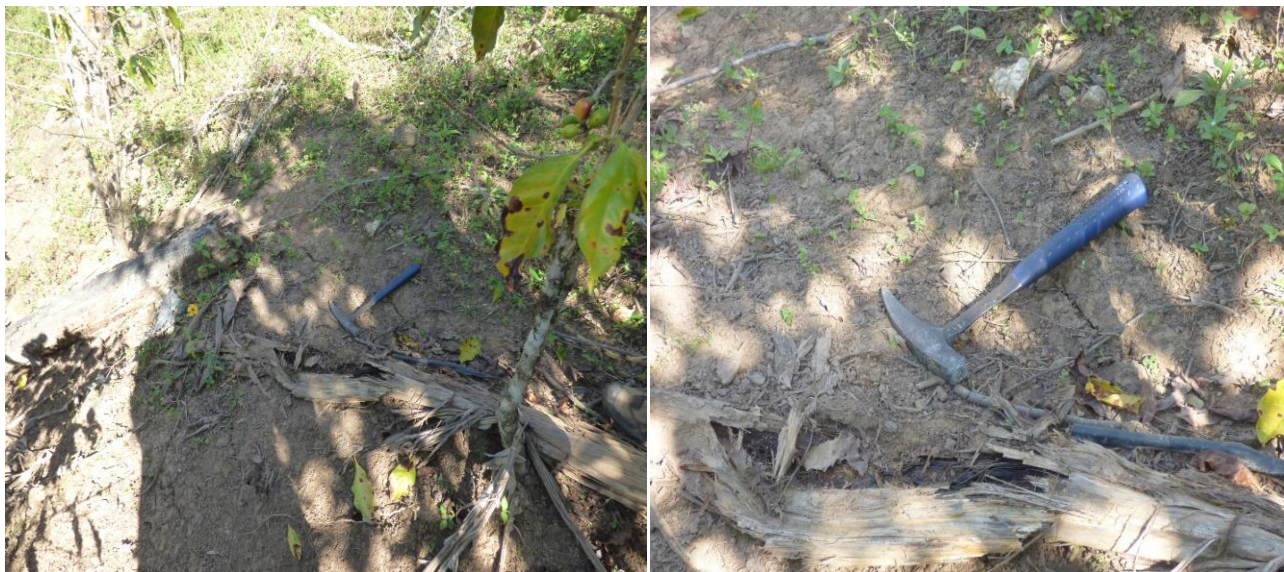
Fotografía 2. Presencia de grietas de 5m de longitud, de 1cm - 2cm de ancho, indicativo del proceso de desplazamiento de suelo, a consecuencia de la reactivación del deslizamiento.
