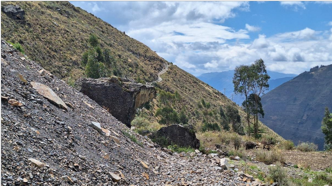
Fotografía 2. Vista de la ladera noreste que delimita el centro poblado de Pacchancca, donde se tiene bastante material suelto disponible.
