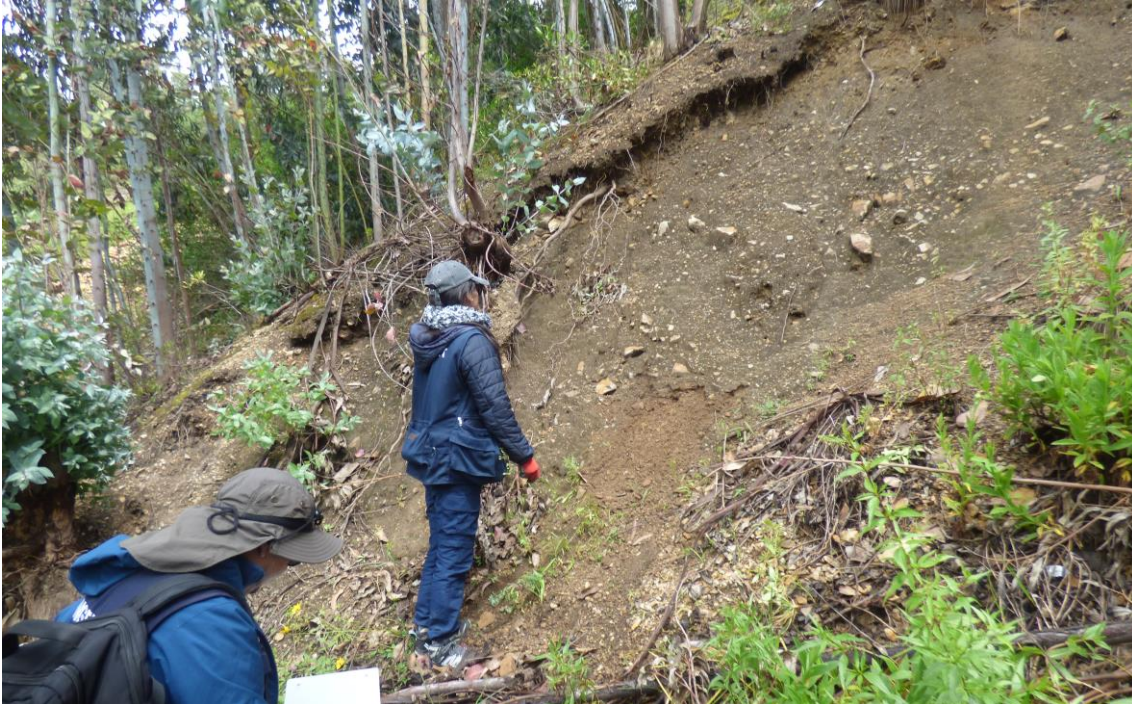
Fotografía 1. Vista del depósito coluvio-deluvial poco consolidado, compuestos por fragmentos de roca angulosos a subangulosos de tamaños variables (4 a 50 cm), envueltos en una matriz limo-arenosa. Granulometría: 10% bloques, 15% gravas, 25% gránulos, 30% arenas, 20% limos y arcillas.
