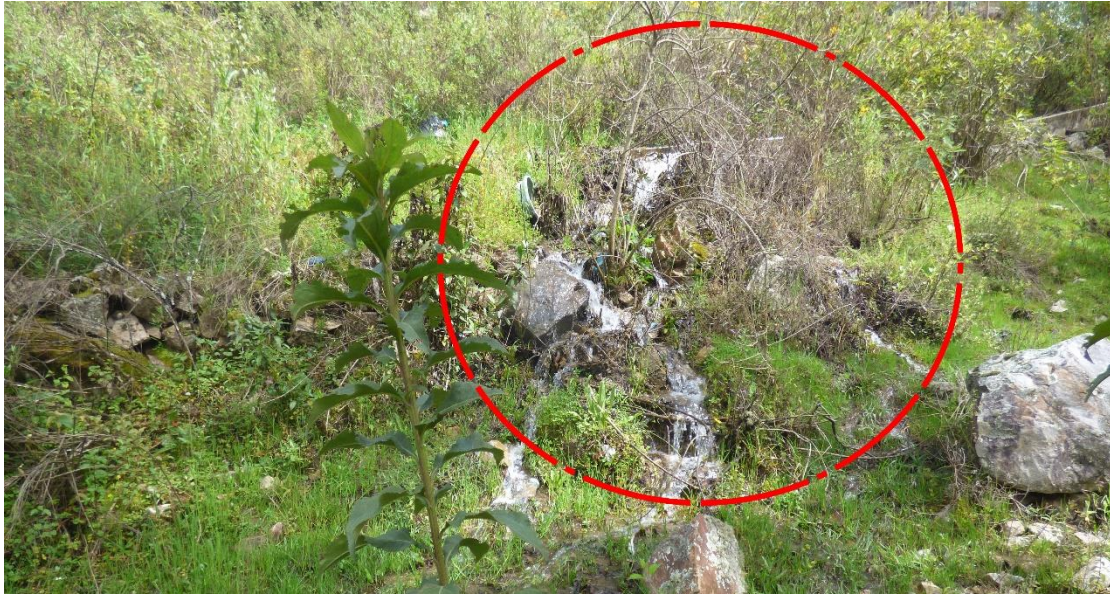
Figura 8: Canal de riego revestido hasta media ladera, lo que hace que el agua continúe su recorrido ladero abajo hasta infiltrarse. Coordenadas referenciales: UTM WGS84 Zona 18S 260618 E, 8942627 N.
