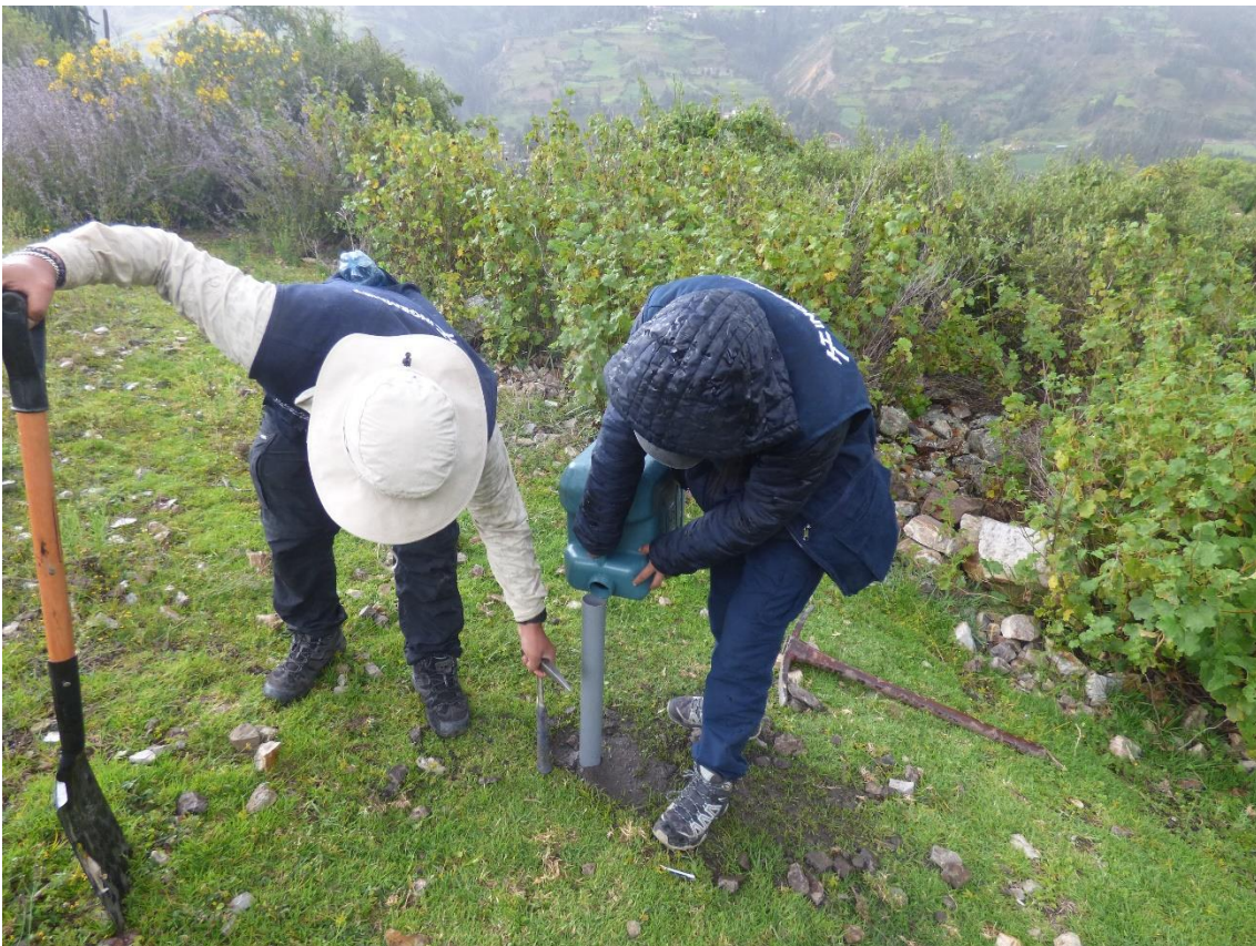
Figura 12. Instalación de tubería y ejecución de ensayo en campo.
