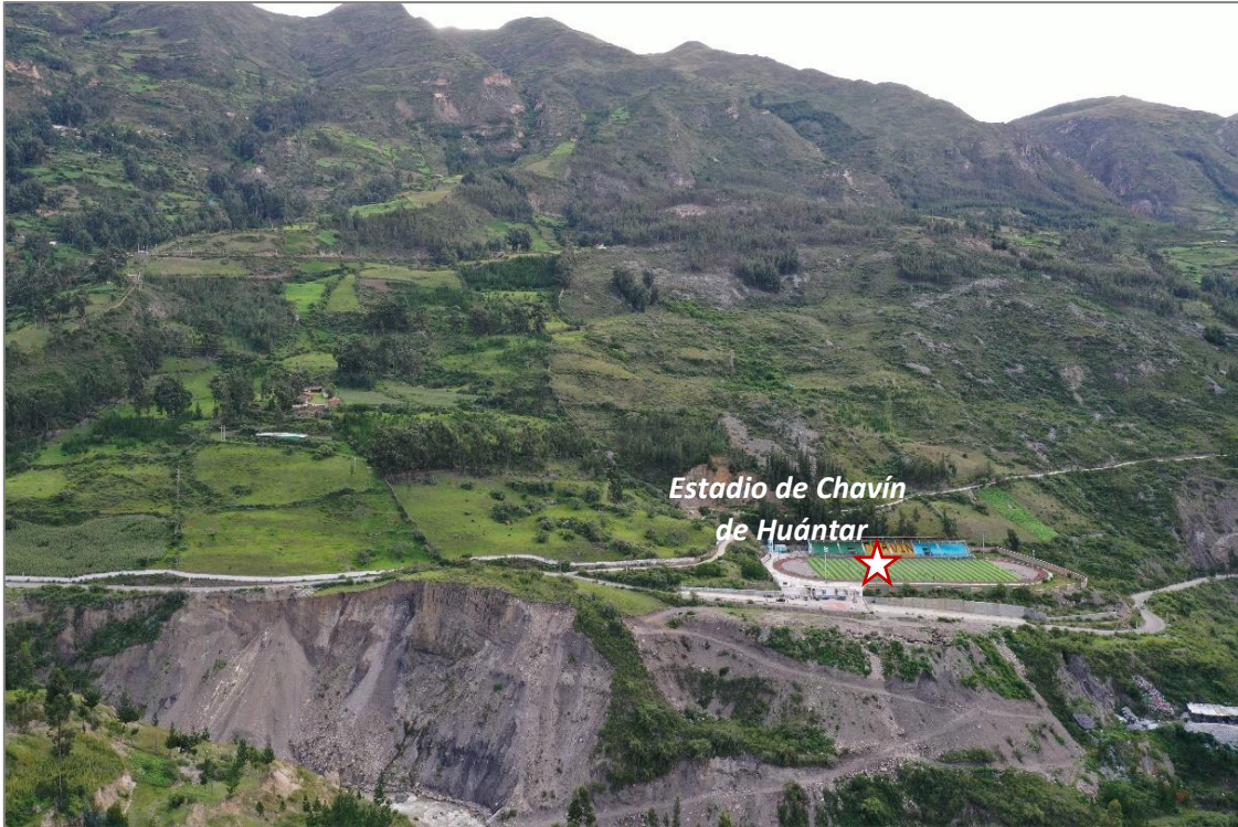
Figura 3: Ladera este del cerro Pacsin, presenta relieve ondulado, aspecto indicativo de procesos de movimientos en masa como deslizamiento, derrumbes y avalanchas de rocas antiguos, activos y reactivados.
