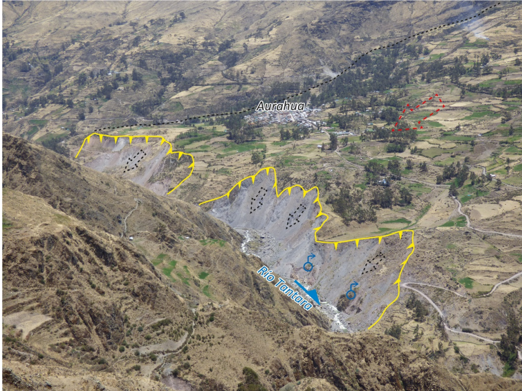
Figura 11. Reactivaciones en la base del deslizamiento Aurahúa, donde influye el tipo de material, la presencia de surgencias de agua en el talud y la acción erosiva del río Tantara.
