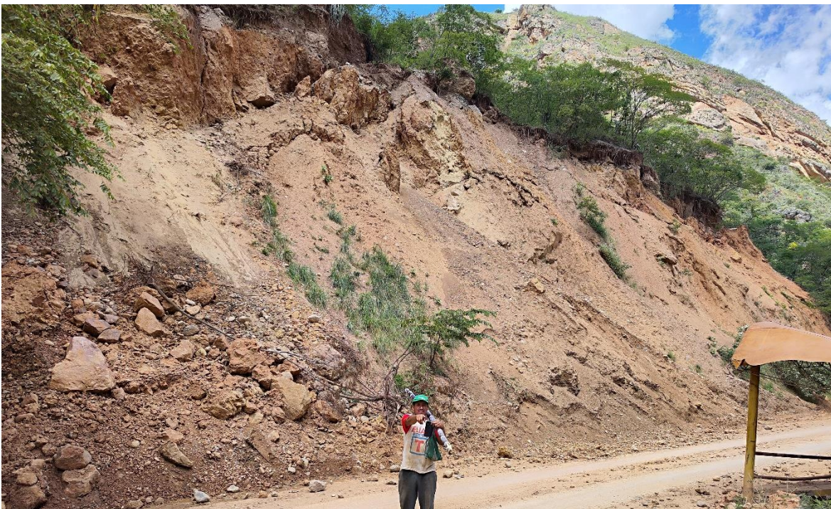
Figura 28. Depósitos coluvio-deluviales originados por antiguos deslizamientos.
