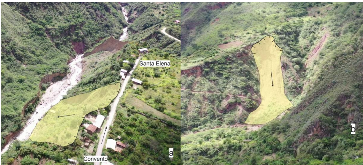
Figura 20a. Derrumbe suspendido DS-3 en el borde la trocha carrozable hacia el caserío Santa Elena. 20b. Derrumbe a 150 m del caserío Convento.
