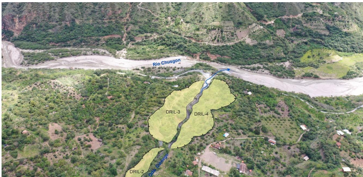
Figura 17. Vista aérea de los deslizamientos inactivos latentes (DRIL-2, 3 y 4), el DRIL-4 se ubica a escasos metros del área urbana del caserío Cienego.
