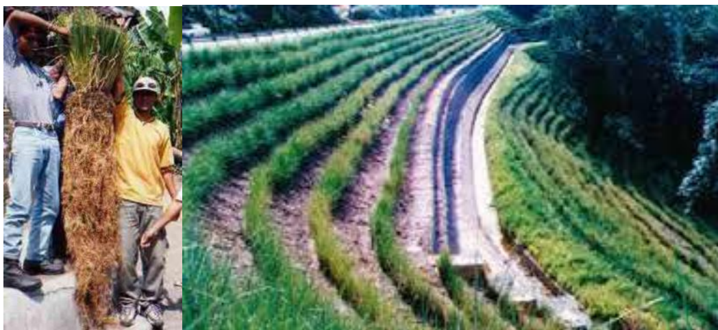
Fotografía 6. Ejemplo de bioingeniería con arbusto (vetiver) en taludes de materiales sueltos.
