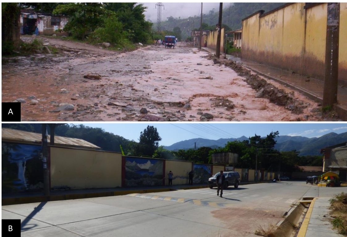
Figura 14. A. Imagen del C.E.I. 30765 “Juan Santos Atahualpa” luego del flujo de año 2007, el flujo se desplazó por la av. Ramón Castilla hasta el final de la avenida. B. Imagen actual (junio, 2023) del centro educativo, se han realizado trabajos de reparación y mejora del colegio y la avenida. Coordenadas (E460788; N8770729).
