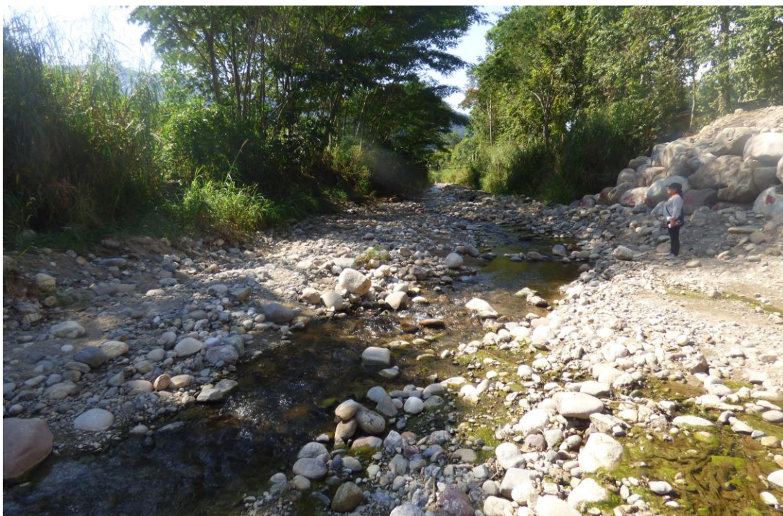
Fotografía 9. En este sector, el río Huacará hace un cambio brusco de dirección de su cauce, de N26° a N45°, el cauce se observa colmatado y en la margen derecha se observa el enrocado. Coordenadas (E459509; N8769352).
