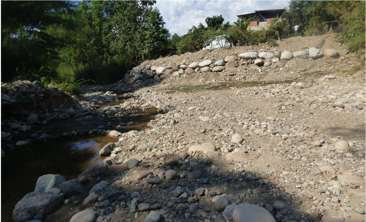
Fotografía 7. Defensa ribereña en la margen derecha del río Huacará, este se observa colmatado y presenta un ancho de cauce de 7m. Coordenadas (E459524; N8769350).
