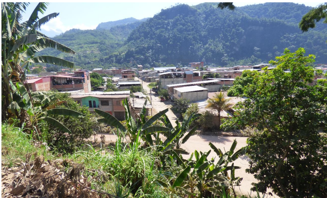
Fotografía 2. Quebrada Huacará. Se observa el sector San Elias, sector afectado por el flujo de detritos del año 2007 (entonces sin viviendas), la zona urbana es de crecimiento posterior al evento ocurrido en dicho año.
