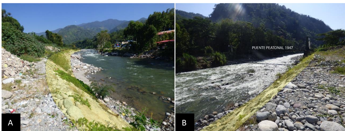
Figura 15. A. Río Tarma, se observa en la margen derecha enrocado (sombreado amarillo) como barrera de protección frente a erosión y desborde. B. Continúa el enrocado en amarillo y se observa el puente peatonal Victoria. Coordenadas (E459911; N 8770762).
