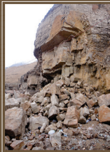
Caída de rocas en el A.H. Inty Llacta (Chorrillos)
