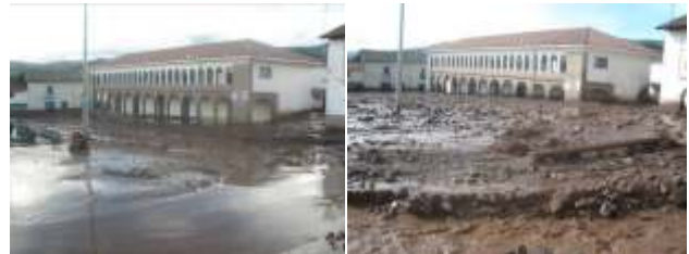
Fotos 5 y 6. Plaza de Armas de Zurite afectada por el aluvión del 28 de enero (foto de izquierda) y el aluvión del 06 de febrero (foto de lado derecho).
