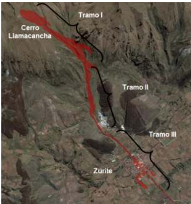
Fig. 5. Reconstrucción del deslizamiento y flujo dividido en 3 tramos
