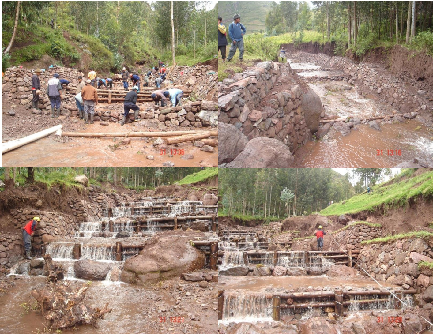
Foto 13. Construcción de disipadores de energía de las corrientes concentradas en el cauce de la quebrada, mediante diques transversales (enrocado) y canalización del cauce con muros escalonados utilizando bloques de rocas para mitigar los efectos ante la ocurrencia de un flujo de detritos.
