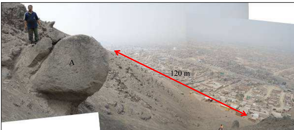
Foto N° 9.- Se muestra el bloque de roca sobresaliente (A) y otros bloques sueltos y su disposición en la ladera. En la parte baja el asentamiento humano. Nótese que el bloque se encuentra “incrustado” en el macizo rocoso.
