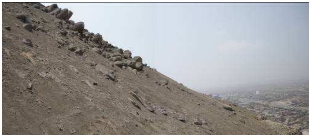
Foto N°2.- Pendiente del terreno, parte superior, mayor a 30^\circ .
