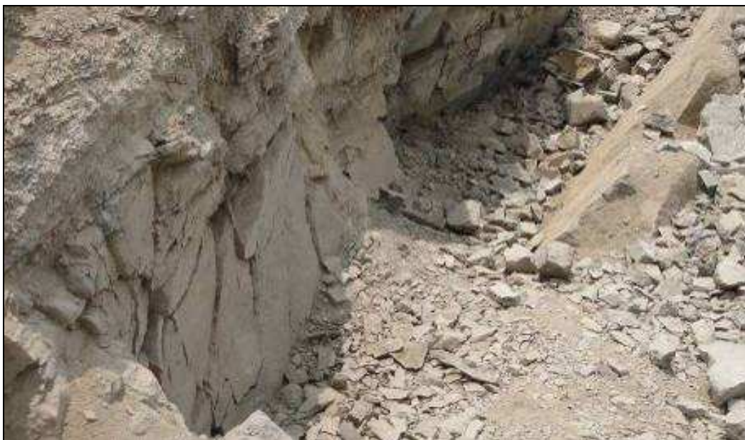
Foto N°4.- Rocas volcánicas andesíticas, medianamente fracturadas.
