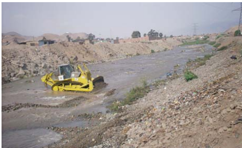
Foto 5 Remoción de material del cauce del río Chillón, en San Diego, sector afectado por inundación.
