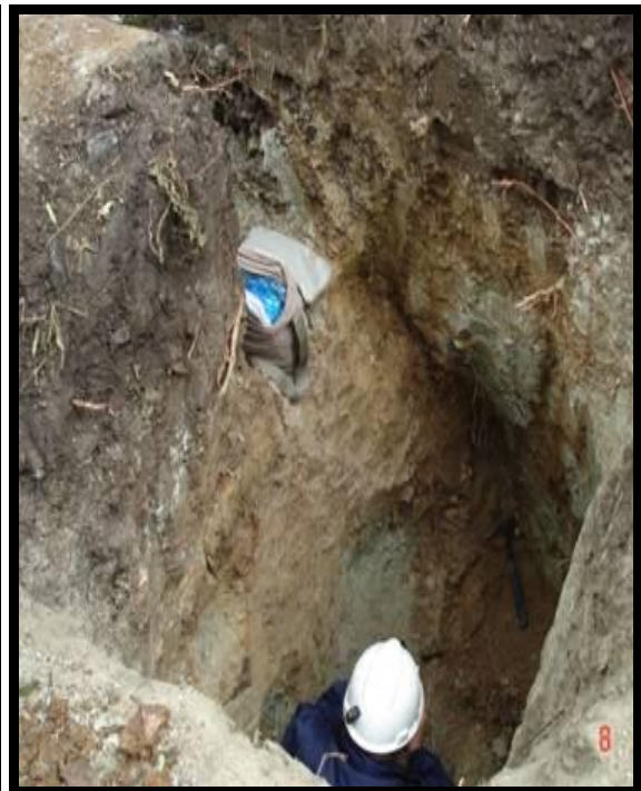
Foto Nº 52: Sécior Cerro servilleta .Valores anómalos de Cu >3000 ppm (No se descarta la existencia de pórfidos).
