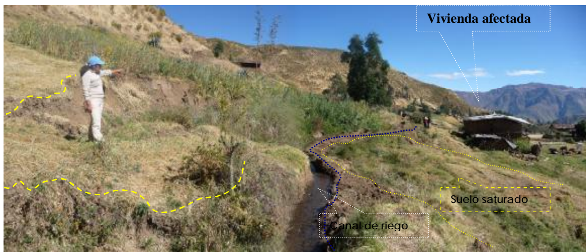
Foto N° 3 Canal de riego sin revestir, parte inferior del deslizamiento.
