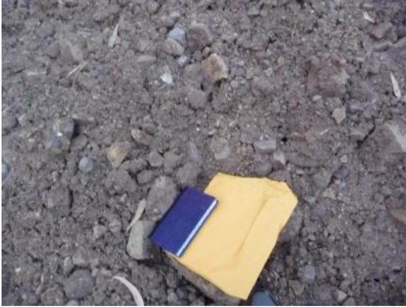
Foto. N° 14 Material del derrumbe conformado por gravas, arena, limos y arcillas
