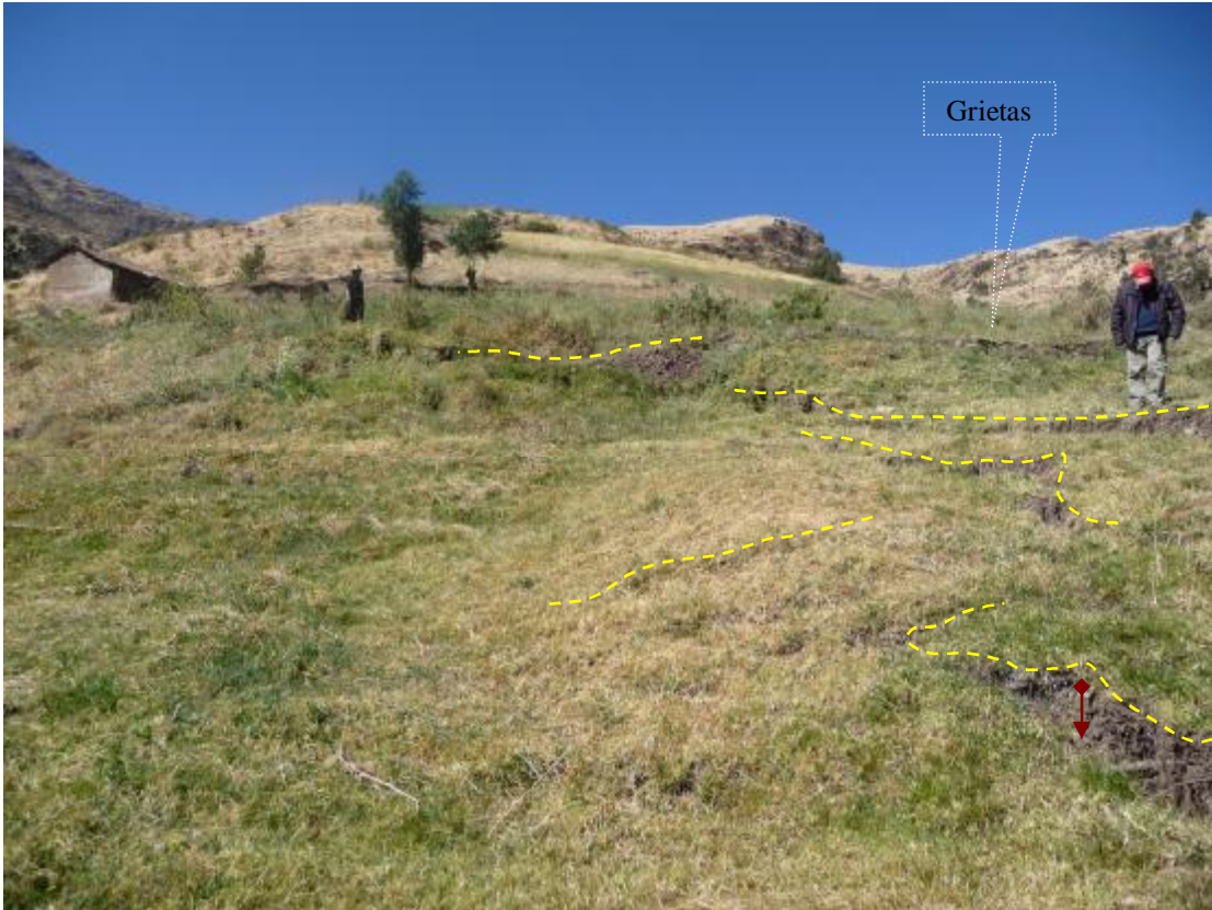
Foto N° 6 Agrietamientos de suelo con desplazamiento lateral entre 0.05 a 0.25 m
