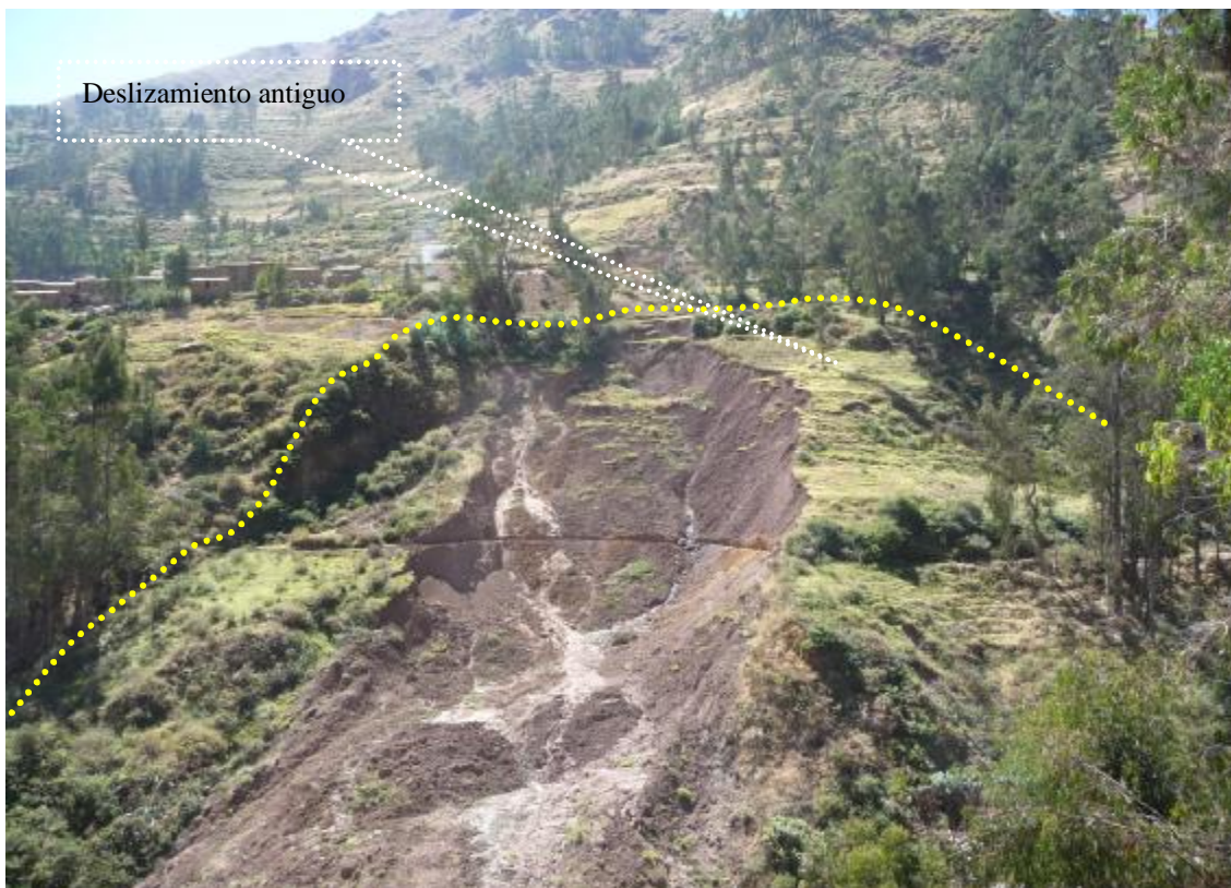
Foto N° 11 Deslizamiento del 14 de Marzo del año 1944, Lugar denominado Merendana del Barrio Lucma, obsérvese su reciente reactivación.
