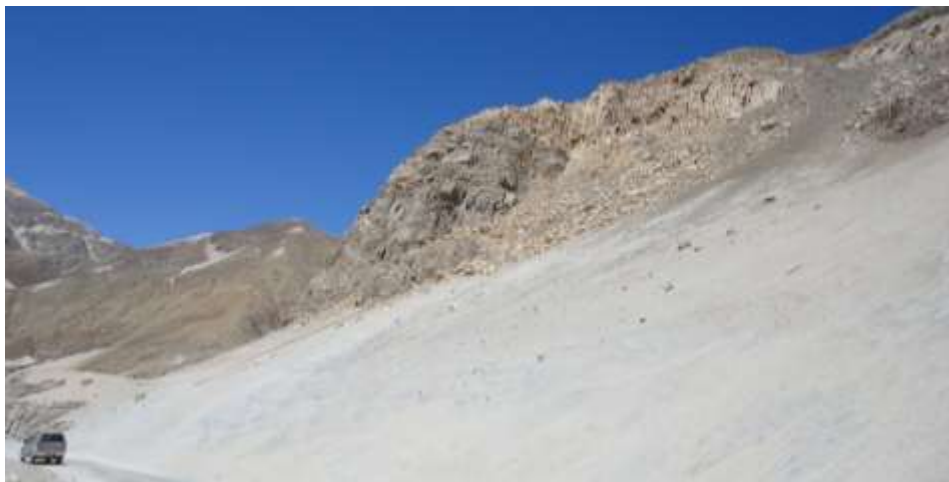
Foto 28.- Carretera Omate-Quinestaquillas, sector Campaya Caída de rocas y depósitos de cenizas que pueden ser movilizadas ante precipitaciones pluviales.
