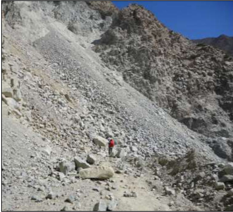
Foto 20.- Sector de Yamure. Se muestran derrumbes que afectan tramo carretero Matalaque-Quinestaquillas.
