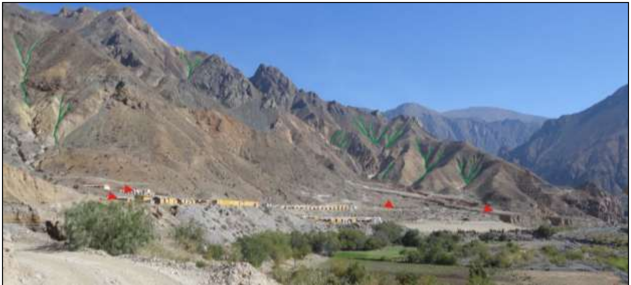
Foto 16.- Sector Candamo, se aprecian los depósitos generados por los huaycos, las flechas de color rojo muestran el sentido del desplazamiento del huayco. Las líneas verdes son erosiones de ladera.
