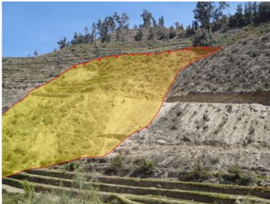
Foto 29.- Sector de Tolopampa, deslizamiento rotacional, afecta carretera afirmada Puquina-La Capilla.
