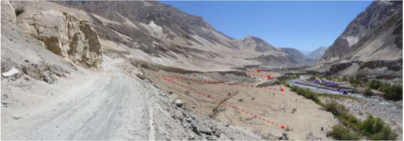
Foto 27.- Carretera Omate-Quinestaquillas, sector Campaya, se muestran los depósitos dejados por los flujos de lodo y de detritos.
