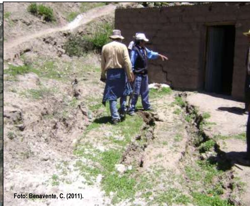
Foto 23.- Sector de Amata, se muestra el agrietamiento del terreno, que está afectando a vivienda.
