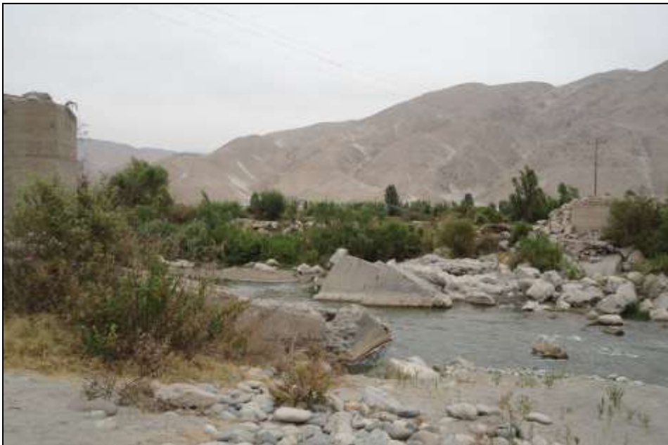
Foto 33.- Sector Puente Fiscal-Cocachacra, se observa puente destruido, que fue afectado por la erosión fluvial.
