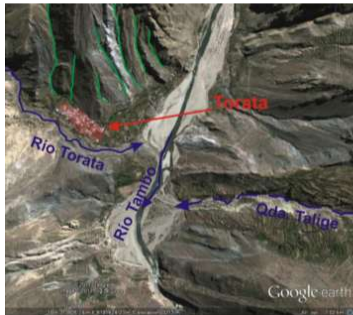
Figura 15.- Sector de Torata, asentado en la margen izquierda del río Torata, se encuentra sobre una terraza proluvial (generados por flujos). De color verde, se muestran las erosiones de ladera. También se muestra el depósito dejado por la quebrada Talige.
