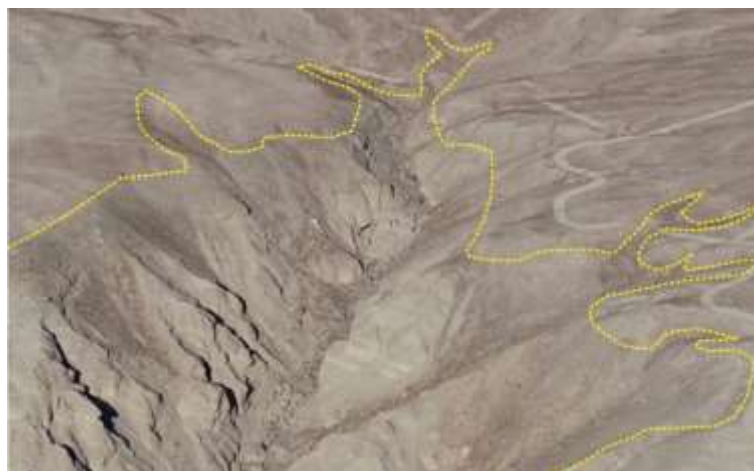
Figura 24. Vista de la quebrada que se encuentra en el extremo suroeste, se puede apreciar los procesos de erosión de laderas (líneas amarillas).
