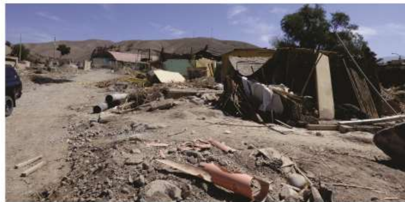
Viviendas destruidas por el paso del huaco.
