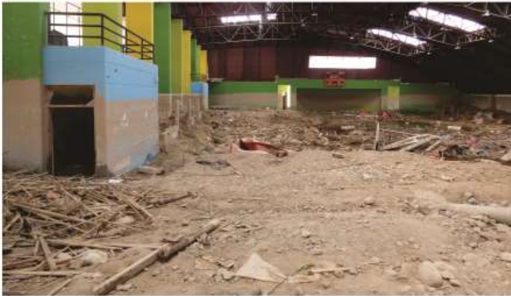
Interior del coliseo, relleno por el material que trajo el huaco.
