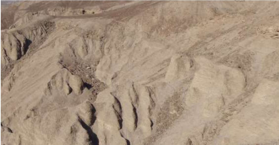
Figura 21. Sector de Oconchay, se observa parte del acantilado, afectado por procesos de erosión de laderas.
