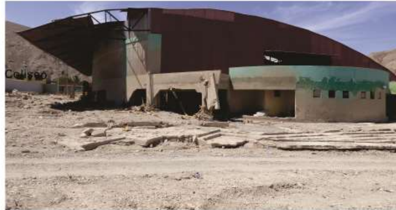
Parte de las paredes del coliseo de Mirave, destruidas.
