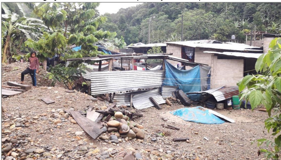
Fotografía 15. Vista de las viviendas asentadas a la margen izquierda de la quebrada Paucar.
