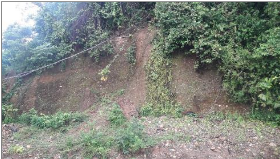
Fotografía 24. Vista de la tubería de agua que abastecía agua a la población.
