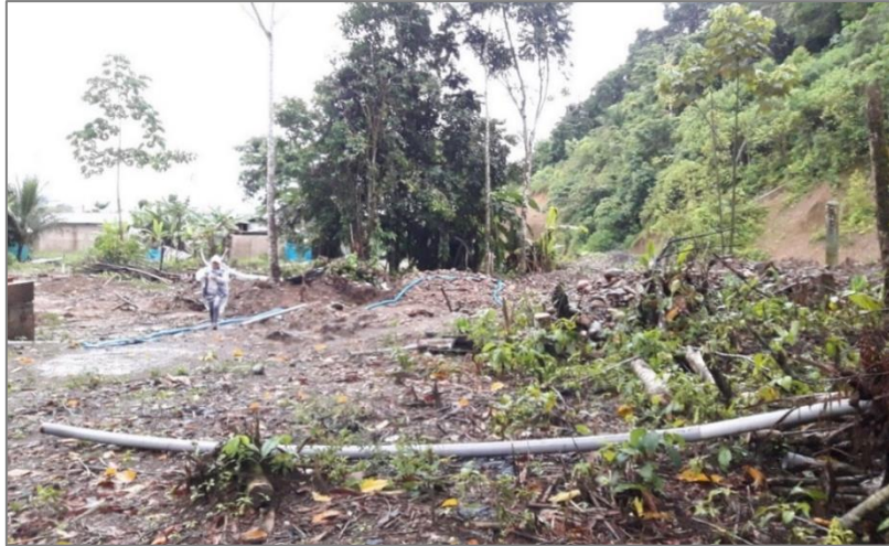
Fotografía 13. Vista de la quebrada Paucar, así mismo se observa la tubería de agua que colapsó.
