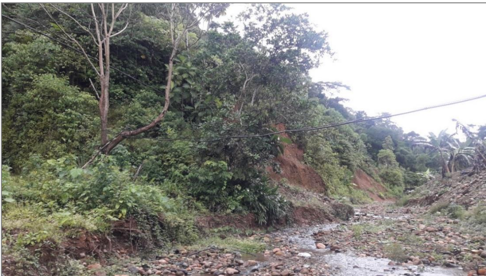
Fotografía 22. vista del deslizamiento, ubicado a la margen derecha de la quebrada Paucar.
