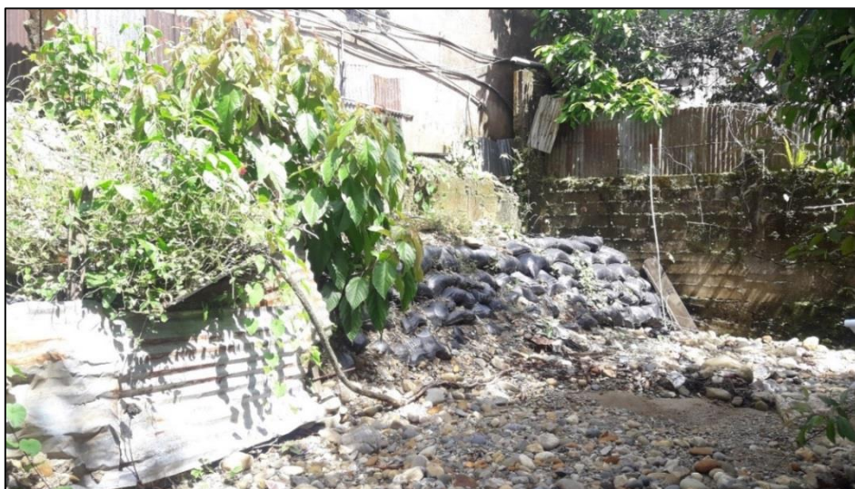
Fotografía 7. Vista de muro con bolsacretos que protege la margen izquierda de la quebrada.
