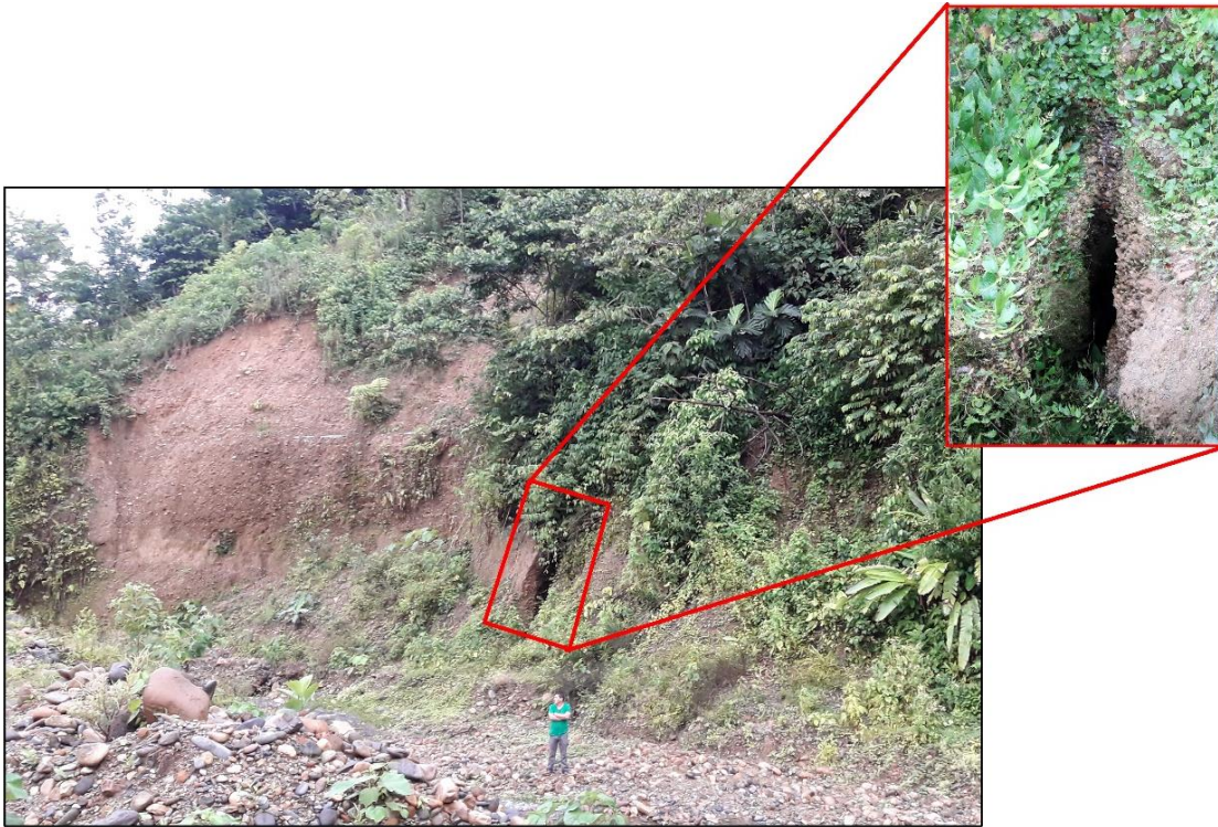
Fotografía 23. Vista del agrietamiento en el flanco derecho del derrumbe.
