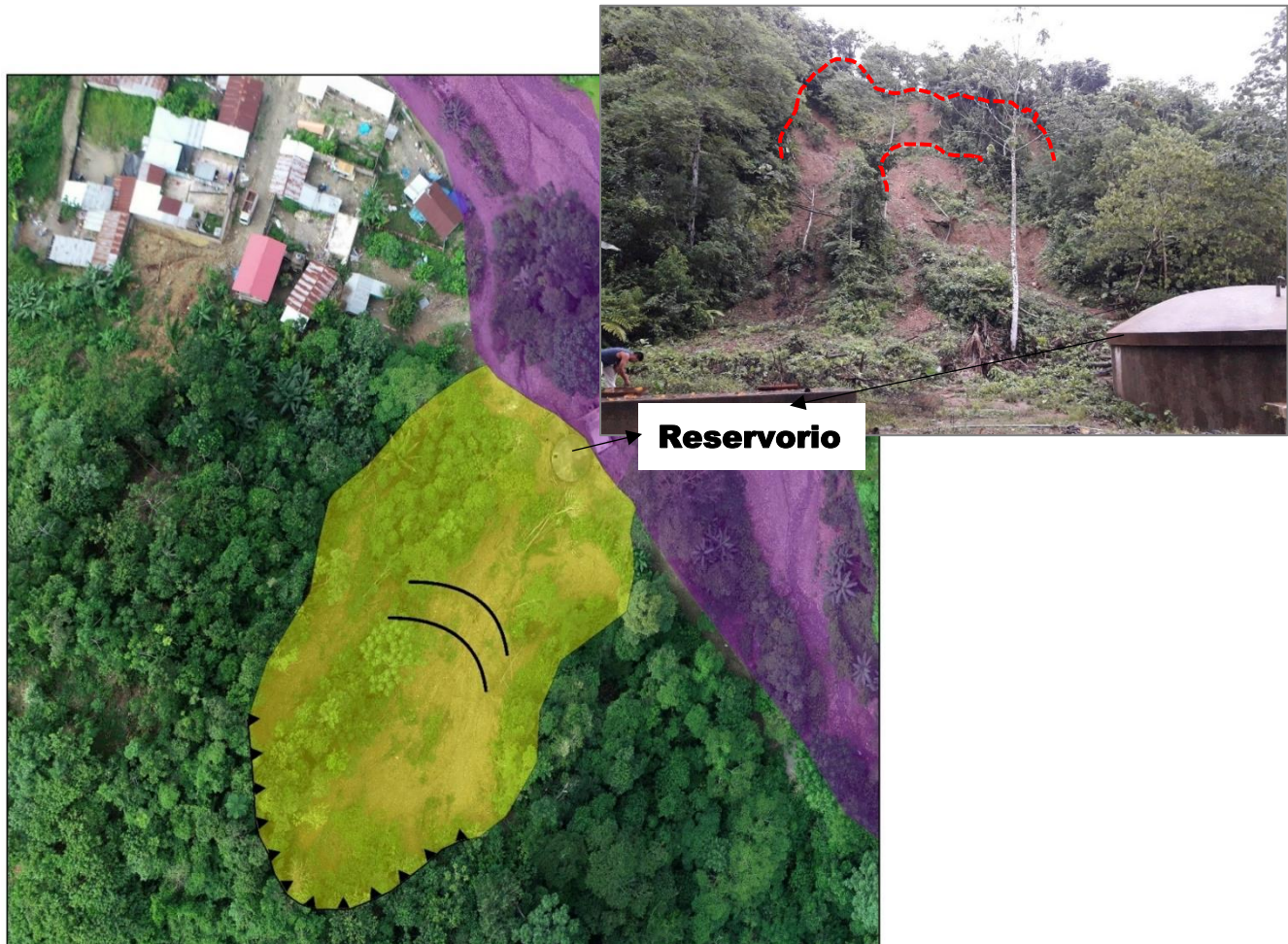
Fotografía 20. Vista de un reservorio de agua en los pies de un deslizamiento activo.
