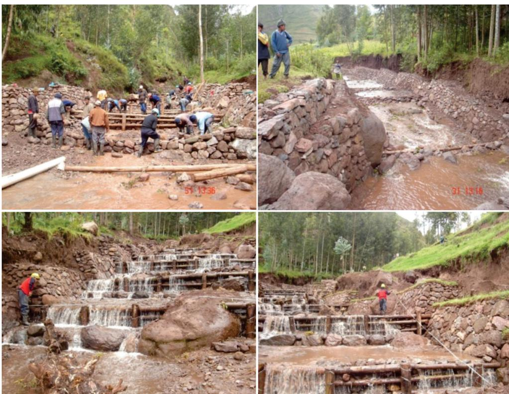
Fotografía 8.5 Construcción de disipadores de energía de las corrientes concentradas en el cauce de la quebrada, mediante diques transversales (enrocado y armazón de troncos) y canalización del cauce con muros laterales escalonados utilizando bloques de rocas para mitigar los efectos ante la ocurrencia de un flujo de detritos.
