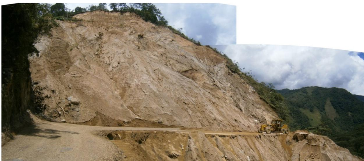
**Fotografía 7.27** Derrumbes entre los kilómetros 167+000 - 173+906 Comas-Satipo, también se generan flujos de detritos que impiden el tránsito en época de lluvias intensas.
