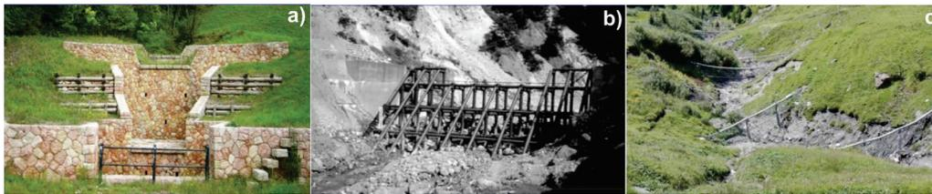
**Figura 8.14** Presas de sedimentación escalonada para controlar la fuerza destructiva de los huaicos, tipo SABO (a); tipo rejilla (b); barras flexibles (c).
