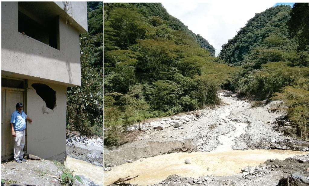
**Fotografía 7.13** Vista de los daños dejados por el huaico de la quebrada Toropaccha, orificio dejado por el run-up de 2m (izquierda). Huaico en la quebrada Toropaccha, tributario de la margen derecha del río Palca (derecha).
