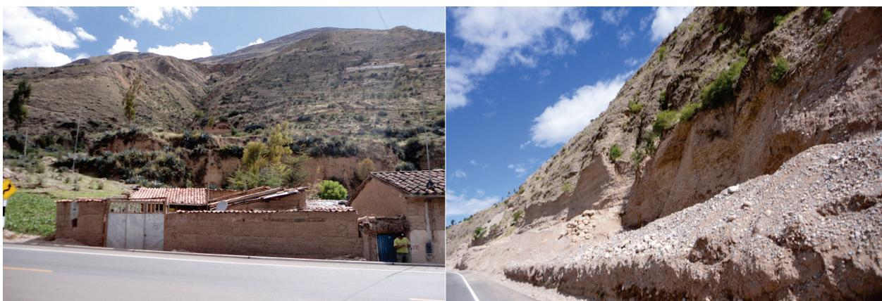
**Fotografía 7.23** Erosión en cárcavas en el sector Iscotiana, también genera derrumbes en talud superior de la carretera Chupaca-San Blas.
