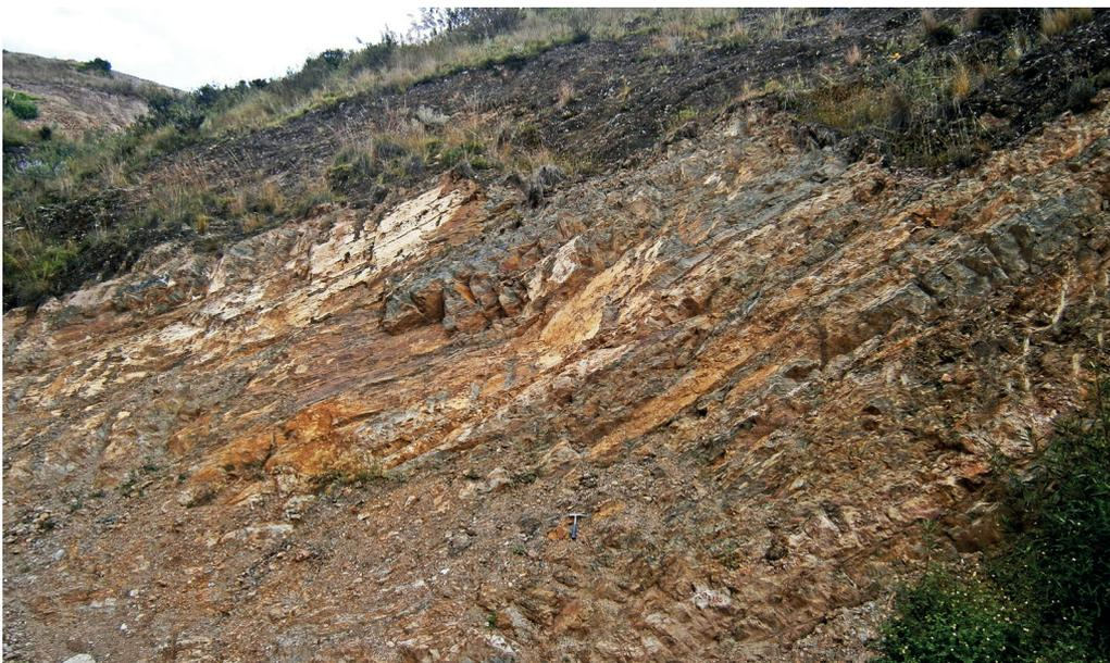
**Fotografía 3.12** Afloramiento de lutitas y lodolitas de la Formación Jauja que sobreyace a una capa de microconglomerados, en el km 20+180 de la carretera Mito-Aco.
