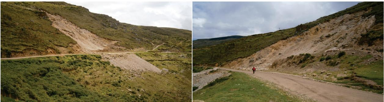
**Fotografía 6.2** Derrumbes en talud superior de la trocha carrozable Congas-Tapo, altura del km 26+000.
