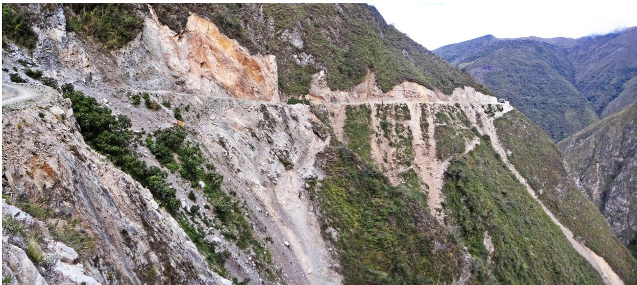
**Fotografía 7.4** Derrumbes provocados por el corte del talud para construir la carretera Anturqui – Huanchuiro (San Pedro de Cajas, Tarma).
