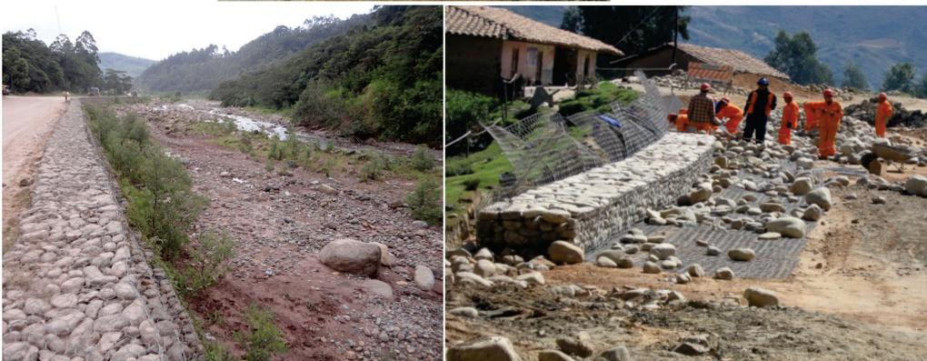
**Fotografía 8.9** Ejemplos de uso de enrocados y muros de gaviones para protección de carretera. En muchos casos esto debe estar acompañado de un levantamiento de la rasante de la carretera.
