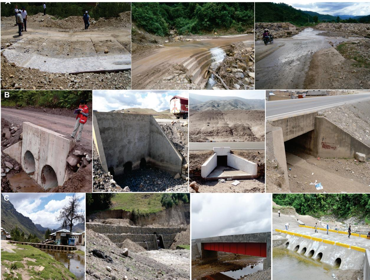
**Fotografía 8.6** Obras de drenaje para redes viales, A) badenes, B) alcantarillas y pontones y C) puentes, puentes-badén.
