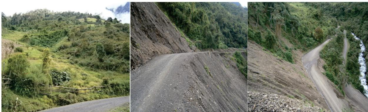
**Fotografía 7.25** Deslizamiento activo con presencia de asentamientos y derrumbes en la carretera Comas - Satipo, en el km 152+950.
