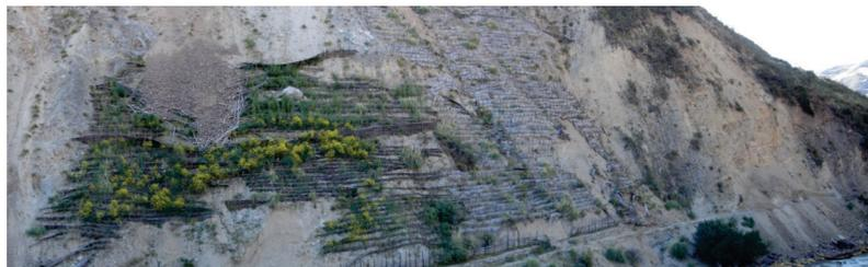
**Fotografía 8.8** Ejemplo de evacuación de aguas superficiales y control de erosión en cárcavas, mediante trinchos escalonados.
