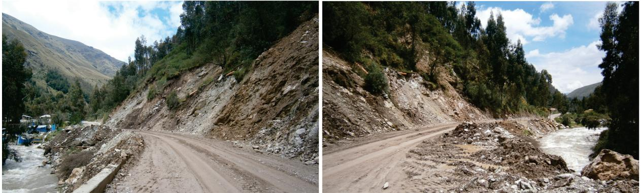
**Fotografía 7.29** Derrumbes en el talud superior de la carretera a Huancayo, tramo km 4+800 al km 7+100 de la carretera, ambas márgenes del río Shullcas.
