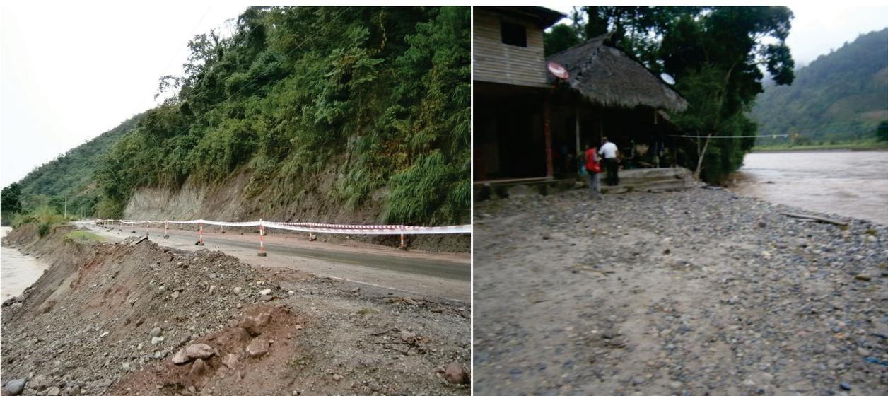
**Fotografía 7.9** Erosión fluvial en la margen derecha del río Perené, afecta tramo de la Carretera Marginal, sector Shintoriato (izquierda). A la derecha se observa el sector Bajo Quivinaqui ubicado en la margen derecha del río Perené en confluencia con el río Ubiriqui afectado por el desborde del río.
