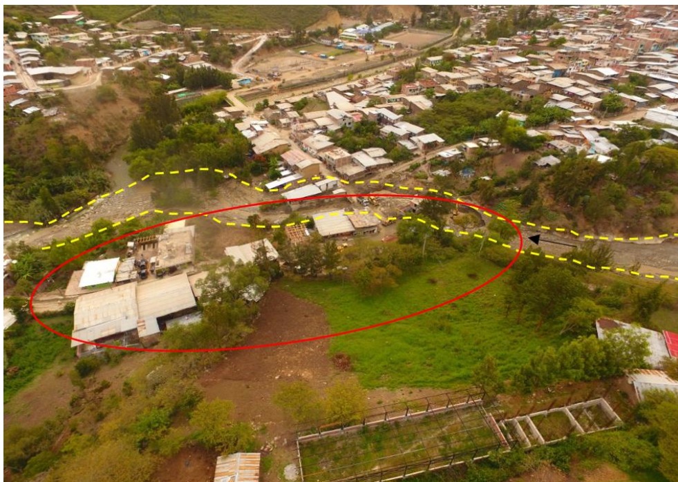
Figura 16: Vista de las viviendas afectadas en la zona urbana de la ciudad de Huancabamba. En el círculo rojo, se delimitan las moradas que se han construido en las márgenes de la quebrada Ungulo.
