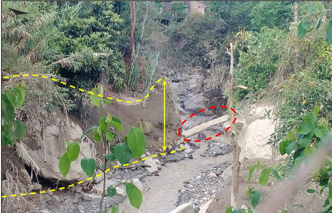
Figura 23: Sector Cerro Colorado, se puede observar la huella del flujo de detritos – huayco, con una altura de hasta 3 metros, así como el estrechamiento del cauce, presencia de clastos y bloques en el lecho de la quebrada. Nótese un tronco obstruido en la zona más estrecha.
