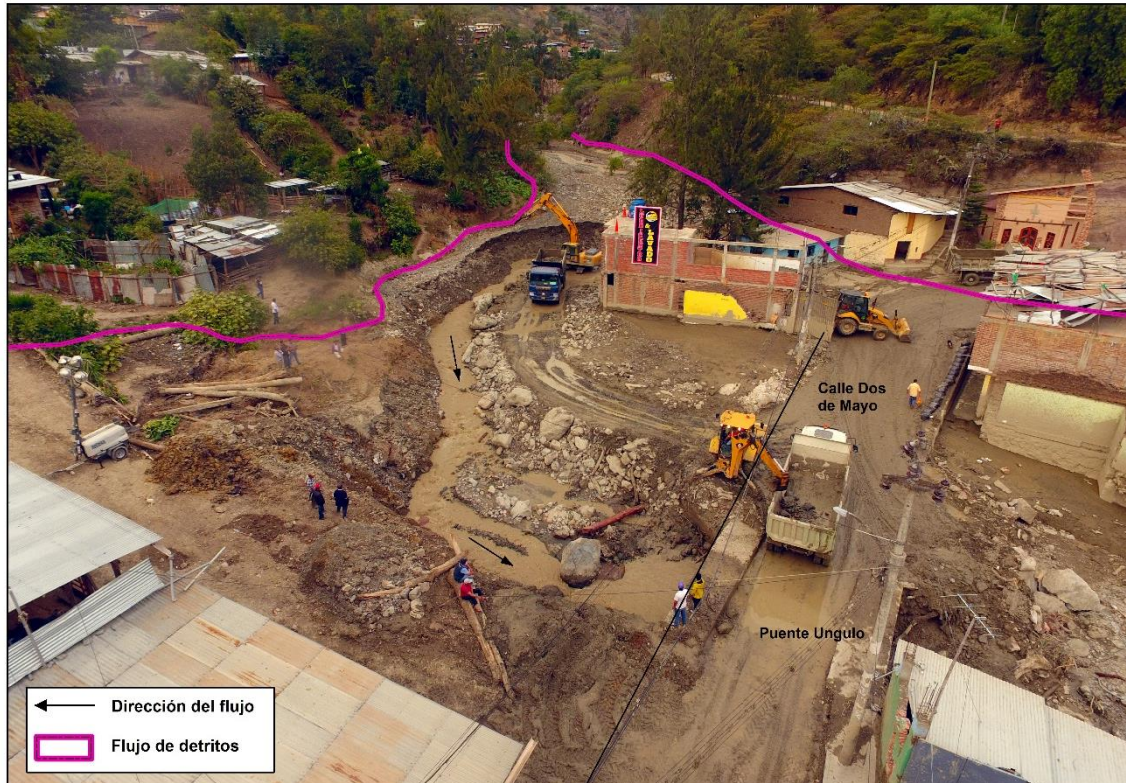
Figura 3: Vista de las viviendas ubicadas en el cauce de la quebrada Ungulo y en las márgenes del mismo que han sido gravemente afectadas por el huaico.
