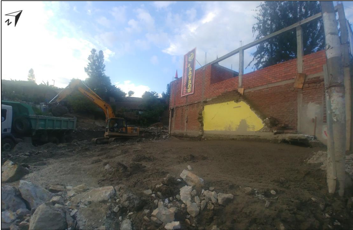
Fotografía 4: Vivienda colapsada por arrastre de material del huaico.
