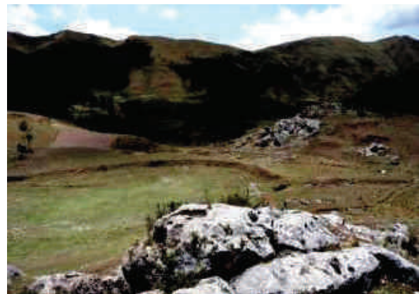
Foto 3. Qocha 2, el Muro 3 y canal a Qocha 3
