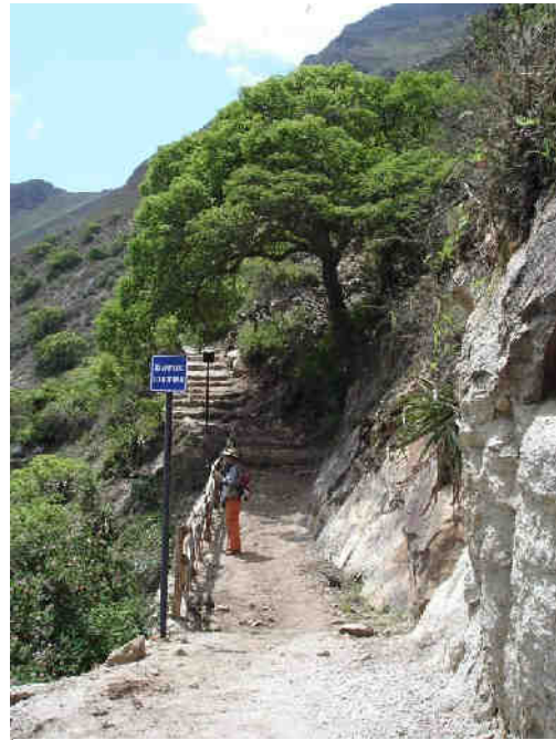
Foto 5: Camino con problemas de caída de rocas.
