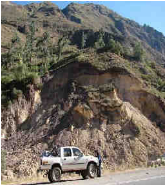
Foto 4. Deslizamiento Rotacional Huaripampa-Matucana
