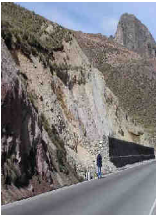
Foto 3. Derrumbe en Casanalca
