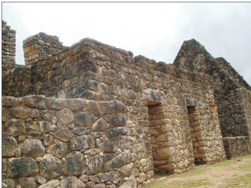
Foto 50. Recintos 6, 7 y 8 del Conjunto 10, luego de la restauración. Foto tomada el año 2007.
