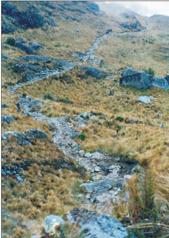
Foto 6. Bajada del abra de Runkurakay hacia Sayaqmarka, donde se ven los efectos de la erosión superficial en el año 1994. Actualmente se halla restaurada.
