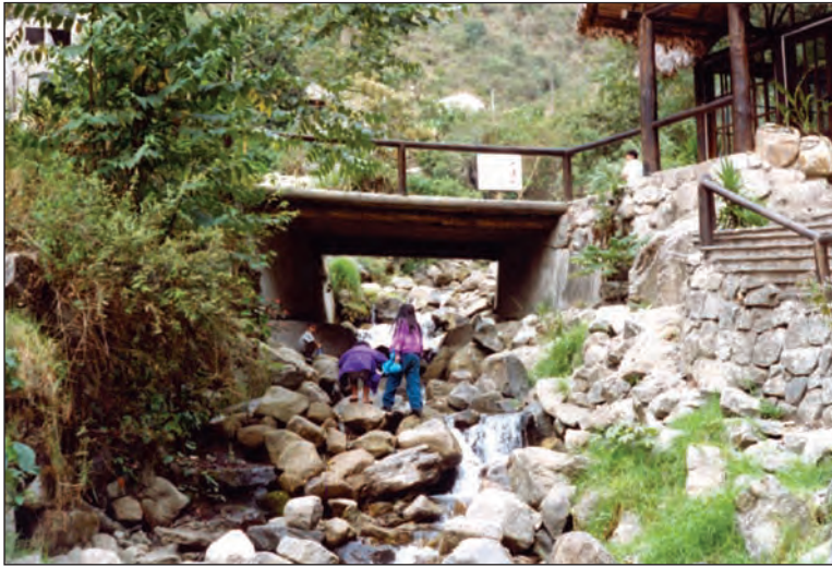
Foto 4. Puente angosto del tren en la quebrada Alcamayo. Vista tomada el año 2000.
