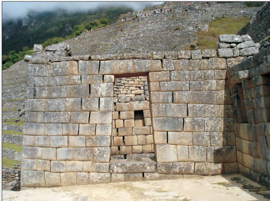
Foto 41. Separación de juntas en el muro norte del Recinto 5. Al fondo de la puerta se nota la separación de juntas en el Aposento de la Ñusta.
