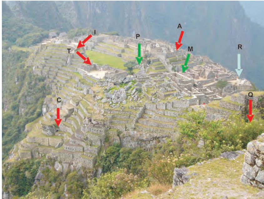
Fig. 1. Sitio arqueológico de Machupicchu con la localización de las mediciones de dilatómetros: C: Cueva (midiendo el sitio C1); T: Templo Principal (T1, T2, T3); I: Intiwatana (I1, I2, I3); P: Plaza (P1); W: Waynapicchu (W1, W2, W3); A: Acllawasi (A1); M: Wairana o Mirador (M1, M2, M3, M4); R: Rodadero (R1, R2, R3); Q: Qhata (Q1). Evaluación cualitativa de la tendencia de los movimientos. Color rojo: movimientos irreversibles; color verde: sin ningún movimiento irreversible; azul claro: no puede ser interpretado aún. Tomado y modificado de Vilímek et al. (2005).
