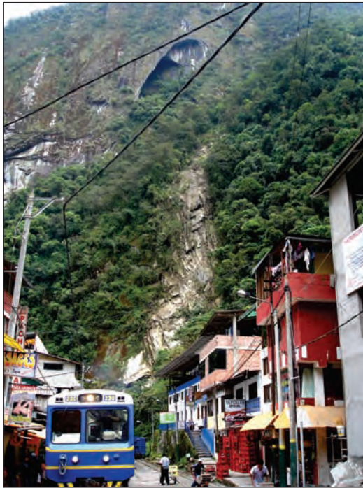
Foto 10. Derrumbe producido el año 2007 en la salida del poblado de Machupicchu hacia Puente Ruinas. Al pie del derrumbe se pretendía ubicar el punto de partida del teleférico .
