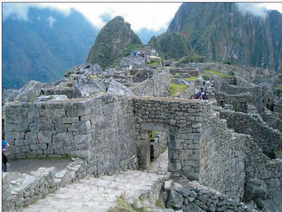
Foto 63. Muro con separación de juntas (izquierda) y Puerta de la Ciudad (derecha).
