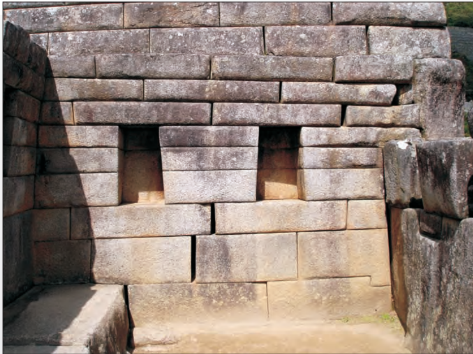
Foto 22. Cámara de los ornamentos con separación de juntas en la pared interior sur.
