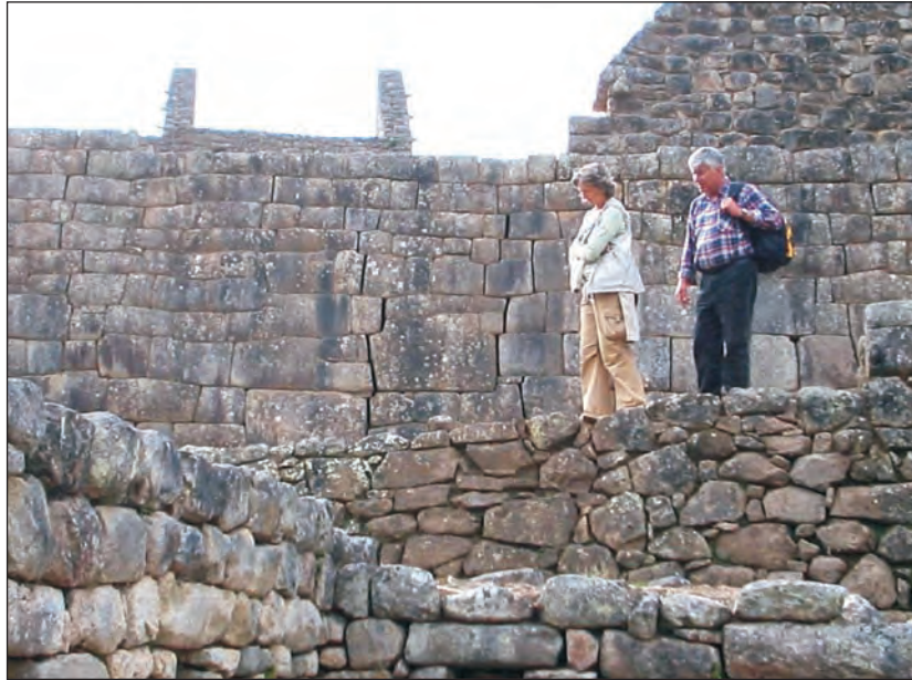
Foto 57. Separación de juntas en la pared sur del Conjunto 16.
