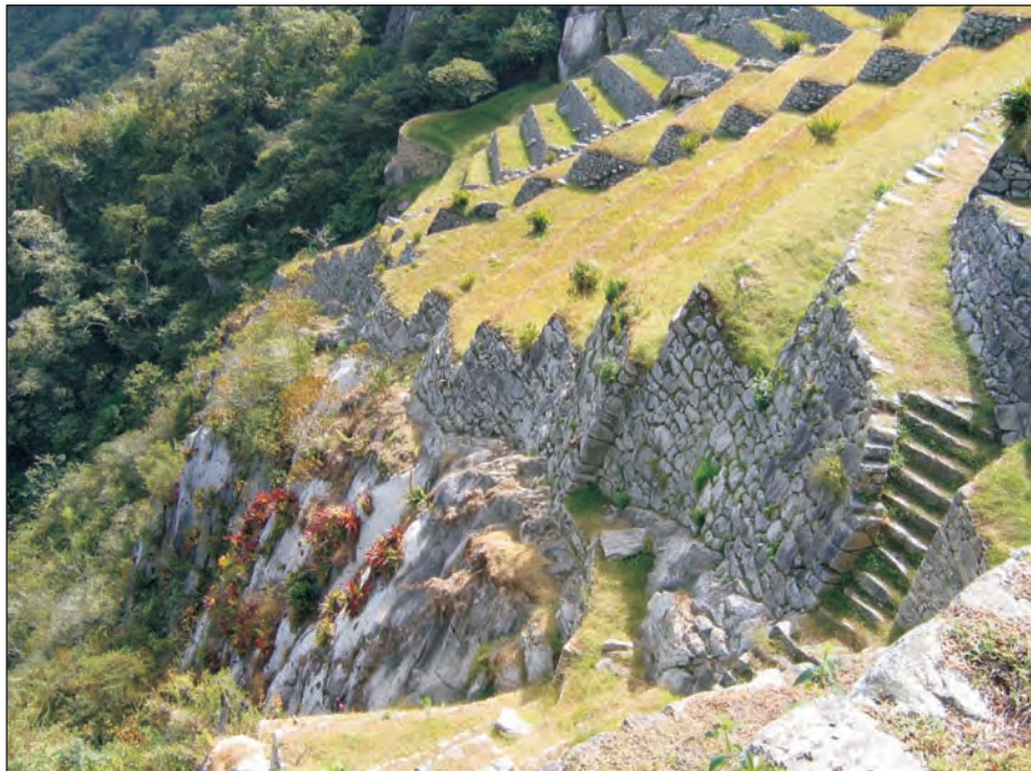
Foto 64. Andenes construidos sobre roca estable.
