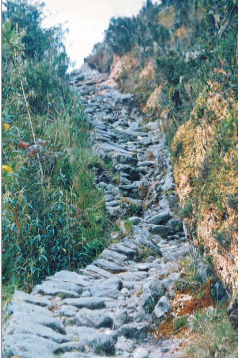
Foto 15. Camino afectado por erosión superficial y sufusión en Chaquicocha (1994). Actualmente se halla restaurado.
