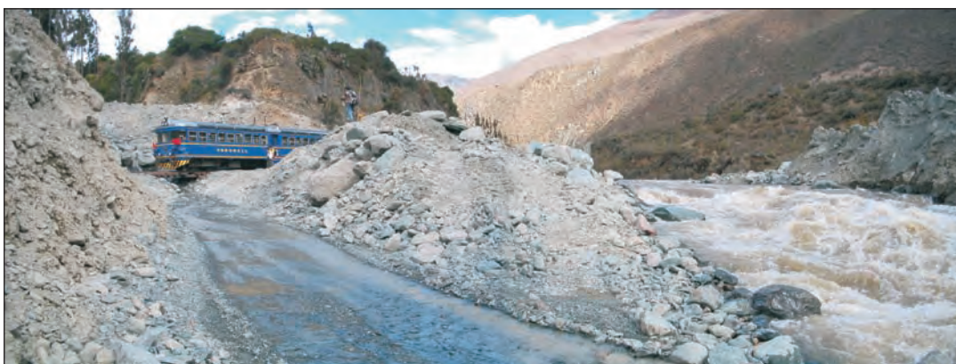
Foto 5. Línea férrea habilitada después del 12 de octubre del 2005. Nótese los depósitos del aluvión en ambas márgenes del río Urubamba.
