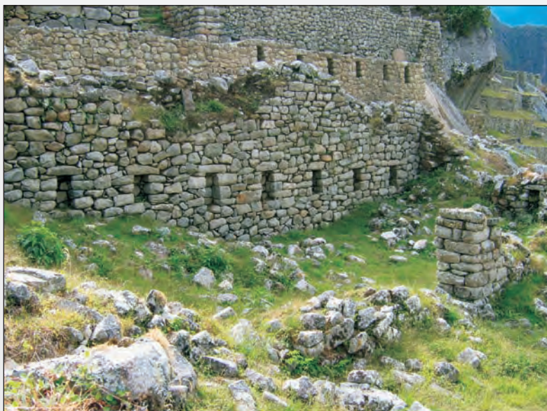
Foto 55. Muros caídos y piedras labradas amontonadas en el Conjunto 13.
