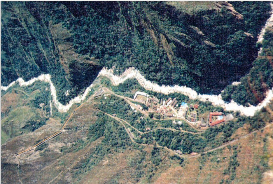
Foto 6. Central Hidroeléctrica de Machupicchu en el valle del Urubamba, antes del represamiento por efecto del aluvión de Aobamba de 1998.
