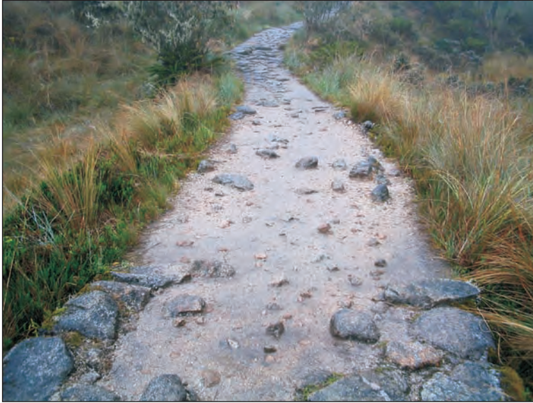
Foto 21. Erosión superficial y proceso de arenación entre Chaquicocha y el Túnel.
