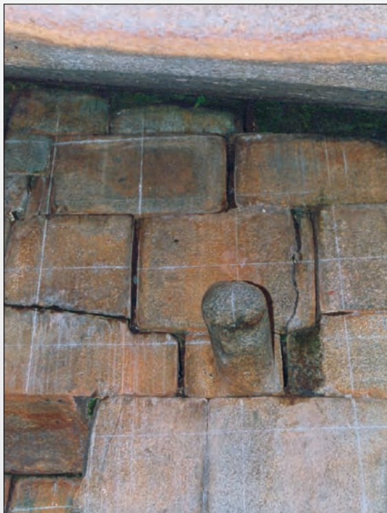
Foto 43. Muro norte y contacto con el bloque granítico que sirve de techo en la Tumba Real. Nótese una piedra labrada fracturada.
