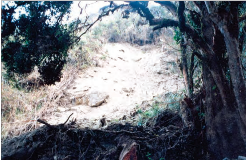
Foto 12. Deslizamiento que afecta el camino inca en la subida a Warmiwañusqa.
