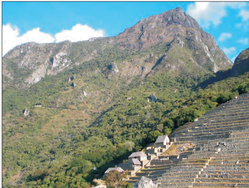
Foto 16. Deslizamiento de la ladera norte del cerro Machupicchu, sobre el que están construidos el camino inca y la carretera de acceso a la ciudad inca.
