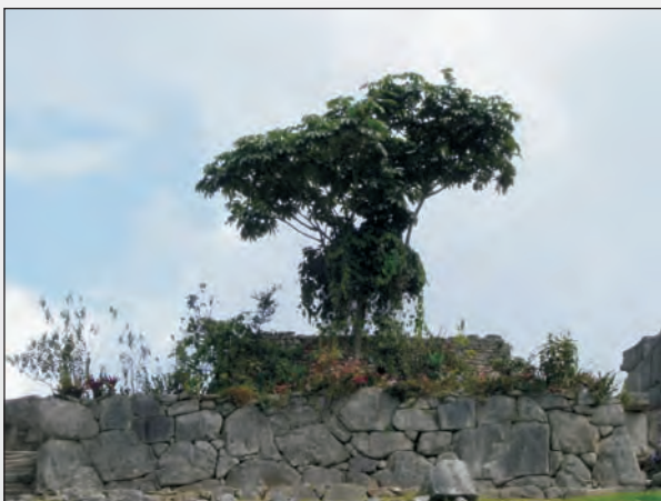
Foto 28. Separación de juntas por asentamiento en el recinto denominado Jardín.
