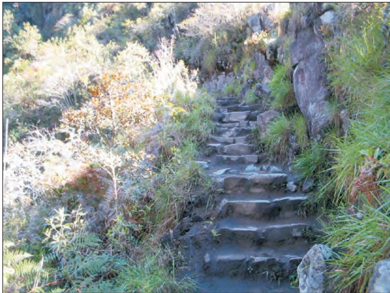
Foto 14. Erosión superficial de los suelos en el camino inca que comunica a la ciudad inca con Waynapicchu.
