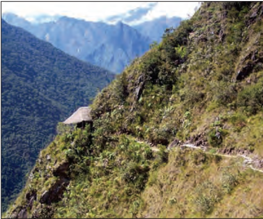
Foto 5. Ladera muy empinada del tramo 4 del camino inca que está sobre granitos y suelos coluviales.
