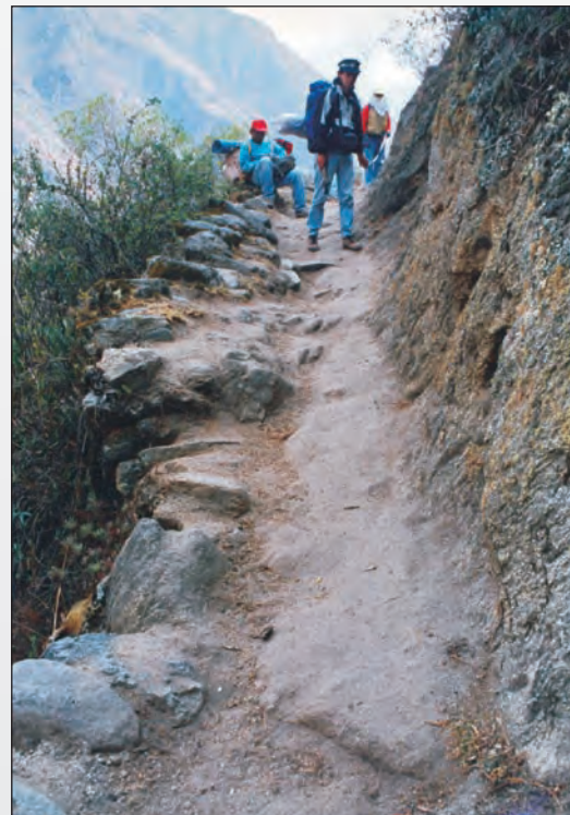
Foto 3. Camino sobre granitos intemperizados, con lajas y muros deteriorados por erosión superficial. Vista tomada el año 1994. Tramo Qoriwayrachina-Wayllabamba.
