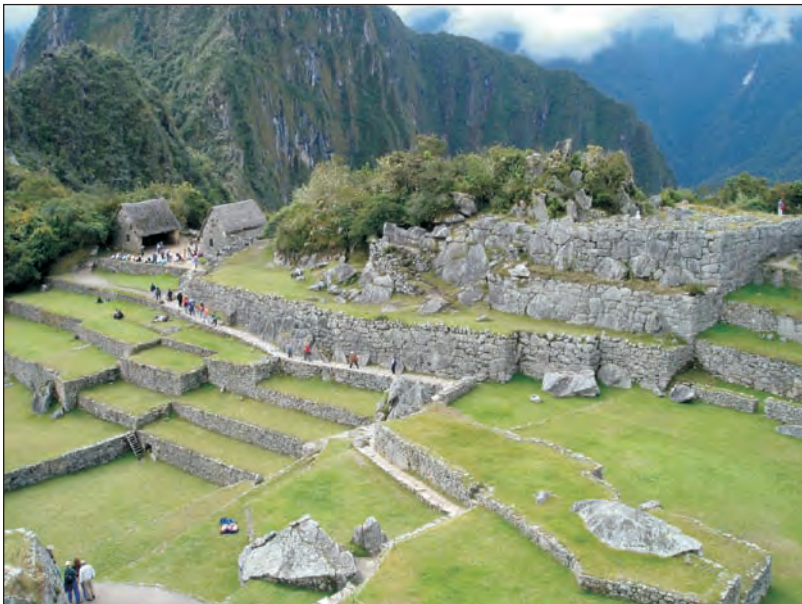
Foto 12. Caos granítico en el Conjunto 6 estabilizado con muros y andenes.
