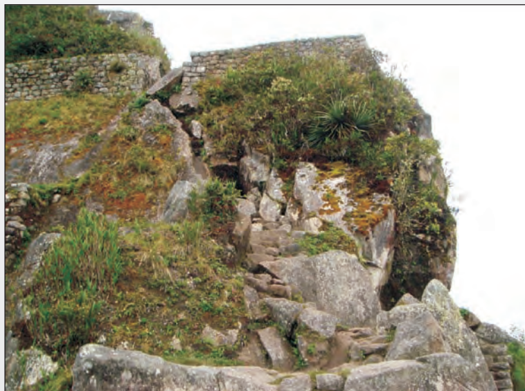
Foto 77. Bloque de granito fracturado en vías de separación del afloramiento en el cerro Waynapicchu. La fractura atraviesa el camino inca para llegar a la cima.
