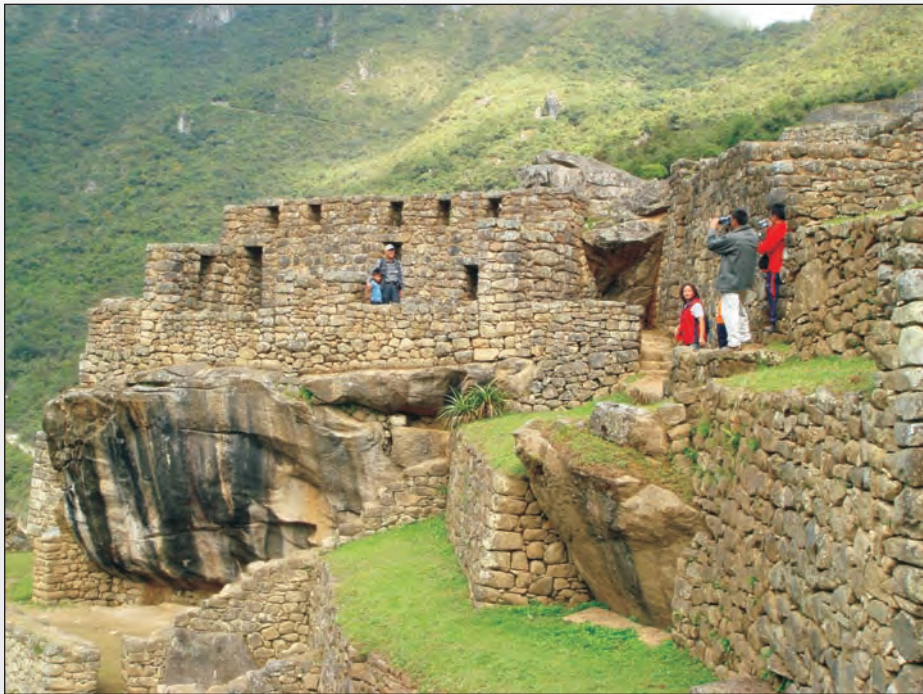
Foto 52. Construcciones incas en el Conjunto 12 sobre grandes bloques de granito estabilizado.
