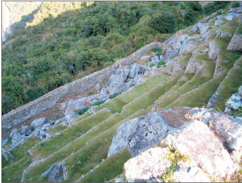
Foto 8. Bloques de granitos caídos en la ladera oriental de la ciudad inca de Machupicchu, Conjunto de Andenes 12.
