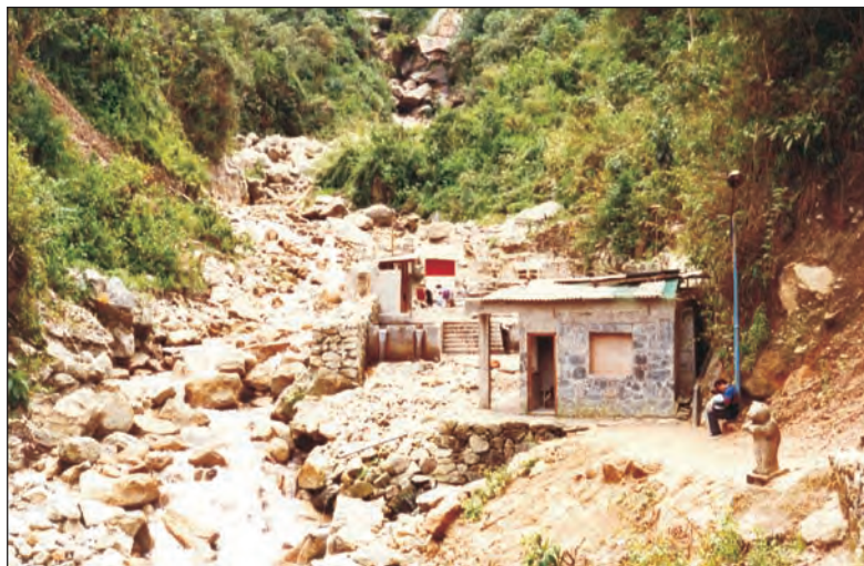
Foto 2. Quebrada Aguas Calientes y los baños termales construidas en pleno cauce del río. La infraestructura fue afectada por el aluvión de 1995.
