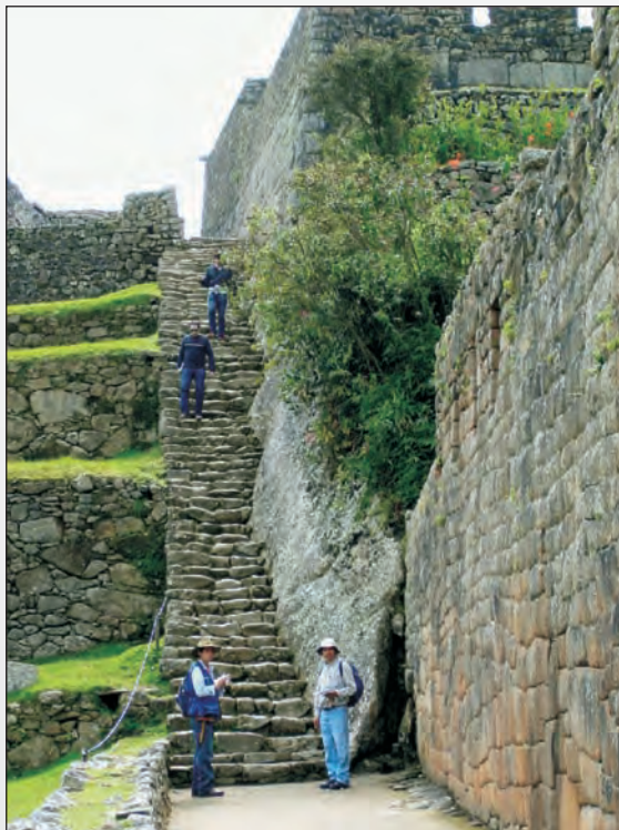
Foto 58. Graderías apoyadas en granitos fracturados en la pared oeste del Conjunto 15.
