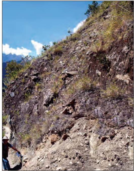
Foto 3. Derrumbe que afectan el Camino Sagrado en el tramo 2.
