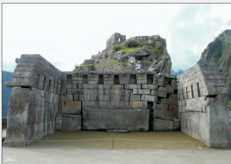
Foto 21. Templo Principal. Nótese el asentamiento diferencial de la pared interior norte.
