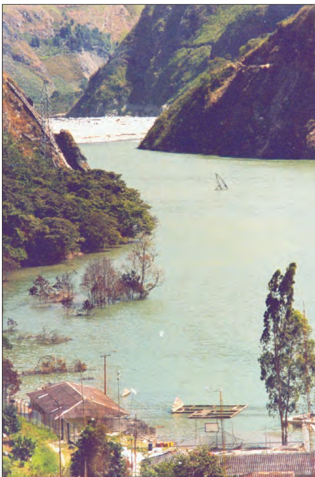
Foto 8. Represamiento del río Urubamba que provocó la destrucción de la Central Hidroeléctrica de Machupicchu (1998).
