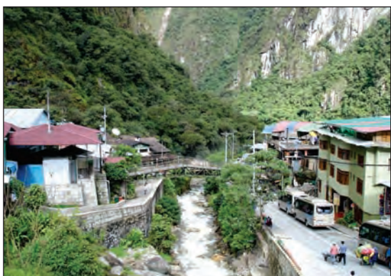
Foto 12. Quebrada Aguas Calientes con muros de encauzamiento y tratamiento paisajístico (2007).
