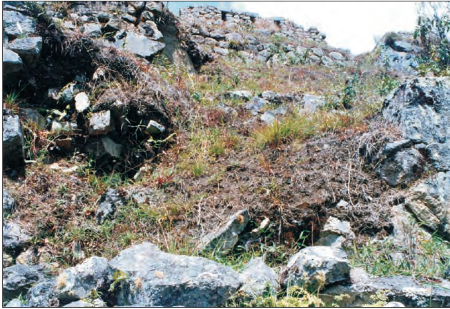
Foto 71. Deslizamiento que afectó al Conjunto de Andenes 13. Vista tomada el año 1994.
