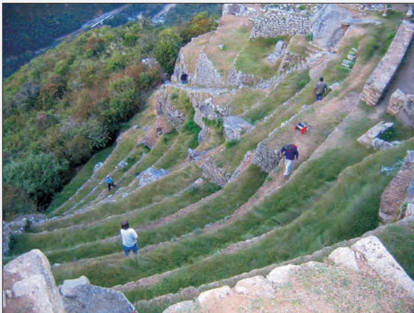
Foto 70. Deslizamiento estabilizado por los incas mediante las terrazas del Conjunto de Andenes 13.
