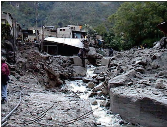
Foto 5. Quebrada Alcamayo luego del aluvión del 2004 que destruyó los puentes y las construcciones de la ribera.
