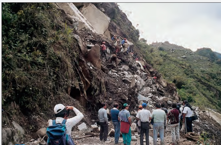
Foto 24. Derrumbe ocurrido el 26 de diciembre de 1995 y que interrumpió la carretera de acceso a la ciudad inca.
