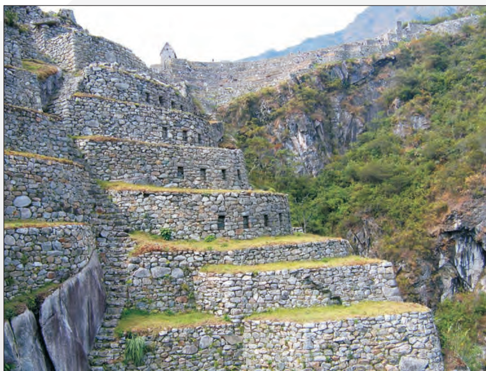
Foto 7. Andenes que estabilizan las laderas empinadas en la parte occidental de la ciudad inca de Machupicchu, Conjunto de Andenes 6.
