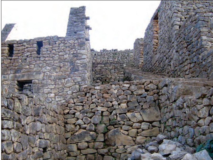
Foto 51. Conjunto 11 en buen estado de conservación.
