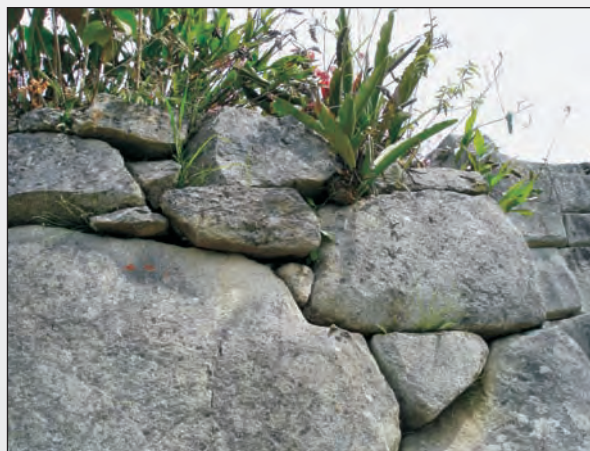
Foto 28. Separación de juntas por asentamiento en el recinto denominado Jardín.
