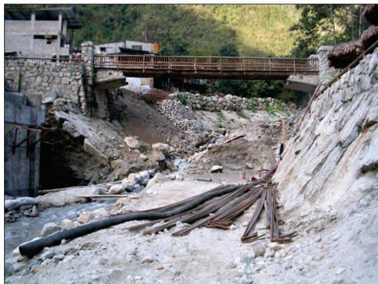
Foto 6. Nuevo puente del tren después del aluvión del 2004, compárese con la Foto 4.
