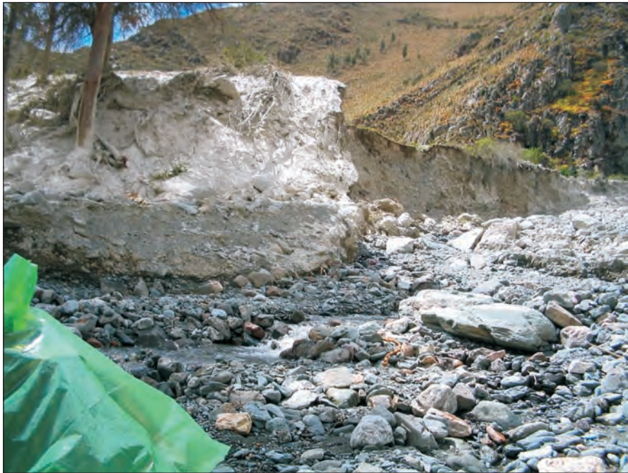
Foto 2. Zona de trayecto con áreas con erosión y desborde del flujo de detritos.
