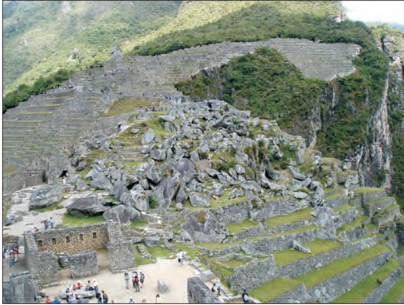
Foto 11. Caos granítico en el sector conocido como la cantera. Nótese que los andenes estaban en plena construcción.
