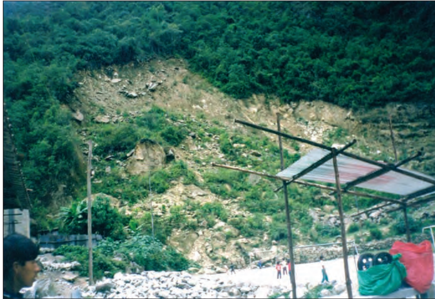
Foto 7. Deslizamiento en Las Orquídeas en el año 1999.
