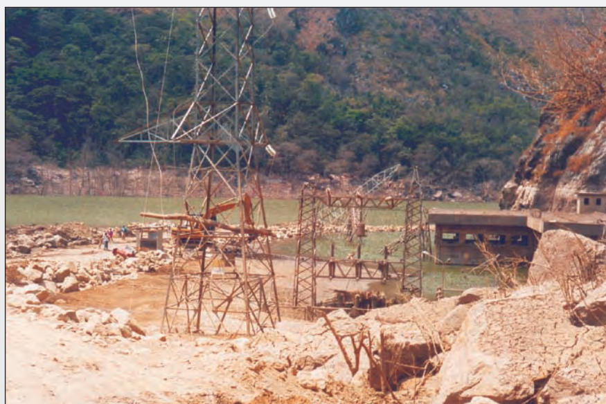
Foto 9. Vista tomada después del desembalse del represamiento del río Urubamba. La foto muestra la sala de máquinas y el antiguo nivel del agua.
