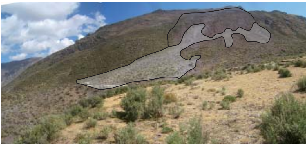
Deslizamiento en el talud superior que afecta tramo de la carretera. Se resalta la escarpa o zona de arranque y el material deslizado.
