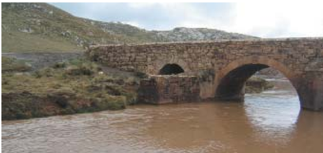
Puente sobre el río San Juan.
