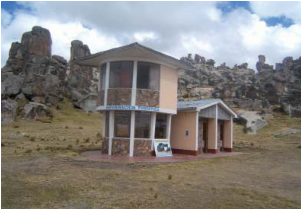
Módulo de información turística en la localidad de Canchacucho. Cuentan con baños
