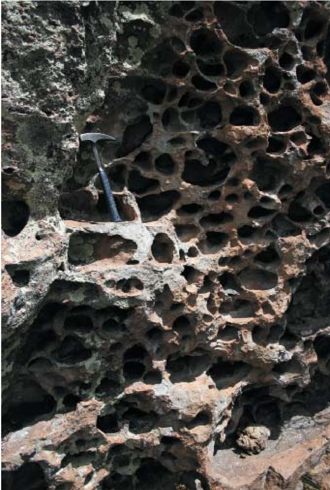
Detalle de erosión y desarrollo de "alveolos y tafonis" en las ignimbritas Huayllay.
