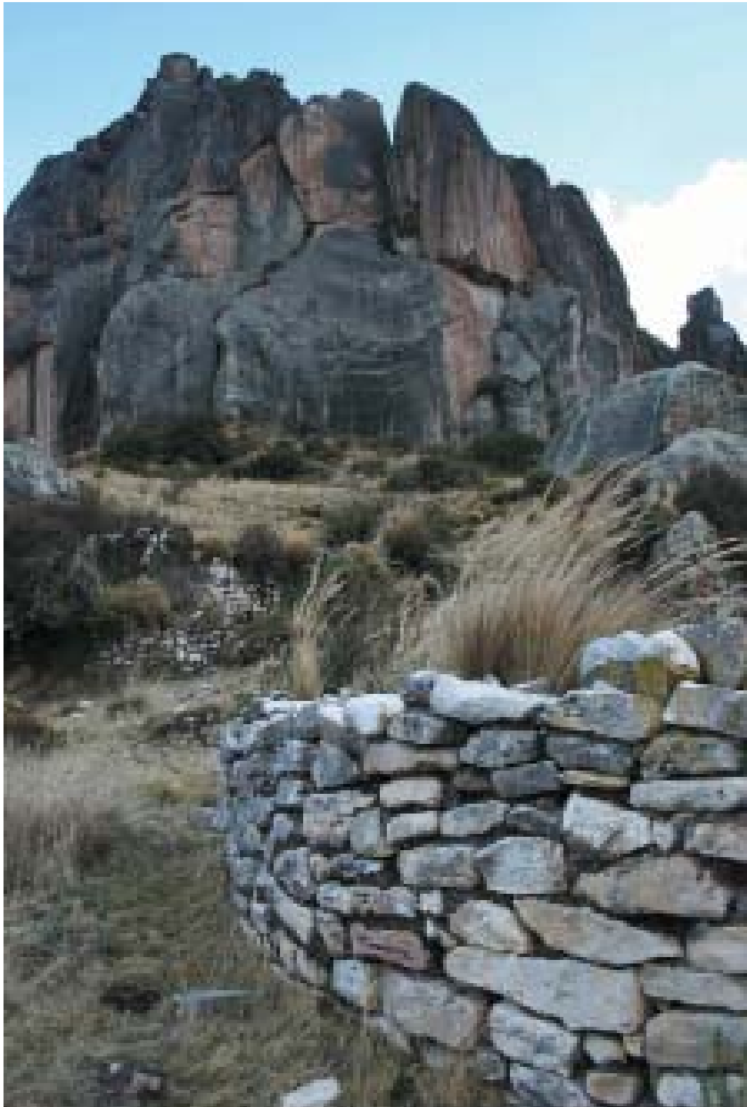
Detalle de los muros circulares hechos en bloques aplanados de piedra caliza.
