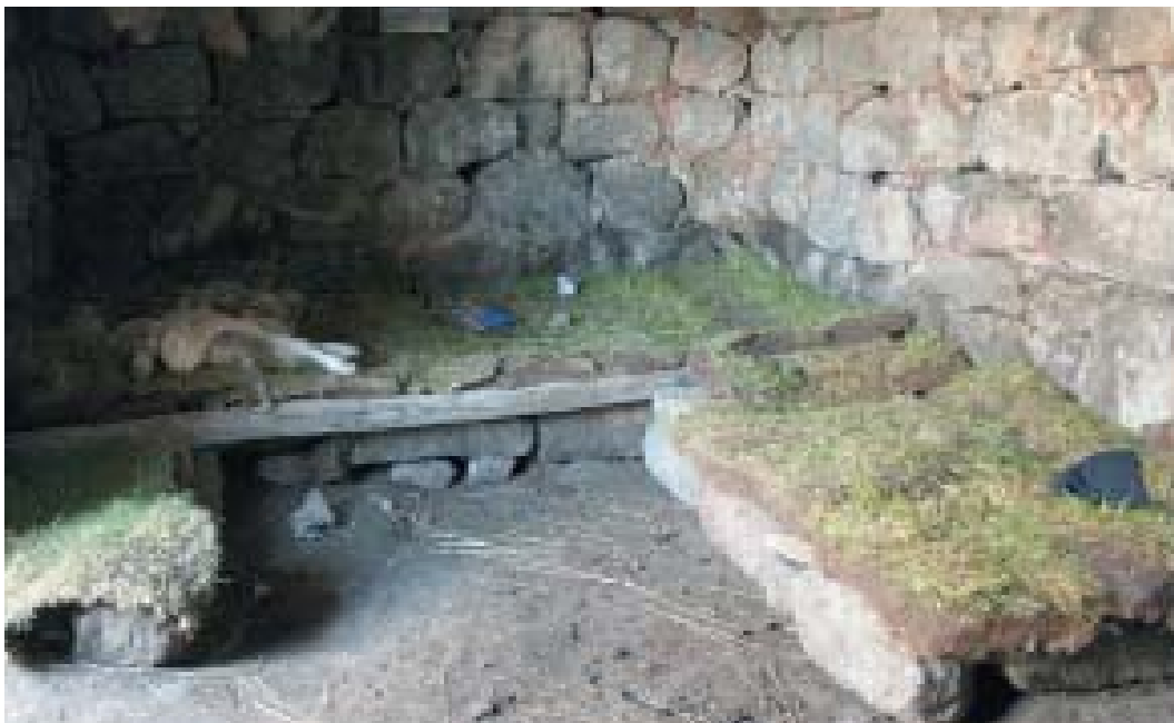
Estancia en Gochahuaman. El detalle de la construcción en el interior muestra la utilización de argamasa (arcilla roja).
