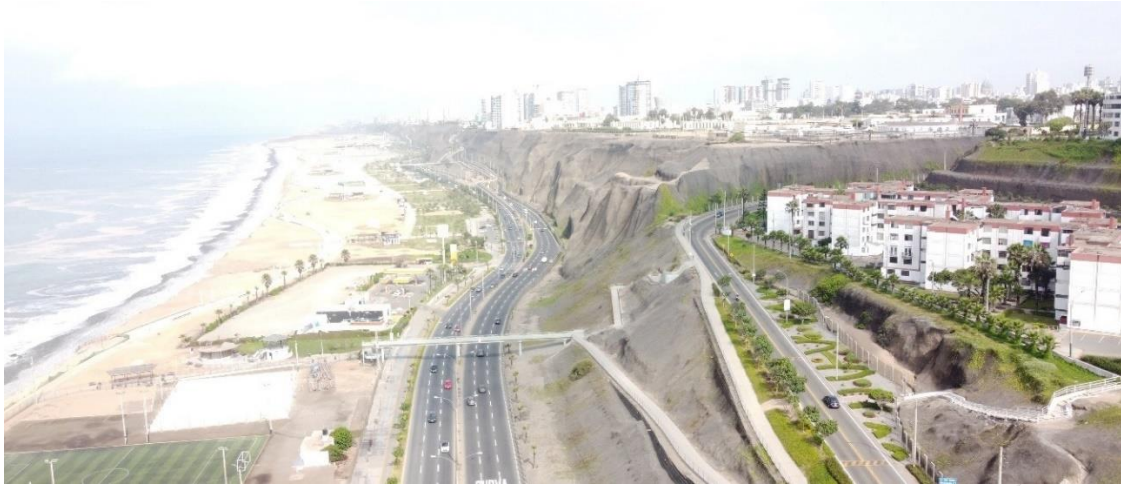
Figura 134. Vista hacia el terraplén construido como vía de acceso.
