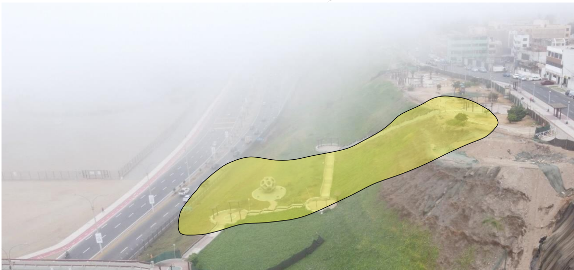
Figura 265. Deslizamiento en las inmediaciones del parque Belén, vista de sureste a noroeste.
