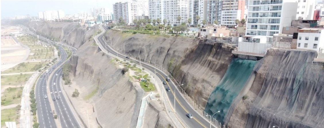
Figura 132. Vista hacia el terraplén construido como vía de acceso.
