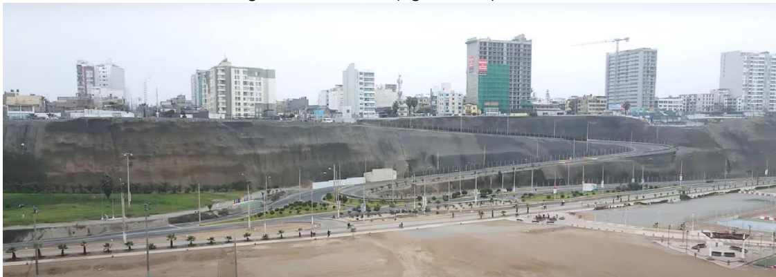
Figura 117. Vista hacia el terraplén construido como vía de acceso.
