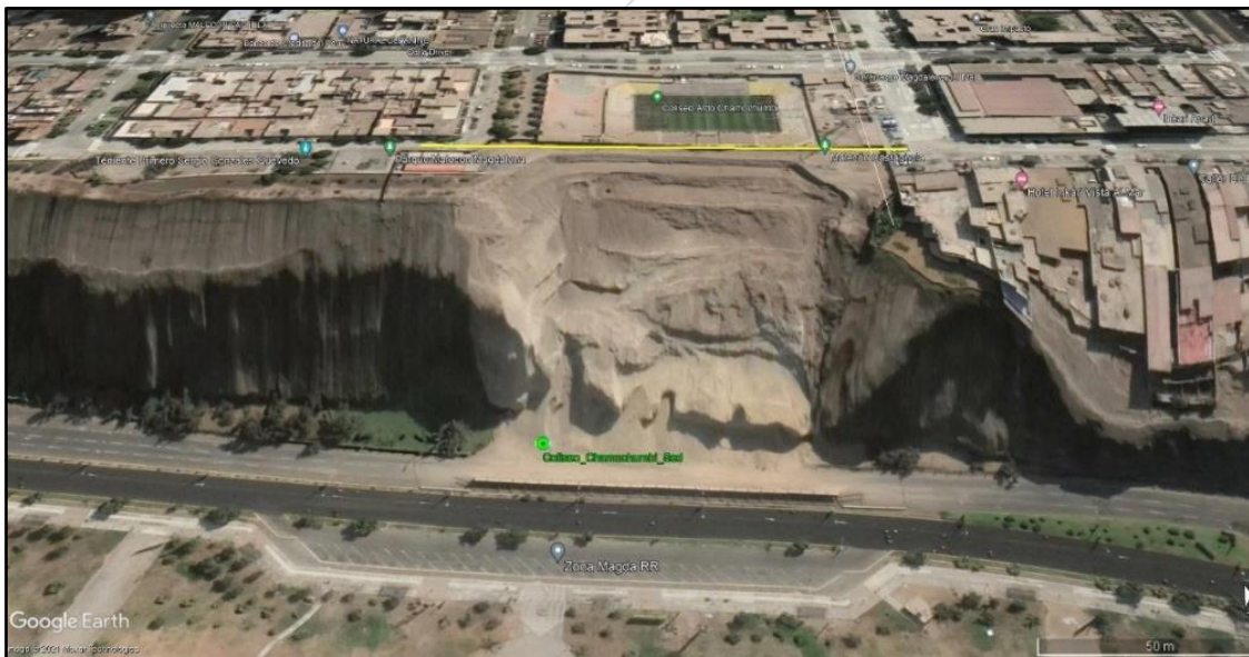
Figura 35. Foto del Acantilado de la Costa Verde y ubicación de la Línea Sísmica de Refracción RS04-MG a la altura del Coliseo Chamochumbi en el distrito de Magdalena (Tomado de IGP, 2021).
