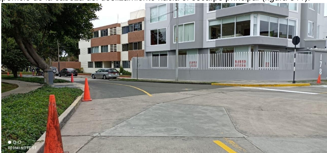
Figura 311. Vista de una potencial zona de deslizamiento próxima al parque de La Pera.
