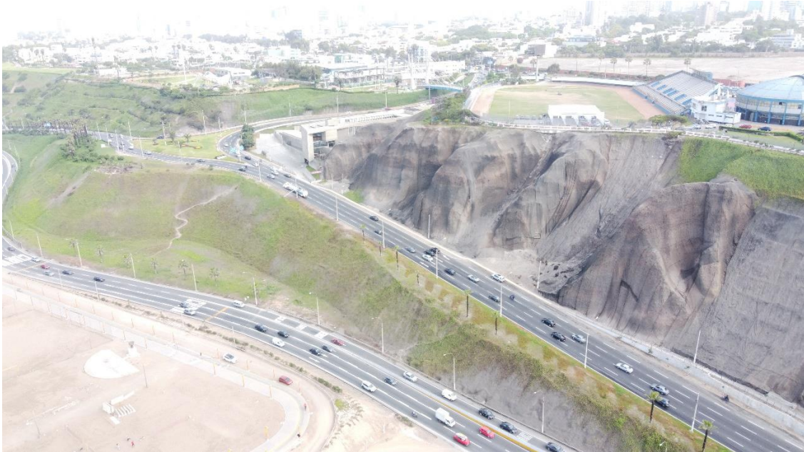
Figura 164. Bajada hacia playa Los Delfines, terraplén realizado por corte y relleno del acantilado de la Costa Verde en el distrito de Miraflores.
