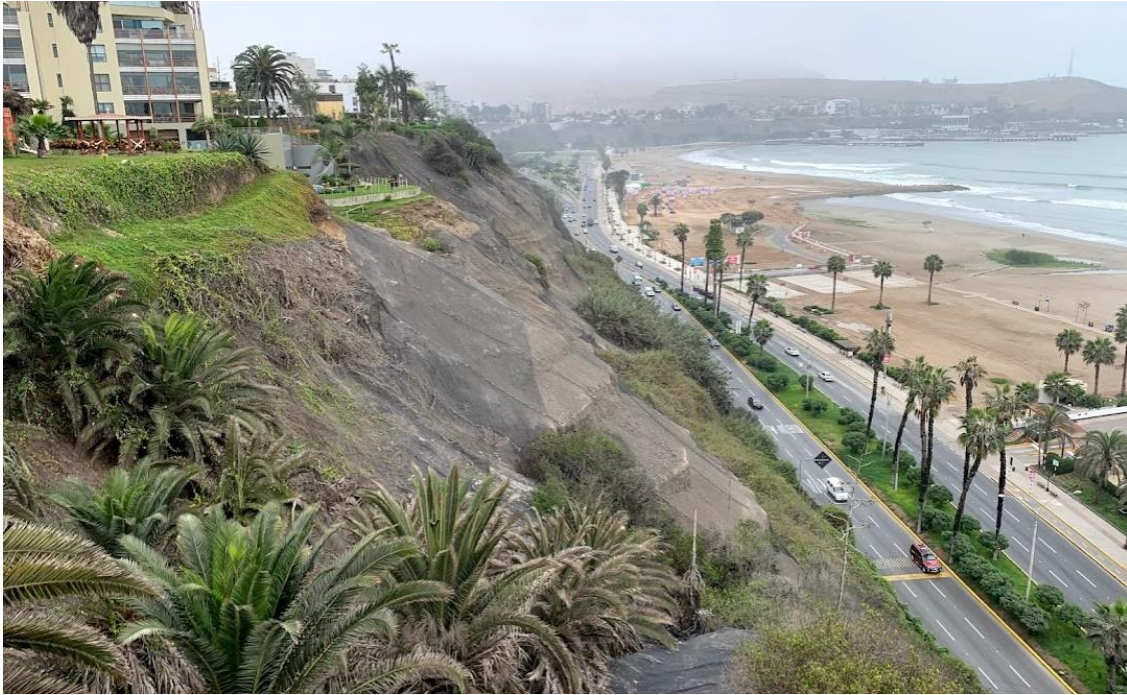
Figura 344. Derrumbes en las inmediaciones de Lima Marina Club y Playa Los Yuyos en el distrito de Barranco.
