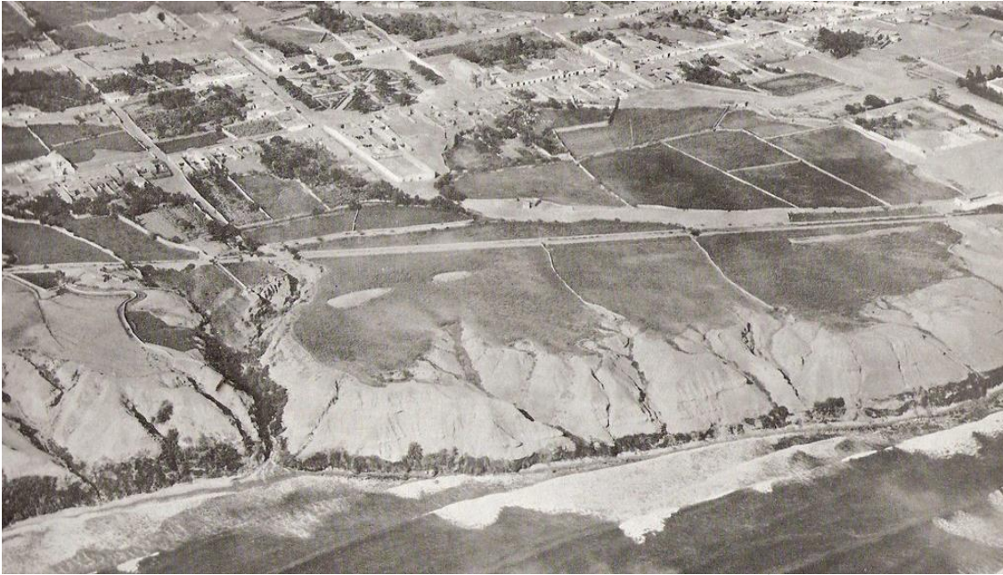
Figura 339. Zonas de cárcavas y surcos en el acantilado de la Costa Verde, que erosionan hasta la planicie aluvial hasta el pie del acantilado en el distrito de Barranco.
