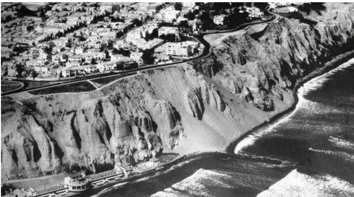
Figura 319. Vista hacia la bajada Balta donde se observan derrumbes en el borde del acantilado.
