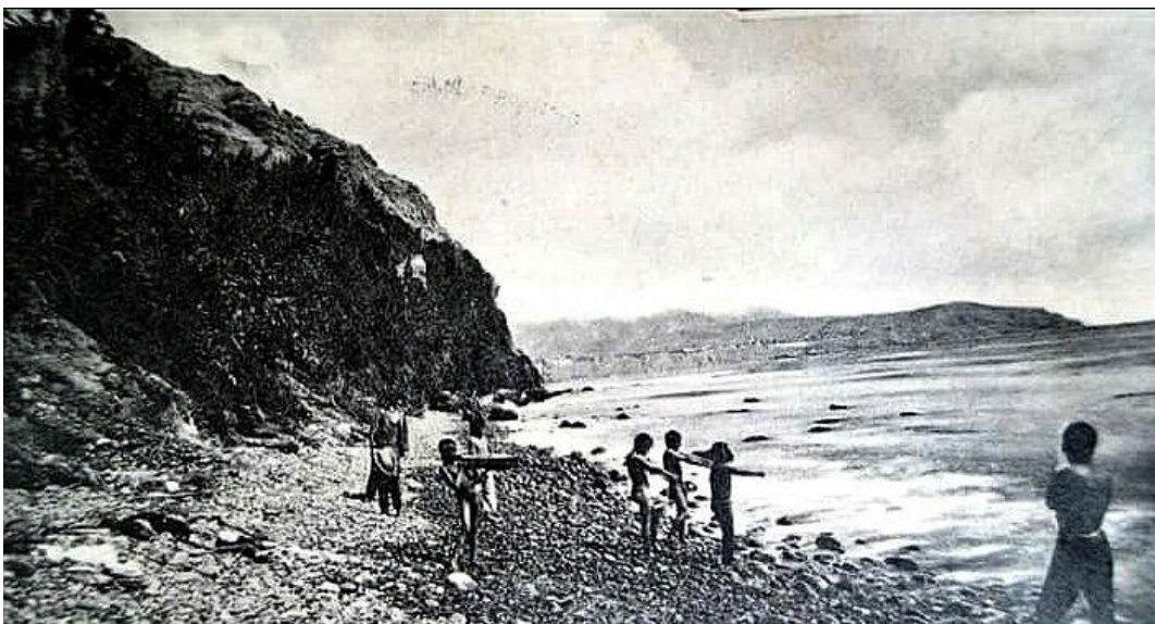
Figura 337. Zonas de derrumbes en el acantilado del distrito de Barranco, donde se observan pendientes muy escarpadas.
