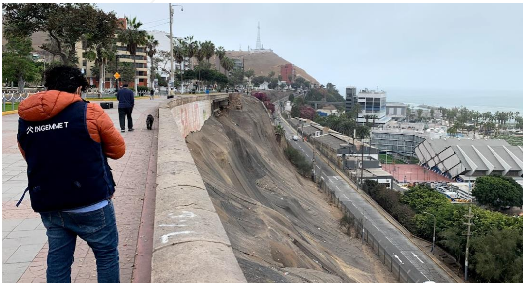
Figura 368. Pase aéreo sobre derrumbe reciente en Malecón de Chorrillos.
