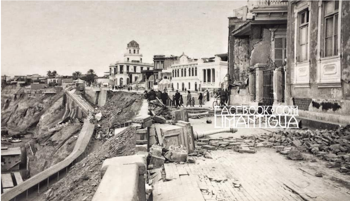
Figura 190. Depósitos antrópicos producto del sismo de 1940. Fuente: https://www.facebook.com/limantigua .
