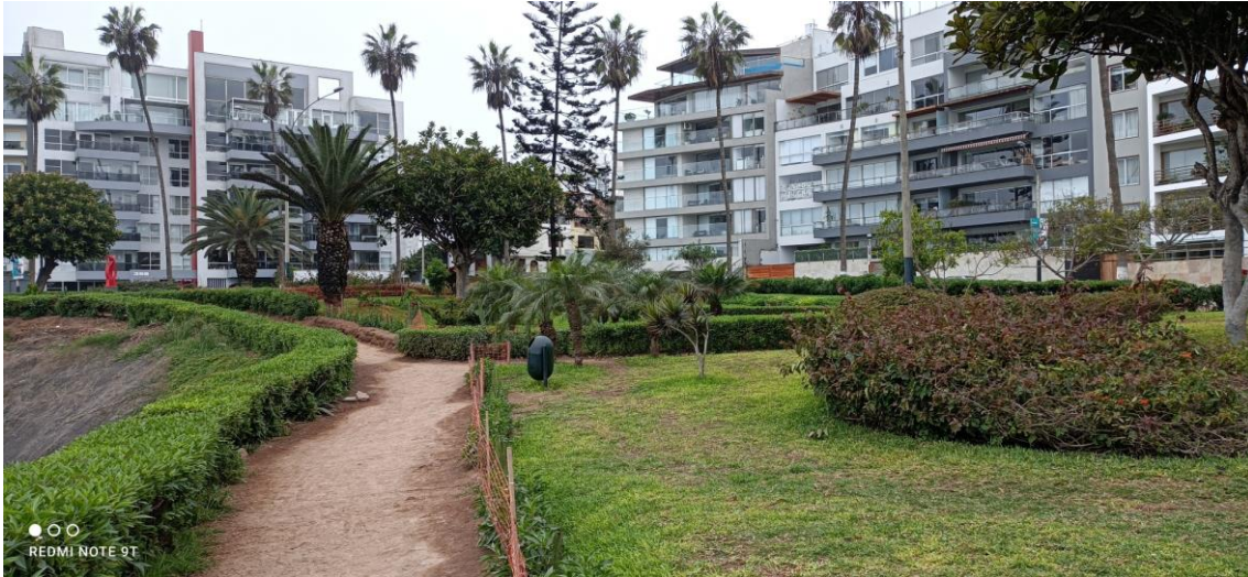
Figura 349. Vista hacia una potencial zona de deslizamiento rotacional.
