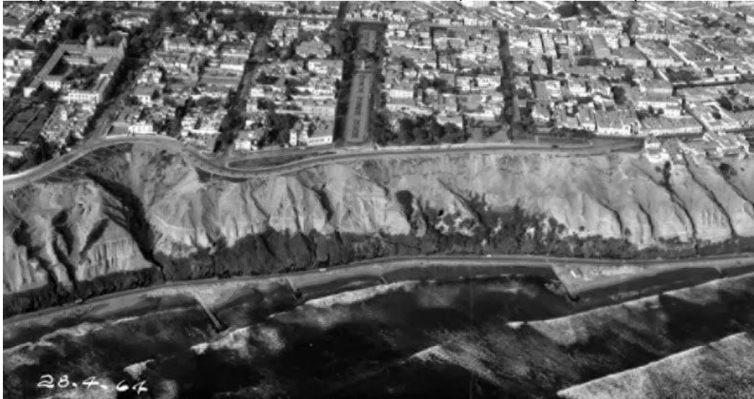
Figura 175. Cárcavas en el acantilado del distrito de Barranco en el año 1964. Fuente: SAN.
