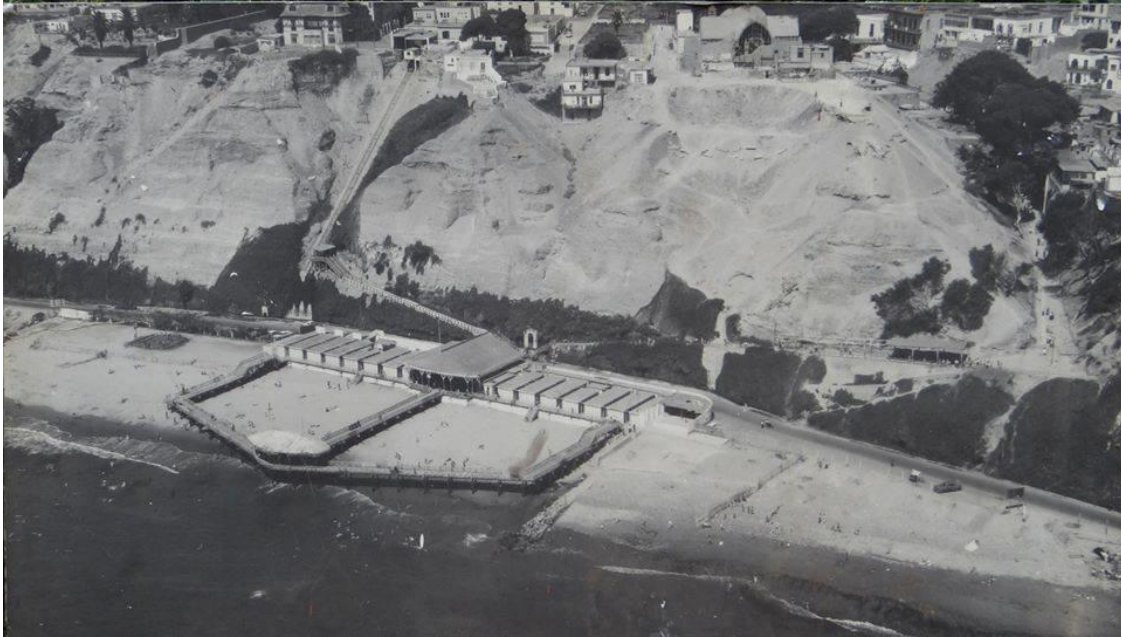
Figura 338. Zonas de probables deslizamientos y derrumbes en el acantilado del distrito de Barranco, altura de Bajada de Baños.
