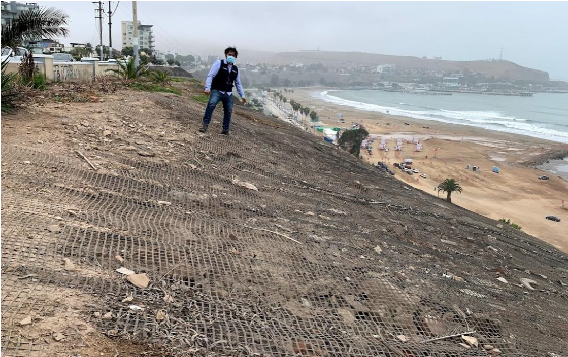
Figura 366. Vista hacia el sur de parque en Malecón Costa Sur ubicado sobre relleno antrópico reciente que se encuentra cubierto por geomalla.
