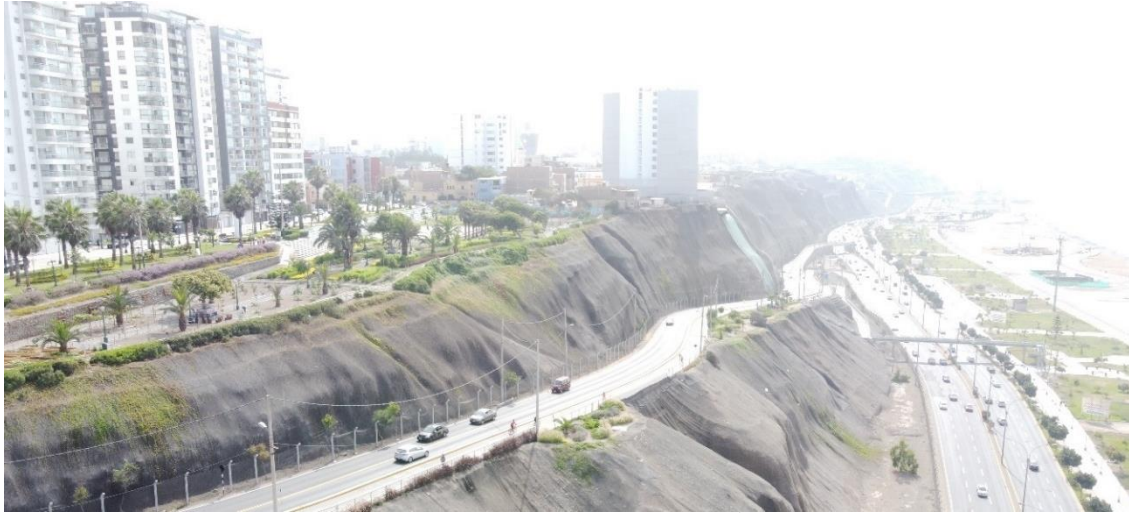
Figura 129. Bajada hacia la Av. Brasil que conecta la planicie donde se ubica el área urbana del distrito de Magdalena con la parte baja del acantilado.
