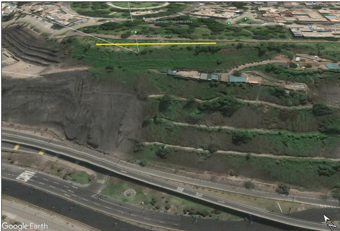
Figura 39. Foto del Acantilado de la Costa Verde y ubicación de la Línea Sísmica de Refracción RS09-MG en el distrito de San Isidro muy cerca al límite distrital con Magdalena (Tomado de IGP, 2021).
