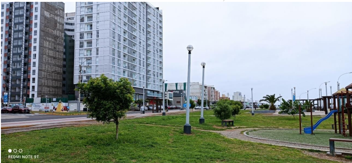
Figura 267. Vista de un potencial deslizamiento rotacional a la altura del parque Pedro Planas Silva.
