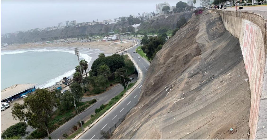
Figura 369. Rellenos antrópicos recientes cubiertos por geomalla.
