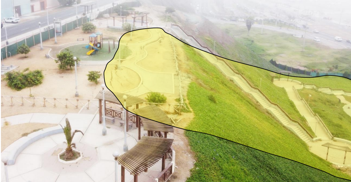
Figura 264. Potencial deslizamiento de tipo rotacional entre los Parques Belén y Wallenberg.
