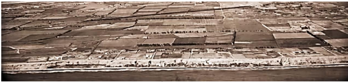
Figura 253. Vista aérea del distrito de San Miguel, se distinguen zonas de grandes cárcavas al borde del acantilado. Fuente: SAN.
