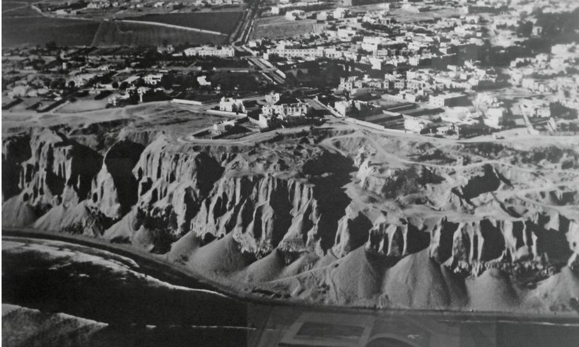
Figura 321. Vista hacia el acantilado donde se observan cárcavas y surcos en el distrito de Miraflores.
