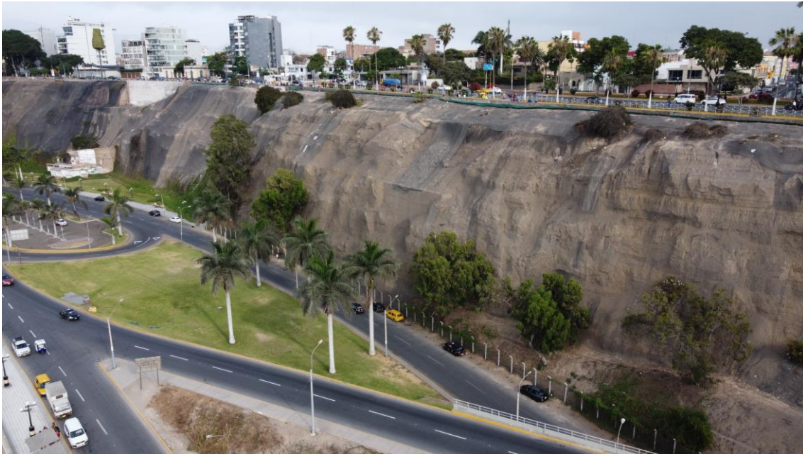
Figura 371. Vista aérea de los escarpes proyectados ubicados en el borde del acantilado, estas zonas delimitan potenciales zonas inestables.
