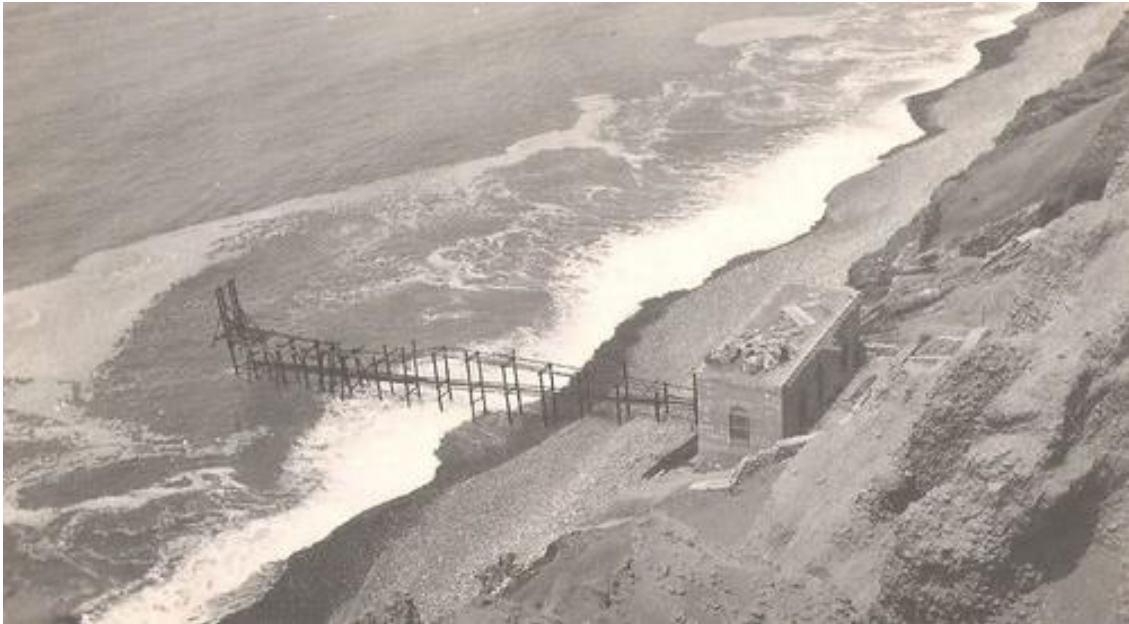
Figura 251. Sistema de bombeo de agua hacia la piscina municipal actual Casa de la Cultura de San Miguel, donde se depositaban los materiales provenientes de deslizamientos y derrumbes. Fuente: Gallese (1913).
