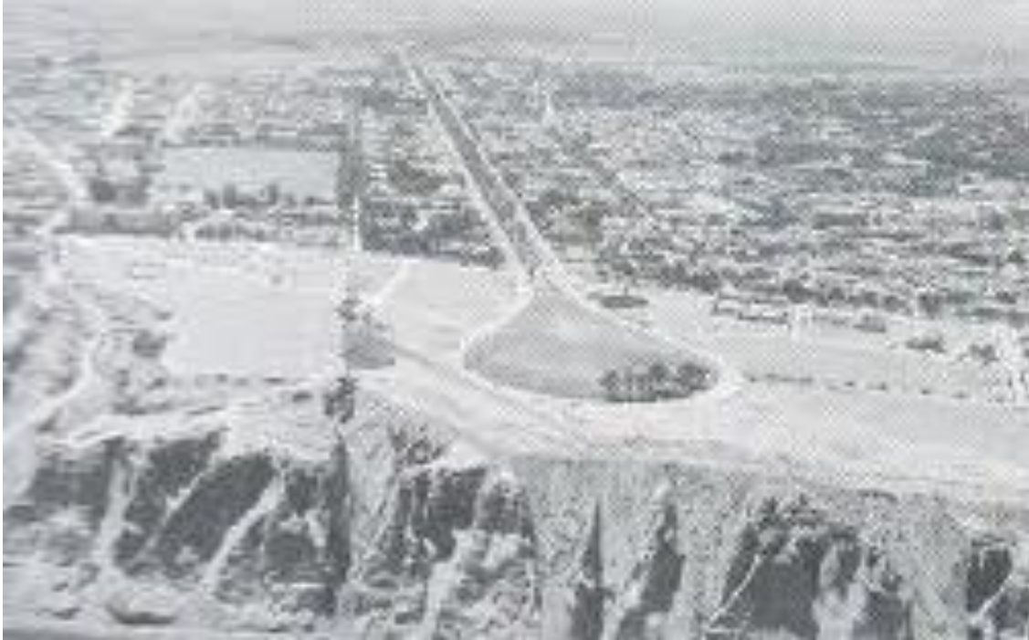
Figura 302. Parque La Pera en el distrito de San Isidro donde se identifican deslizamiento derrumbes. Fuente: SAN (1943).
