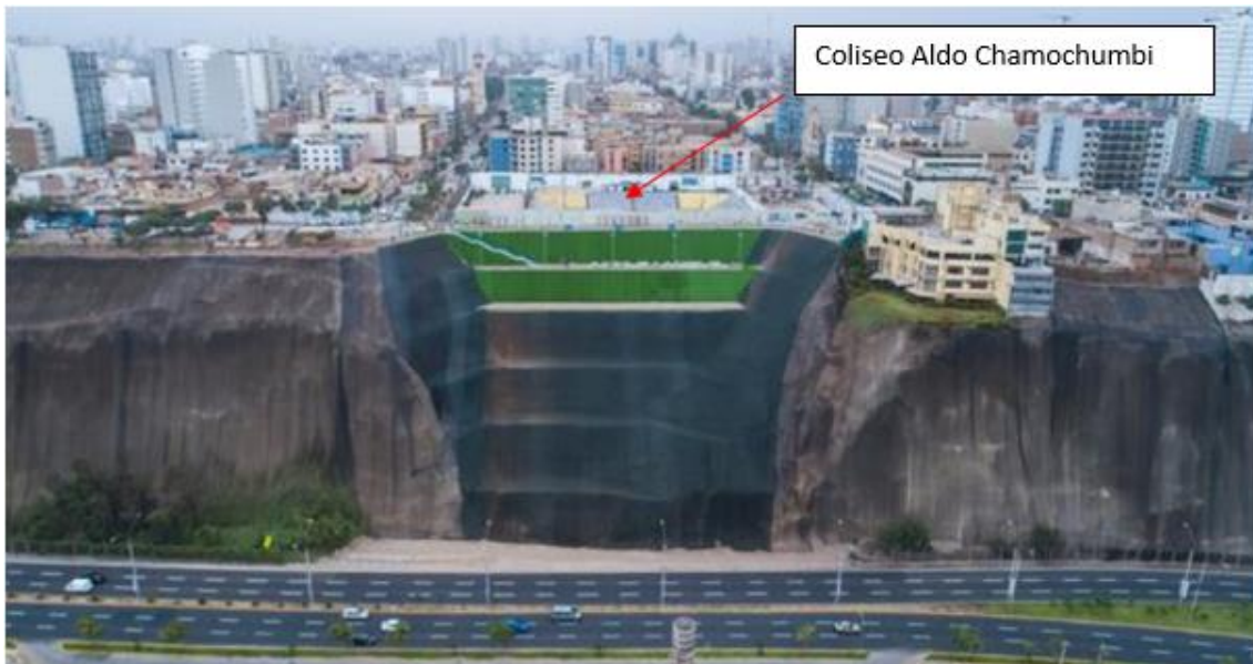
Figura 293. Vista frontal de andenes en malecón Castagnola. Fuente: Perú 21.
