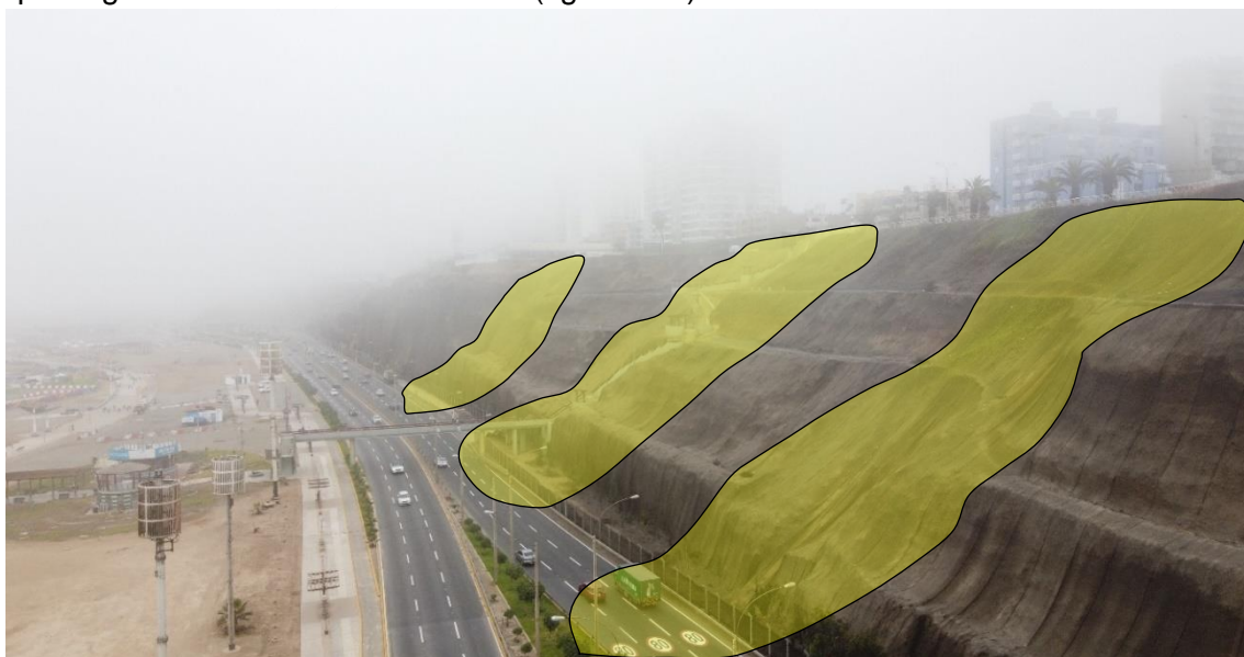
Figura 271. Vista hacia el circuito de playas a la altura del Parque Media Luna. En esta zona de han proyectado varios deslizamientos-derrumbes.
