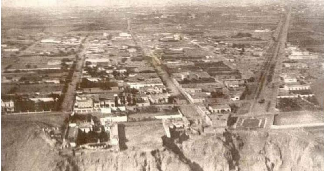
Figura 279. Vista hacia la Av. Brasil, se observan procesos de erosión de laderas en la parte superior del talud.
