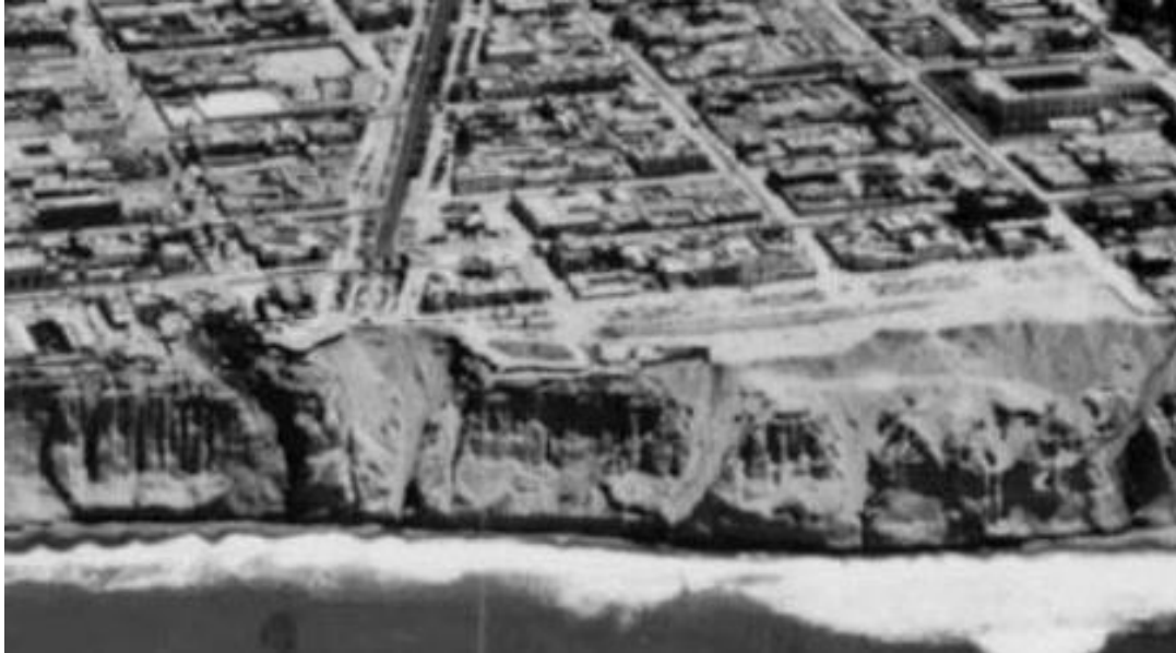
Figura 126. Vista hacia la antigua Av. Brasil donde se observan cárcavas en el distrito de Magdalena.
