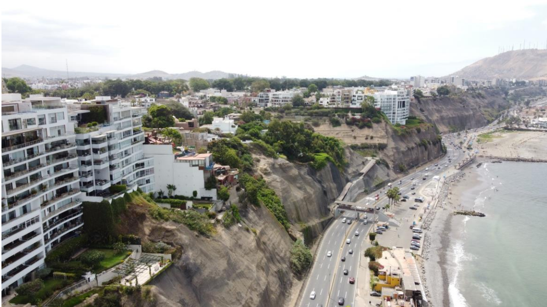
Figura 350. Vista hacia la Bajada de Baños donde se identificaron 4 deslizamientos-derrumbes evidenciados en grietas semicirculares ubicadas en la parte alta del acantilado.
