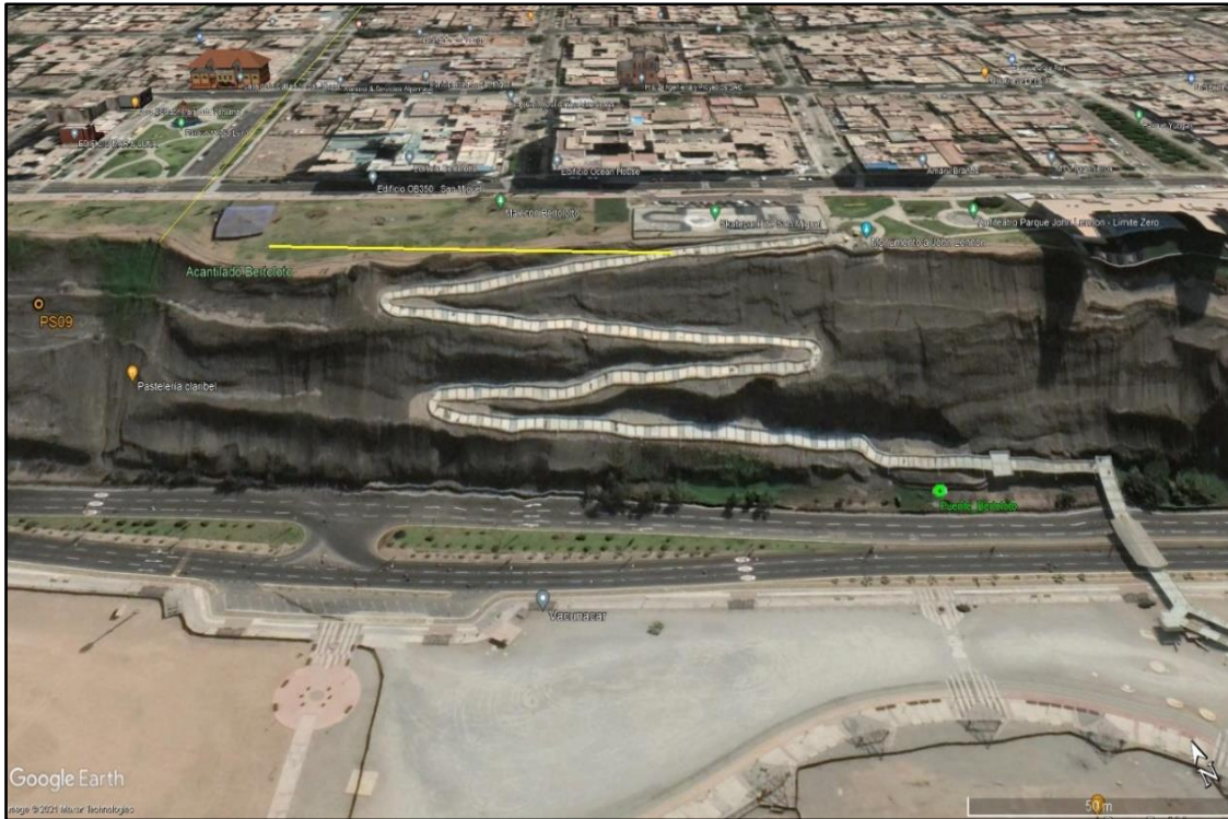
Figura 33. Foto amplia del Acantilado de la Costa Verde y ubicación de la Línea Sísmica de Refracción RS07-SM a la altura del Puente Bertolotto en el distrito de San Miguel (Tomado de IGP, 2021).
