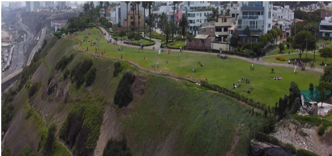
Figura 312. Vista hacia la zona de un probable deslizamiento con fase de derrumbe.
