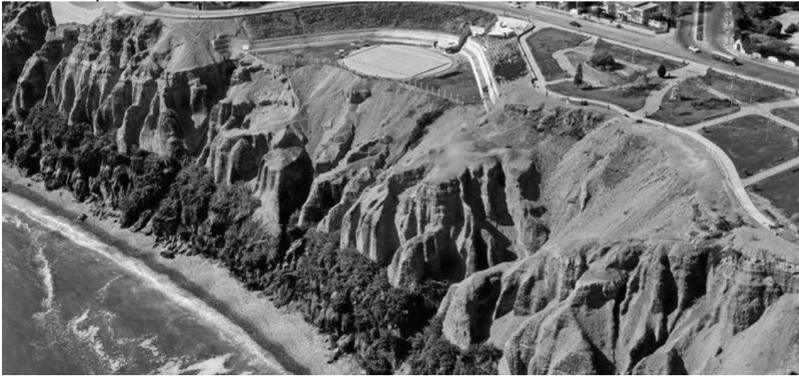
Figura 158. Cárcavas y surcos entre el Parque Salazar y Larcomar (SAN).
