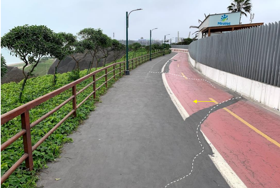
Figura 329. Escarpa de deslizamiento generado sobre rellenos antrópicos, parte posterior del complejo deportivo Manuel Bonilla.
